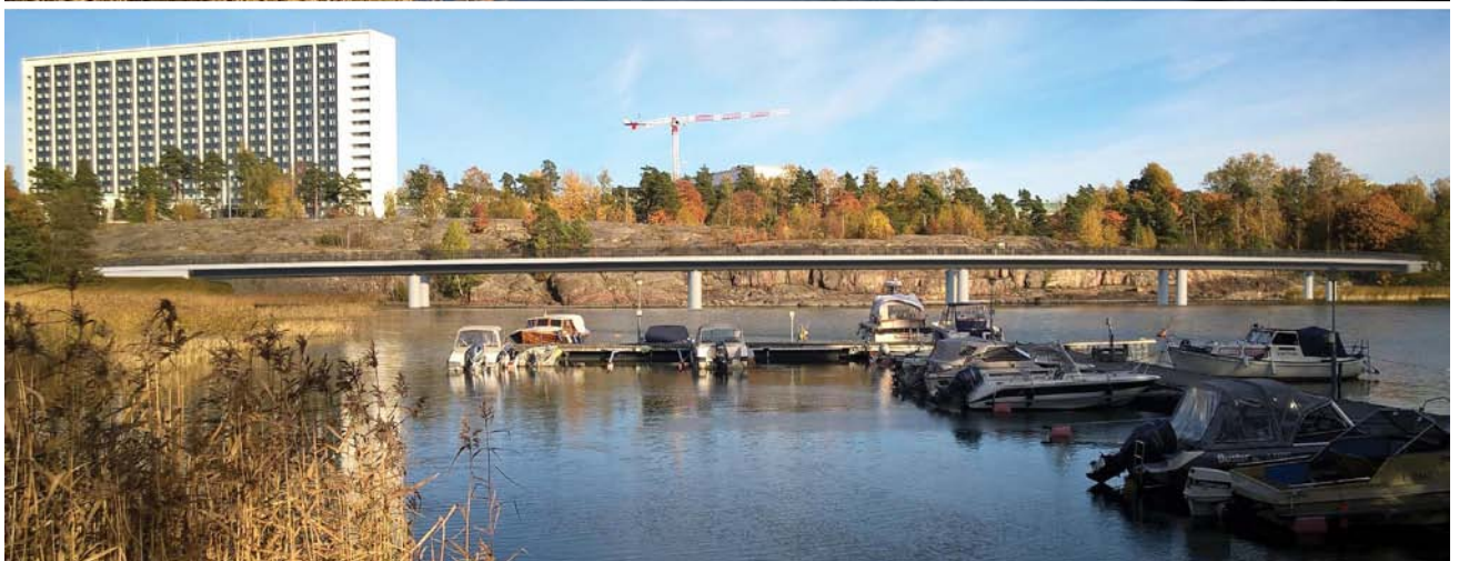
Kuva 32. Noin tasossa +4...+5 kulkeva silta Humallahden yli, lyhyemmällä ja pidemmällä pilarivälillä. Kuvassa esitetty korkeusase- ma on maiseman kannalta epäedullinen. Alempi taso on maisemallisesti perusteltu ratkaisu (vrt. kohta 2.3.3 kuvat), mutta koko rantaosuuden pituiselta sillalta rannan toiminnalliset yhteydet ovat hankalasti toteutettavissa.
