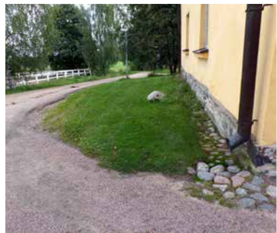
Mymälänä toimivan kartanon sivurakennuksen pohjoispäässä kattovedet ja talouspihalta valuvat hulevedet ovat syövyttäneet eroosiouoman Weckströminpolun reunaan. RT
