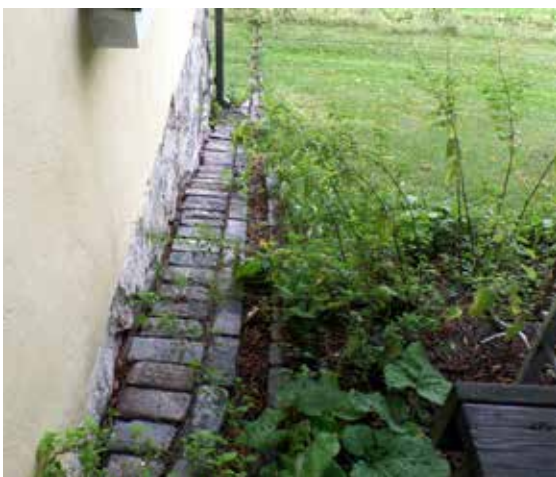
Aikaisemmin ravintolana toimineen kartanon sivurakennuksen eteläpäässä oleva noppakivivesikouru on täyttynyt roskista. RT
