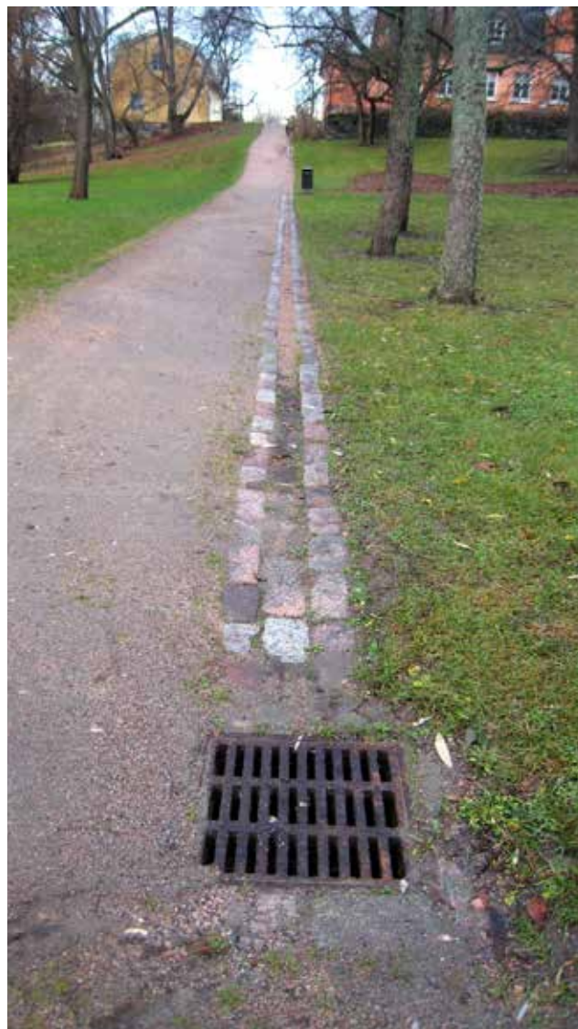
Kartanopuutarhan puistokäytävää reunustava nupukivikouru päättyy hulevesikaivoon. Syyskuussa 2014 otetussa kuvassa hulevedet eivät ole pysyneet nupukivikourussa. Ne ovat virranneet puistokäytävällä kourun vieressä, mikä on syövyttänyt pahasti käytävän pintaa. TP, RT
