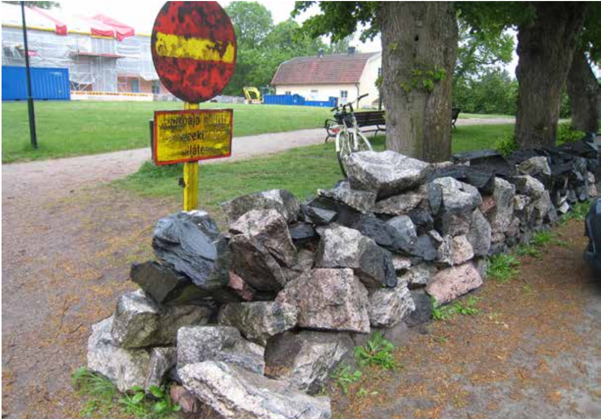
Miespihaa rajaava kiviaita on huonokuntoinen. Sen korjaamisessa on käytettävä työvoimaa, jolla on riittävä kokemus vastaavanlais-
