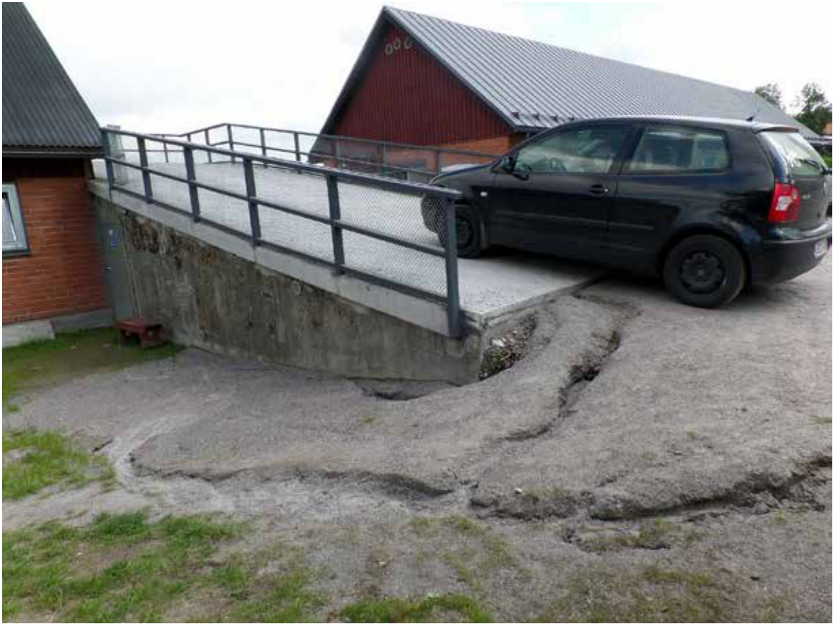
Tuomarinkylän Tallin pohjoisemman tallirakennuksen tallisillalta ja Kavaleffintieltä melko hallitsemattomasti valuvat hulevedet ovat syövyttäneet eroosiouria maanpintaan. RT
