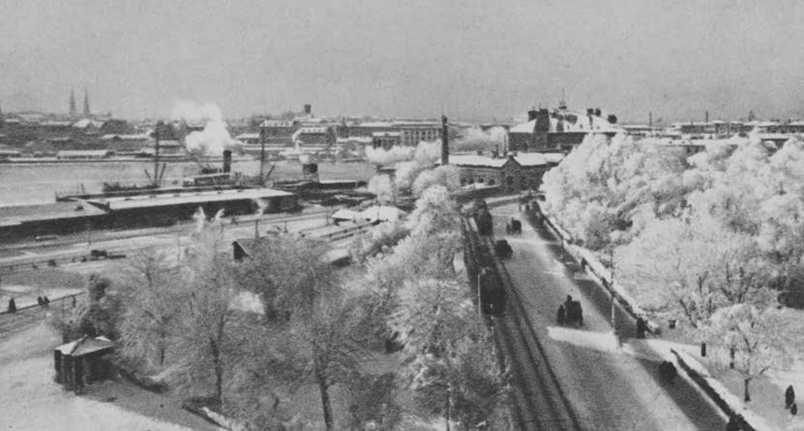
Yllä: Viistokuva Luotsikadulle ja Katajanokanpuistoon todennäköisesti 1930-luvulla. MVKA
