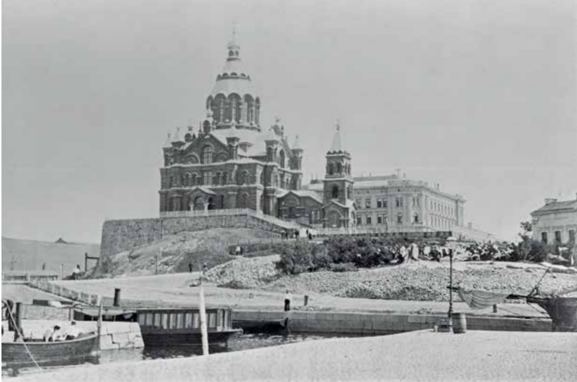
Näkymä Eteläsatamasta Katajanokalle 1890-luvulla. Myöhemmin näkymä on osit-
