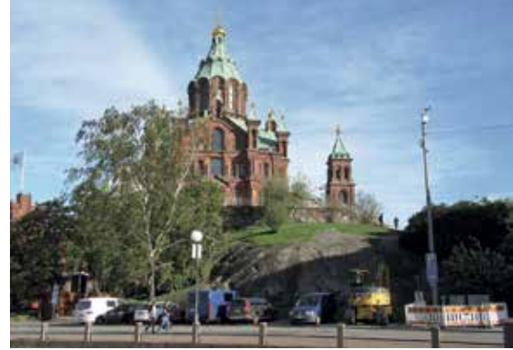
Näkymä Katajanokan sillalta kohti Kanavapuistoa. Puiston edustalla on pysäköintialue. Kuvassa vasemmalla maanalaisten tilojen sisäänkäynti. KT
