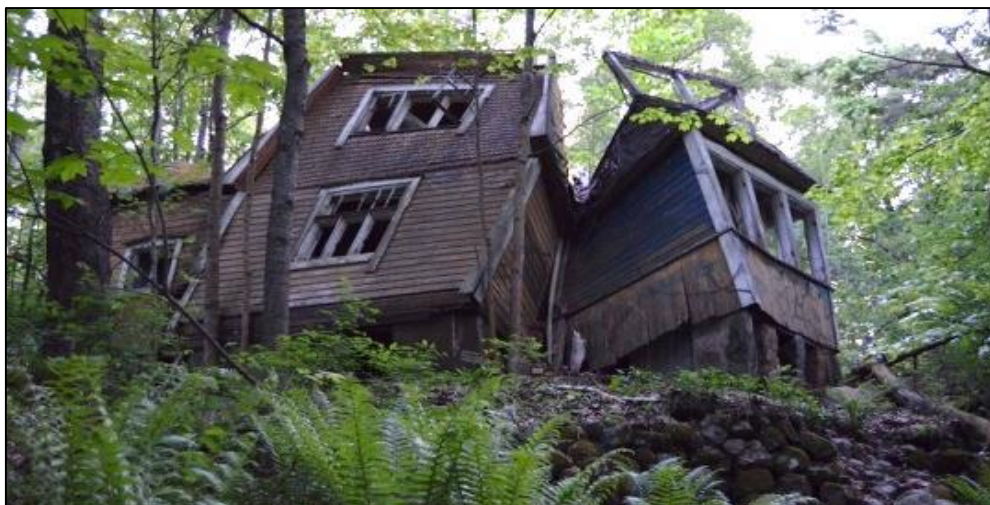
Kuva 2. Kruunuvuoren metsäalueella ollut osittain romahtanut huvila.
