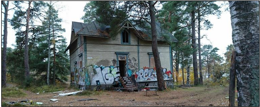
Kuva 12. Hällobon huvila Kruunuvuoren metsäalueella on jätetty purkamatta. Huvilassa ei ole ehjiä ikkunoita eikä ovia ja sisällä on tehty paljon ilkivaltaa.
