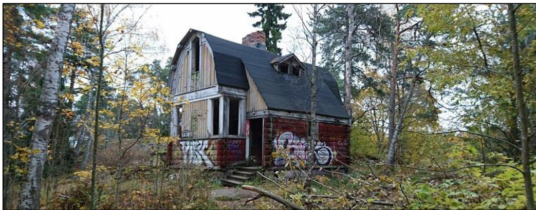
Kuva 13. Toinen Kruunuvuoren metsäalueella purkamatta jätetty huvila. Huvilassa ei ole ehjiä ikkunoita eikä ovia ja sisällä on tehty paljon ilkivaltaa.
