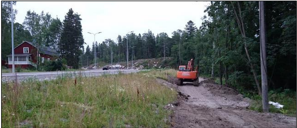
Kuva 16. Tahvonlahden ja uuden katualueen välinen alue kesällä 2016, jolloin sinne rakennettiin uusi kävelytie.
