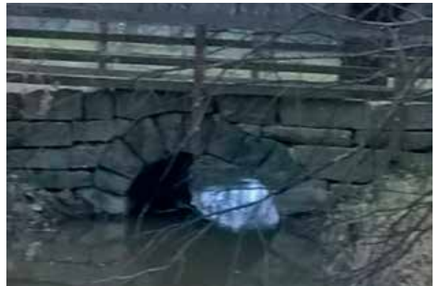
Kuva 9. Kauppalanpuiston 1800-luvun loppupuolella rakennettu Turun maantien kivililta, joka on suojeltu asema-kaavalla. Kuvaushetkellä purosso oli tavanomainen virtaama (ei edeltävää sadetta lähipäivinä). Silta-aukko on noin kaksi metriä leveä ja vapaan aukon korkeus on noin metri.
