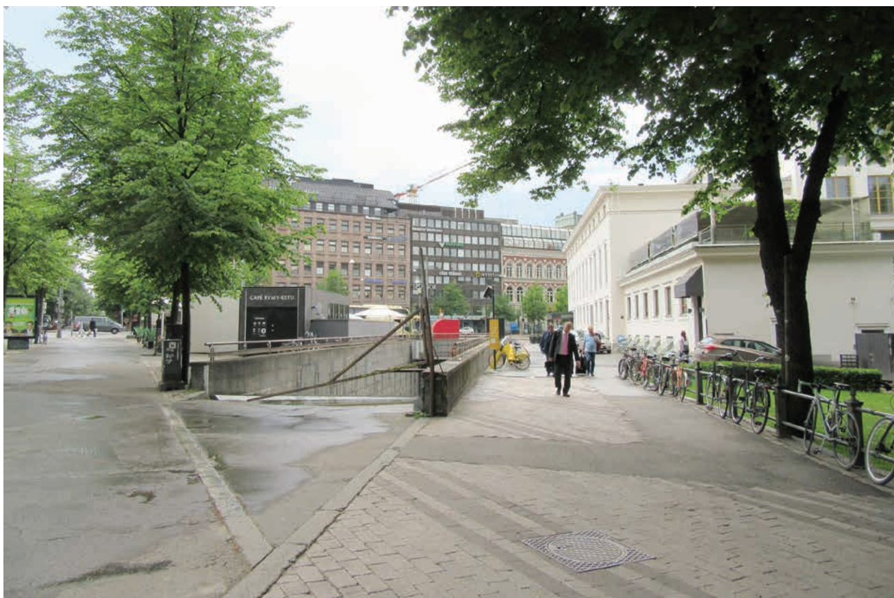
Kuva 50. 1960-luvun lopussa rakennettu ajoluis-ka on poistunut käytöstä. TP 2016.
