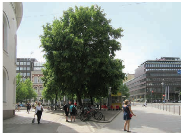
Kuva 64. Teatterin luoteispuolella sijaitsevan lehmusryhmän alla oleva korotettu istutusalue on muutettu sorapintaiseksi. TP 2016.
