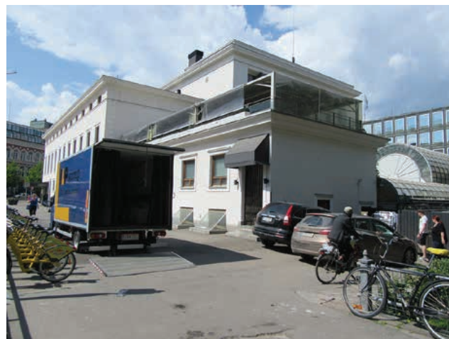
Kuva 49. Teatterin huoltoajo on asemakaavassa osoitettu rakennuksen eteläseinustalle. Huoltoajon lisäksi alueelle pysäköi luvottomasti usein henkilöautoja. Vasemmassa laidassa oleva kaupunkipyörien pysäköintialue asennettiin toukokuussa 2016. TP 2016.
