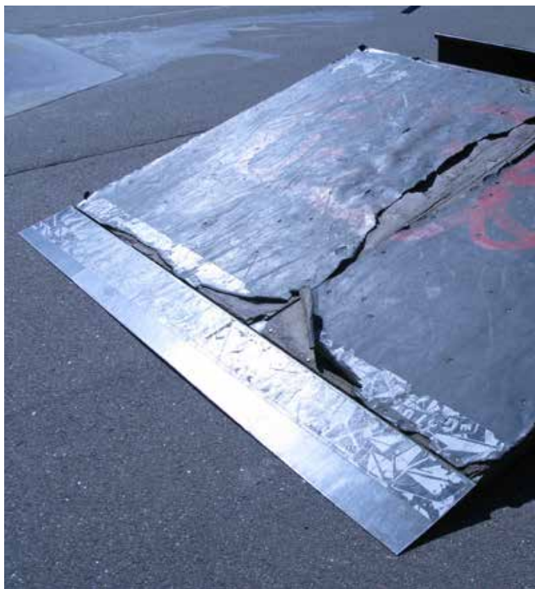
Oikealla: Vaneriset obstaakkelit ovat vaarallisen huonossa kunnossa.
