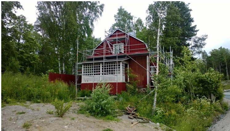
Kuva 20. Kaivoshuvilan maalaustyö on melkein valmis.
