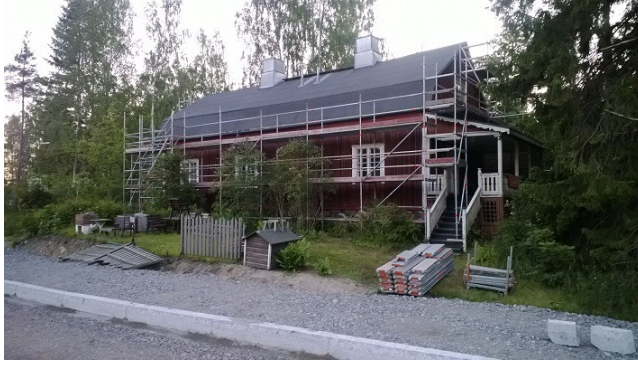
Kuva 19. Kaivoshuvilan ympärille asennettiin rakennustelineitä kesäkuun lopussa.
