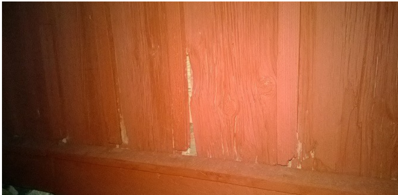
Kuva 6. Nuoli osoittaa Kaivoshuvilan eteläseinässä olevaa rakoja, josta näki laudoituksen takana olevia lepakoita.
