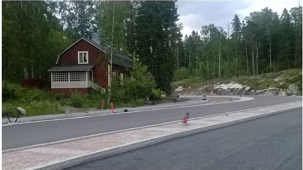
Kuva 1. Uusi Koirasaarentie Kaivoshuvilan eteläpuolella kesäkuussa 2015.
