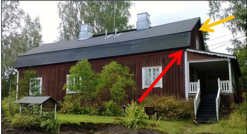
Kuva 4. Kaivoshuvilan kaakkoisnurkassa oleva lepakoiden käyttämä kolo (punainen nuoli) ja itäpäädyssä olevat lepakoiden käyttämät raot (keltainen nuoli).
