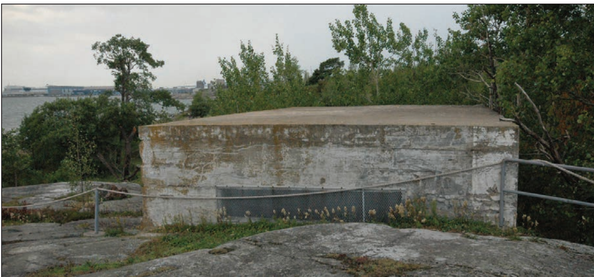
Kuva 4. Bunkkerin katto kaakosta päin kuvattuna. (ST)
