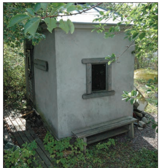
Kuva 11: Vanha pumppuasema (ST)
