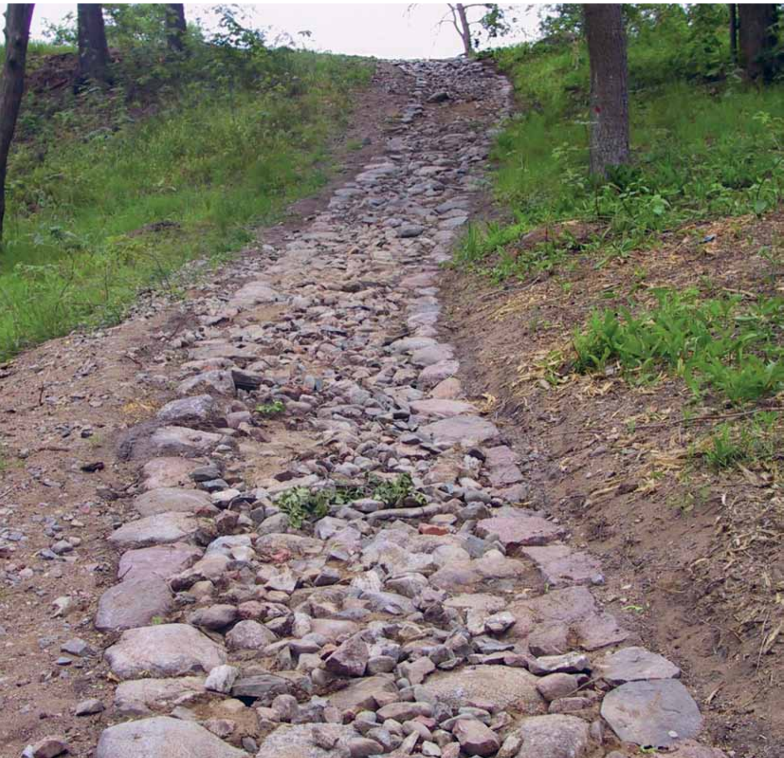
Kuva 69. Eräs Tullisaaren vanhojen puistokäytävien pohjista. Jos vanhan käytävän päällä ollut multakerros on hyvin ohut, eräät rikkaruohot ovat voineet tunkea juurensa sen läpi alempiin maakerrokseen. Rakennetta ei saa peittää savella ennen kuin ne on saatu lopullisesti poistetuksi. Tiina Perälä.
