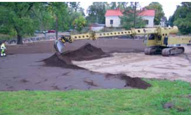
Kuva 51. Seulotun mullan levitystä Nordsjön kartanopuistossa tela-Gradall-kaivinkoneen avulla. Levitykseen voi käyttää myös hiekanlevitintä tai golfkenttien hoidossa käytettäviä maa-aineksen pintalevittimiä. Koneet säädetään tällöin läpäisemään seulottua siempankkimaa-ainesta. Anna Malinen.
