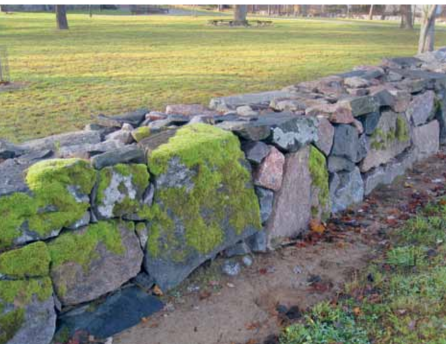
Kuva 84. Sama kiviaita kunnostuksen jälkeen vuonna 2011. Kivien välissä on käytetty pieniä kiviä, joilla muurin kivet on kiilattu liikkumattomasti. Kiilakiviä on käytetty erityisesti suurempien kivien väleissä sisältä päin asennettuina. Jatkuvia suoria saumoja on vältetty ja kivet on pyritty latomaan siten, että syntyy vain kolmen sauman risteyskohtia. Matti Liski.
