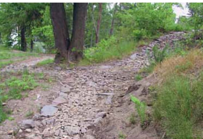
Kuva 72. Vanhojen puistokäytävien perustukset löytyivät Tullisaaressa välittömästi niitä peittäneiden uudempien ja suhteellisen ohuiden maakerrosten alta. Kuvan käytävät on aikoinaan perustettu Aino Acktén huvilan alapuolella olevaan rinteeseen. Tiina Perälä.
