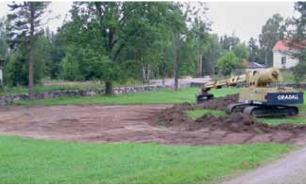
Kuva 50. Nordsjön kartanopuiston nurmikon tasoa jouduttiin eräällä alueella nostamaan noin 30 cm. Muuten nurmikko olisi jäänyt liian alas suhteessa ympäröivään maisematilaan, jonka taso nousi melko paljon taustalla näkyvien uusien tiejärjestelyiden takia. Ennen nurmikon tason nostamista sen pintakerros kuorittiin ja seulottiin. Seulottu multa levitettiin tasauksen jälkeen uudelleen puistoon. Näin vanha nurmikkokasvillisuus saatiin säilytetyksi. Anna Malinen.
