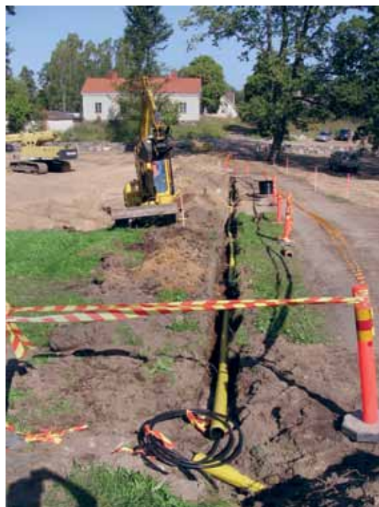
Kuva 25. Nordsjön kartanopuiston pääkäytävän vierelle kaivettiin ura valaistuskaapelia varten, sillä sen sijoittaminen käytävän alle olisi tuhonnut vanhan käytävärakenteen. Anna Malinen.
