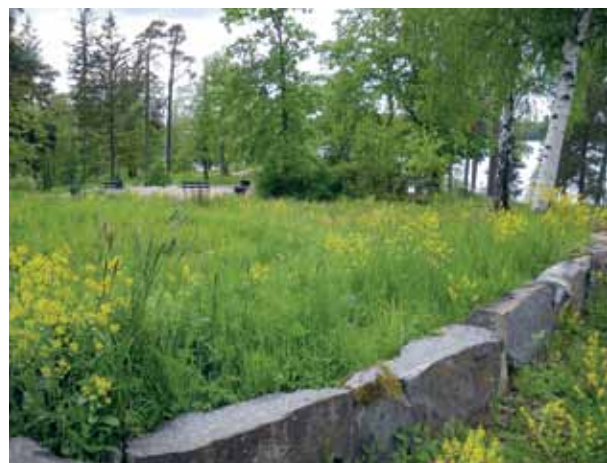
Kuvat 13, 14 ja 15. Matala, kylmämuurattu luonnonkivinen tukimuuri ladottiin suurimmaksi osaksi uudelleen vanhoja kiviä käyttäen. Muuria ladotaan uudelleen – ylin kuva; vastakunnostettu muuri – keskimäinen kuva; kunnostetun muurin ympäristö kukkii kauniisti – alin kuva. Kaksi ylintä kuvaa ovat vuodelta 2010, ja alin kuva on vuodelta 2012, Tullisaari. Laura Kauhanen, Jenni Börk ja Pepita Palonen.
