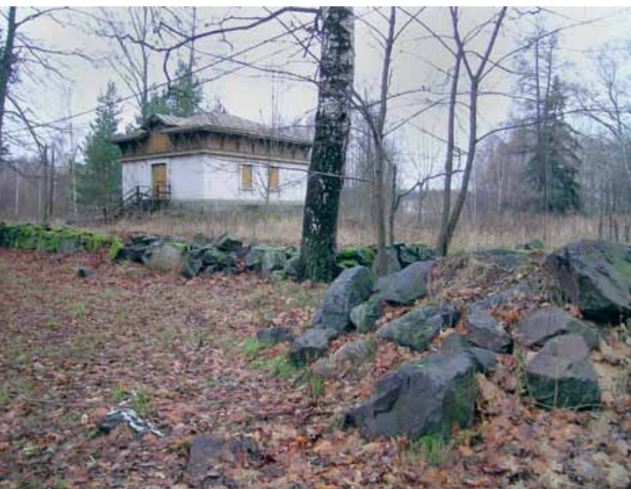
Kuva 83. Osa Nordsjön kartanopuiston kiviaidan kulmasta oli päässyt sortumaan (kuva vuodelta 2006) ennen puiston kunnostusta, vrt. kuva 6 (kiviaita kunnostuksen jälkeen). Matti Liski.
