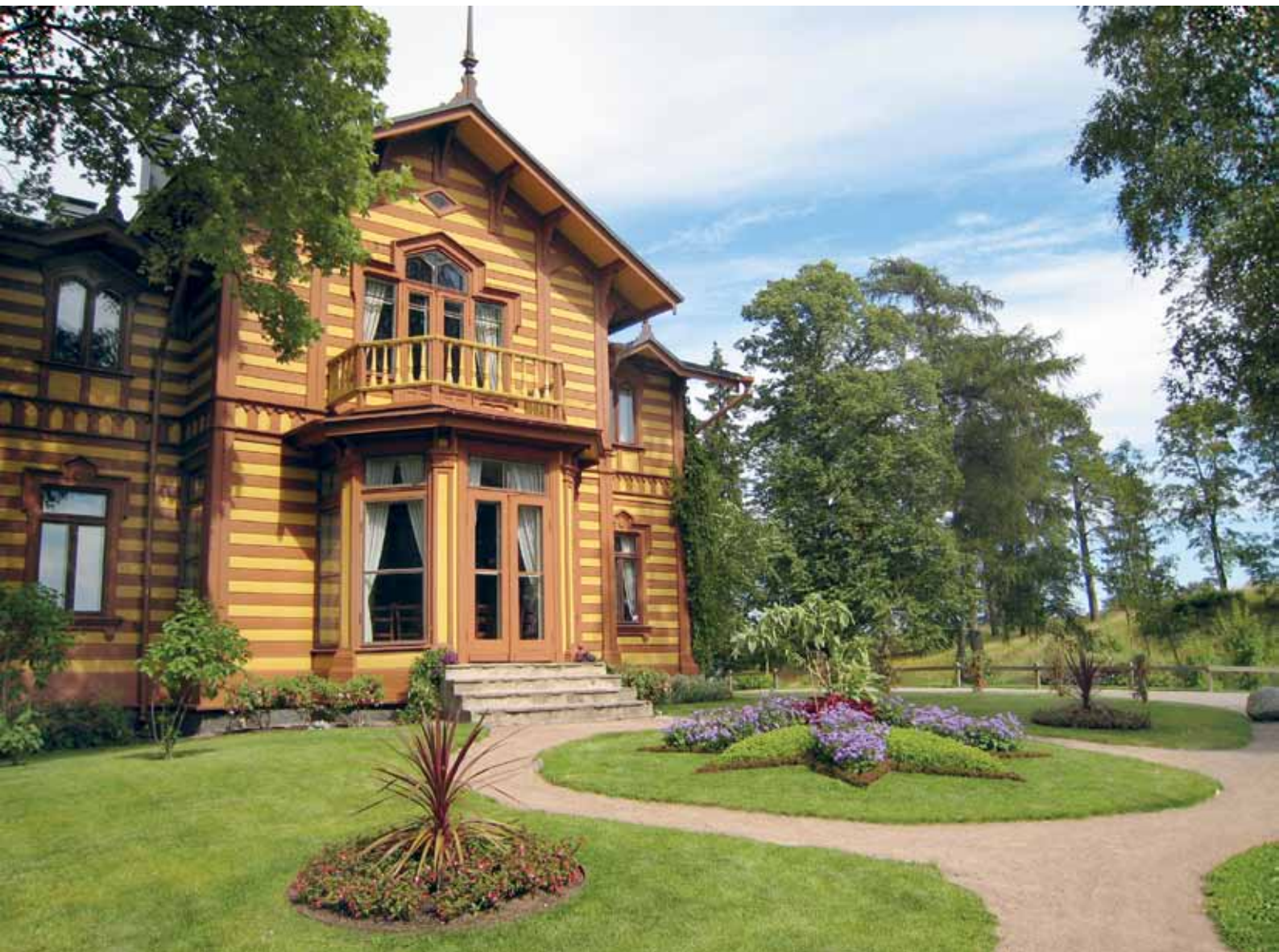
Kuva 48. Taustalla olevalla rinteelle levinnyttä vesakkoa on raivattu, käytäväverkosto on otettu esiin ja kasvillisuussommitelmat palautettu; rakennuksen seinustalle istutut kasvit ovat tässä vuonna 2008 otetussa kuvassa kuitenkin vielä niin pieniä, että ne eivät luo samaa rehevyyden vaikutelmaa kuin kuvassa 44. Kukkaryhmien kasvilajit vaihtelevat vuosittain. Ne valitaan kasveista, joita käytettiin 1800-luvun lopun ja 1900-luvun alun kuvioistutuksissa. Matti Liski.
