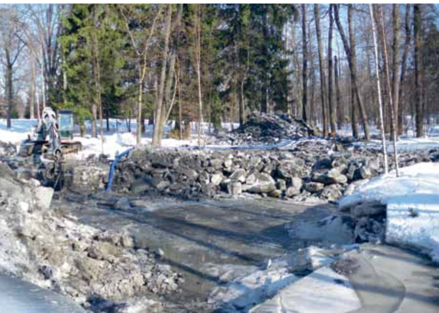
Kuva 80. Herttoniemen puiston lammet ruopattiin talvella. Ne pumpattiin tyhjiksi, minkä jälkeen sakka poistettiin pohjalta. Pepita Palonen.
