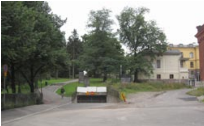
Ajoramppi maanalaisiin tiloihin Fabianinkadun eteläpäässä
