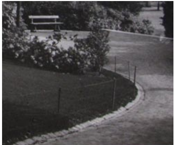
Käytävän reunakoulu ja kevyt suoja-aita Signe Brander 1912 / HKM (yksityiskohta)
