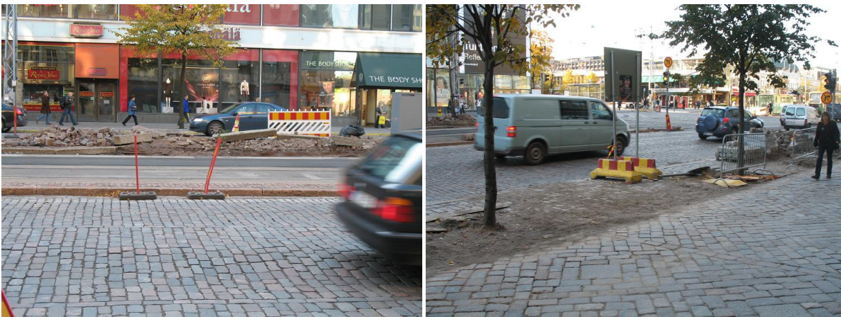
Kuva 3. Jo loppusuoralla olevia rakennustöitä Forumin edessä molemmin puolin Mannerheimintietä.
