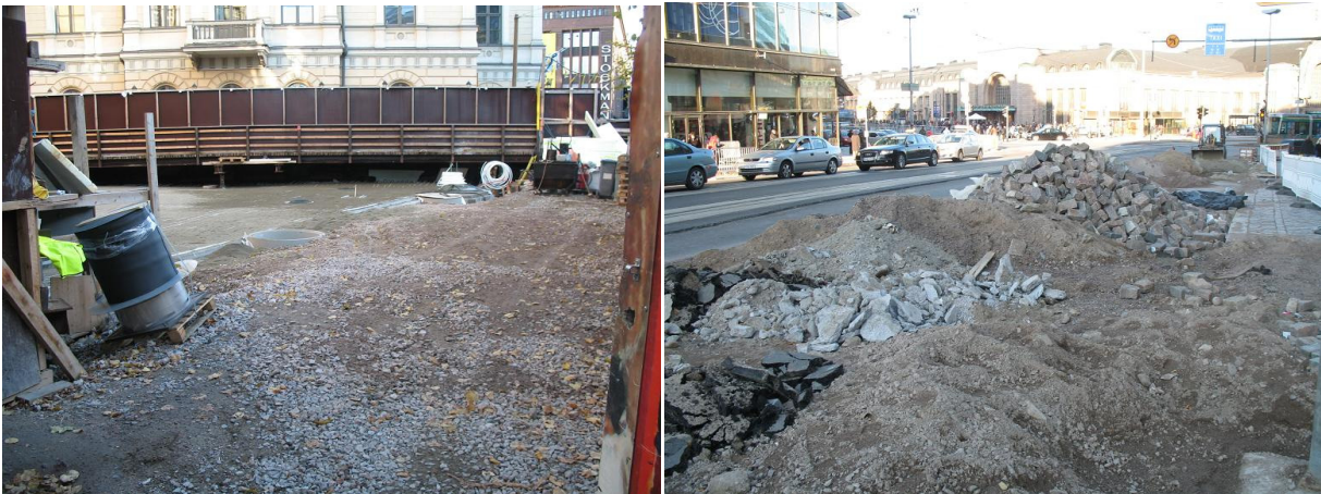
Kuva 2. Kaivopihan (vasemmalla) ja Kaivokadun (oikealla) rakennustyömaat lokakuussa 2008.
