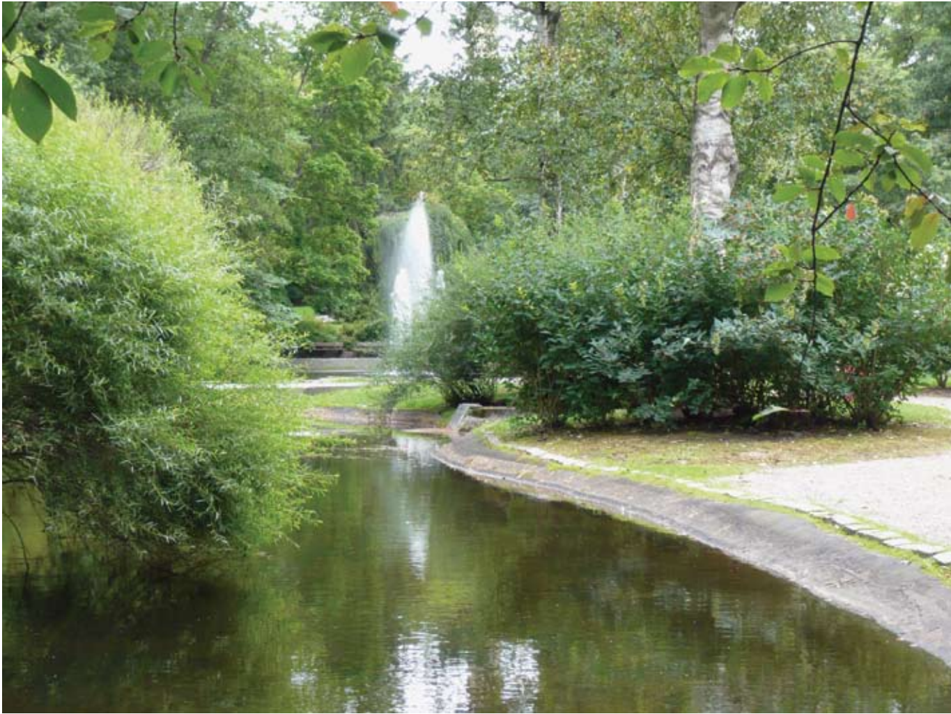
Kuva 16. Alppipuiston lammikon pohja on nykyisin asfaltoitu ja asfalttireuna nousee huomattavasti veden pintaa ylemmäksi, mikä heikentää alkuperäisenä tavoitteena ollutta vaikutelmaa luonnonmukaisesta lammikosta. Kuva: JS, kesä 2008.
