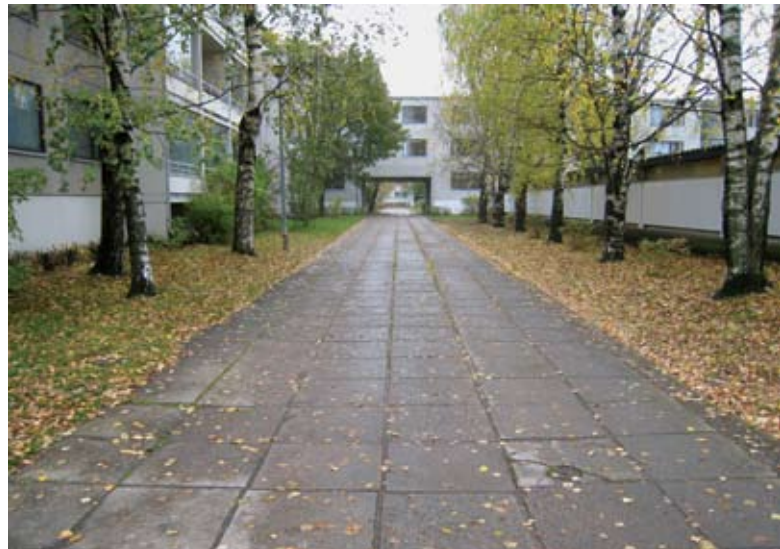
Kuva 13. Siltamäen alueen alkuperäinen harmaa betonilaatoitus on syytä säilyttää jatkossakin. Kuva: TP, syksy 2007.
