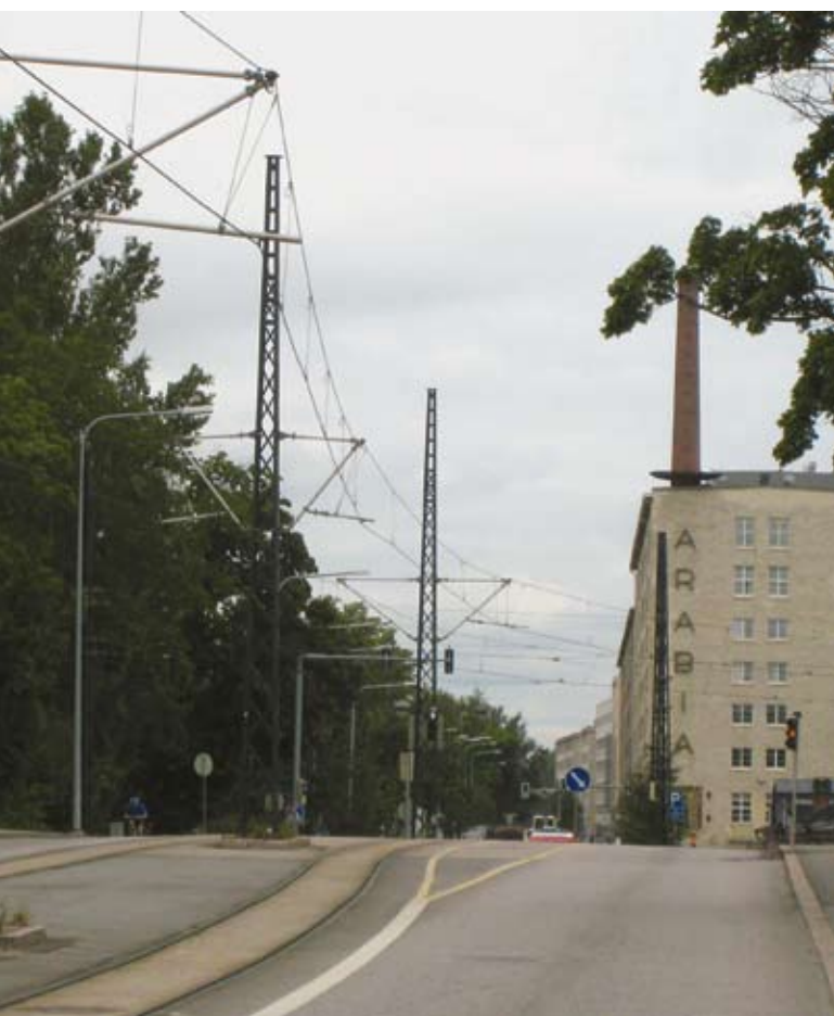
Kuva 45. Hämeentien kunnostuksessa on haluttu korostaa kadun historiallista luonnetta ristikkopylväillä Arabian alueella. Valaisimet ja valaisinpylväät sen sijaan ovat uusia ja luonteeltaan maantiemäisiä. Kuva: JS, kesä 2008.
