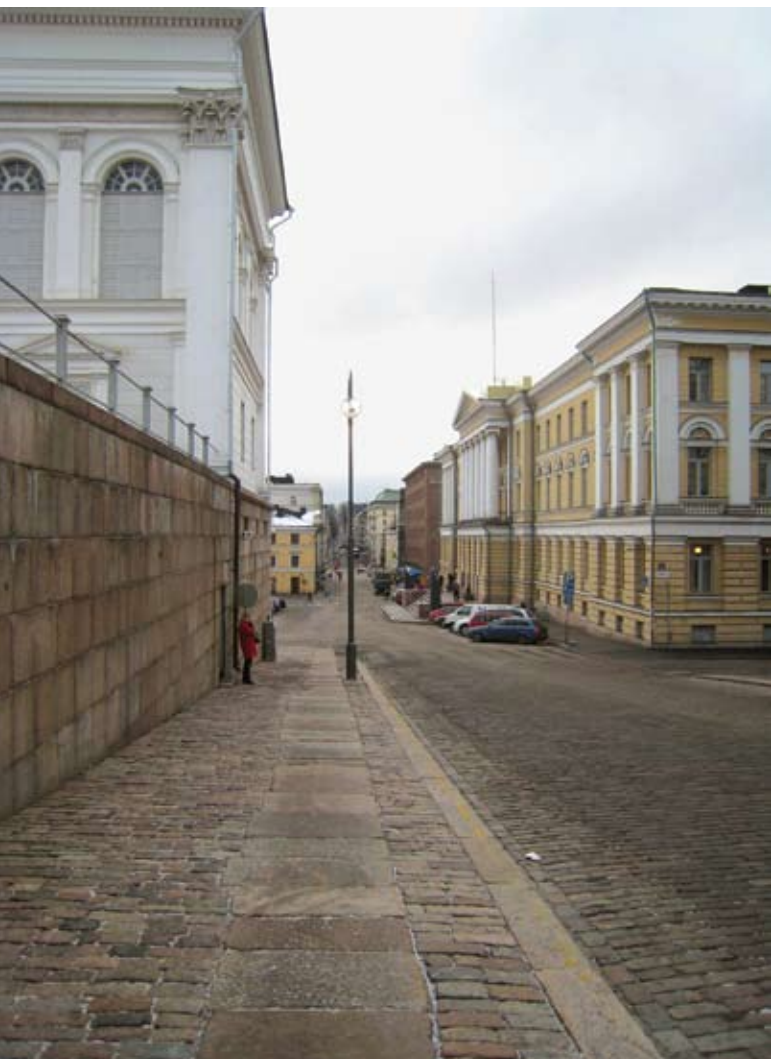
Kuva 40. Unioninkadun vanhaa 1800-luvulta periytyvää katukiveystä. Paasilaatat muodostivat aikaisemmin mukula- ja nupukiviä sileämmän kulkupinnan. Kivi on luonteenomaisesti punertavaa, juovikasta ja sävyltään vaihtelevaa. Tällaiset kiveykset ovat arvokkaita ja ne tulisi säilyttää. Kuva: TP, syksy 2007.
