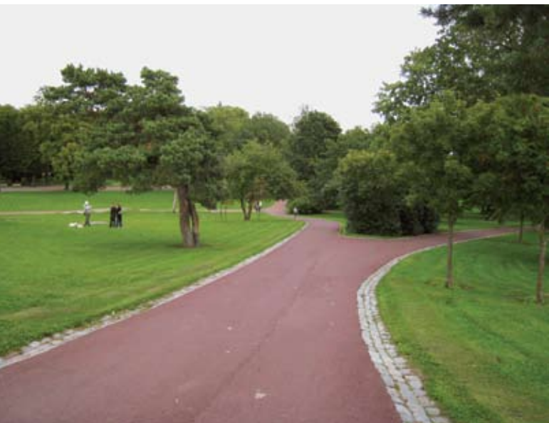
Kuva 24. Kaivopuistoon kunnossapidon helpottamiseksi asennettu punainen asfaltti on vieras materiaali historiallisessa puistossa. Asfaltin tilalle tulisi etsiä historiallisesti arvokkaaseen puistoon paremmin soivia ratkaisuja. Kuva JS, kesä 2008.
