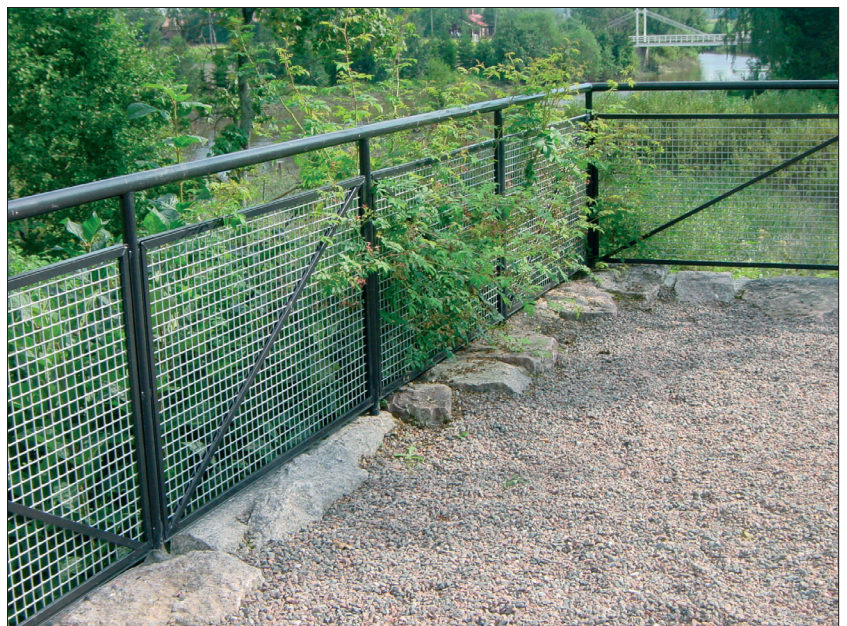
Kuva 19. Esimerkki putoamiskaiteesta Haltialan tilan palaneen päärakennuksen kivijalan päälle tehdystä tasanteesta.
