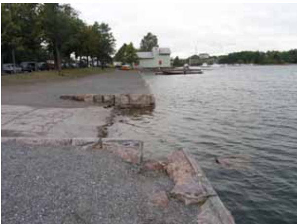
KUVA 4: Osa muurin kivistä on pudonnut mereen.
