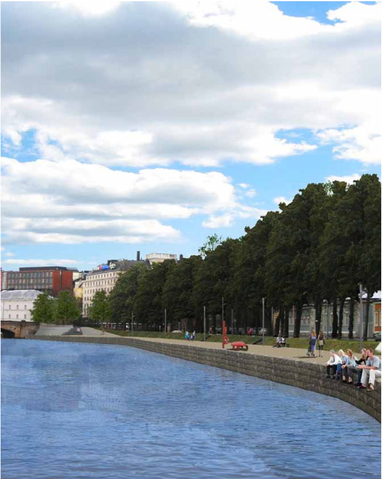
Kuva10: Yleisnäkymä kunnostetusta Kaisaniemenlahden eteläisestä rannasta. Rantamuurin yläreuna MW+1.5.
