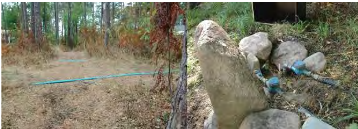
Kuva 78. Maanpinnalla risteilevää kesävesiverkostoa ja Sotainvalidien ja HKL:n alueiden vesimittarit.
