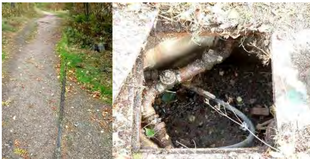
Kuva 74. Maan pinnassa kulkevaa vanhaa kesävesijohtoa sekä kesäveden ruostunut pääjakokaivo lähellä sauna.
