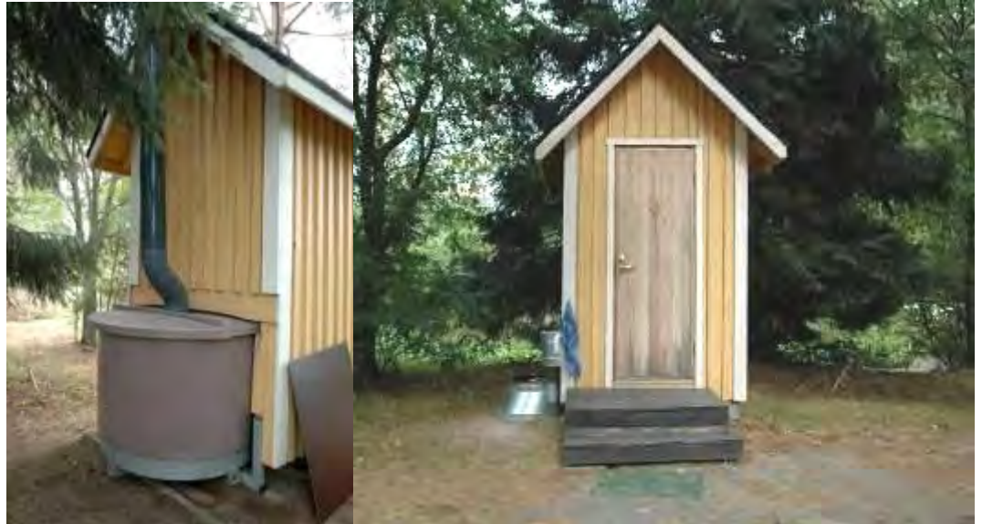
Kuva 27. Kerhotalon takana oleva kuivakäymälä.
