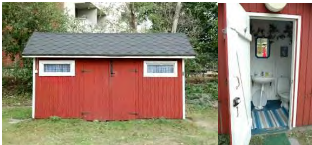
Kuva 26. Huoltorakennus ja sen vesivessa.
