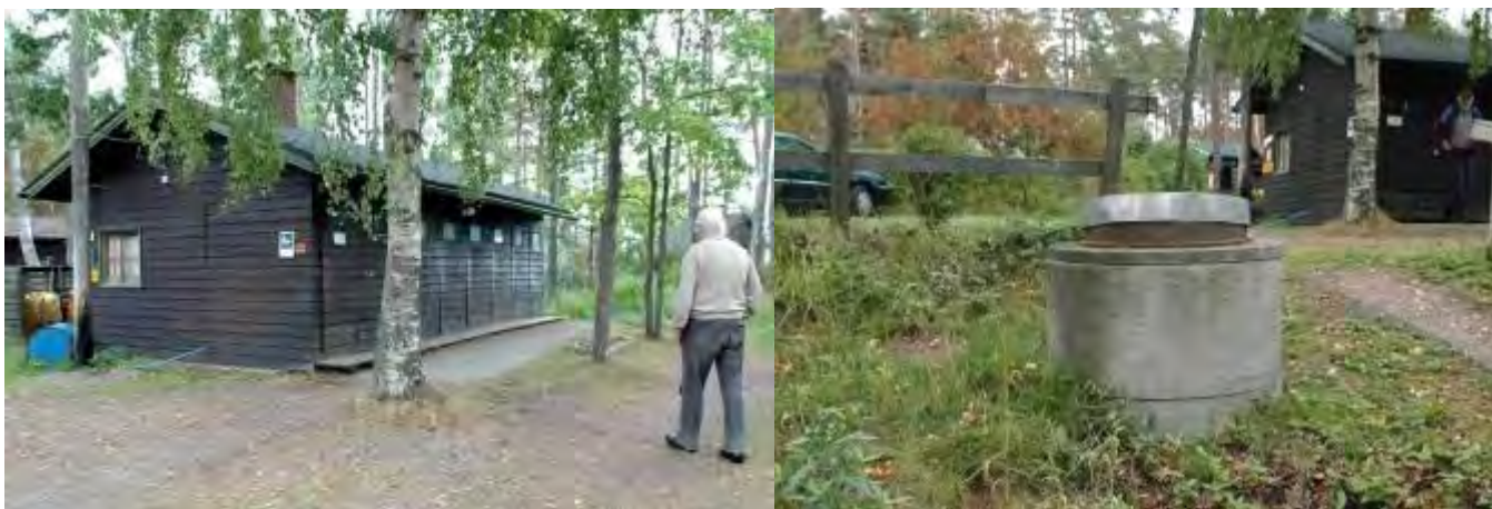
Kuva 79. Käymälärakennus ja toinen alueen käymälärakennuksen umpisäiliöistä.
