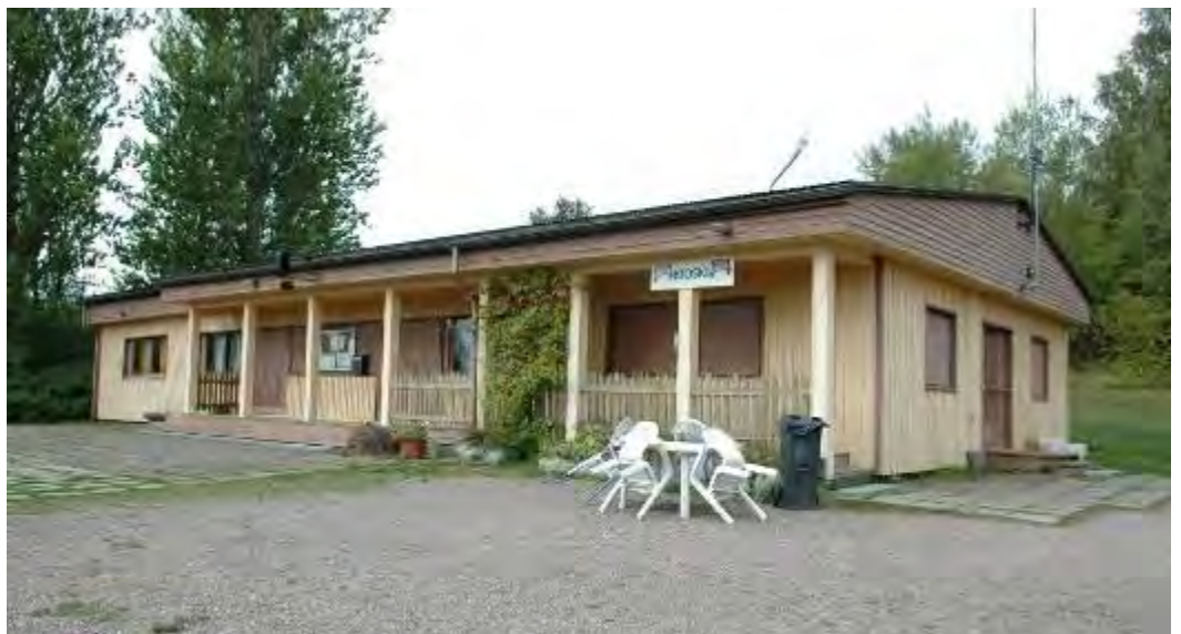
Kuva 21. Pakilan siirtolapuutarhan kerhotalo.
