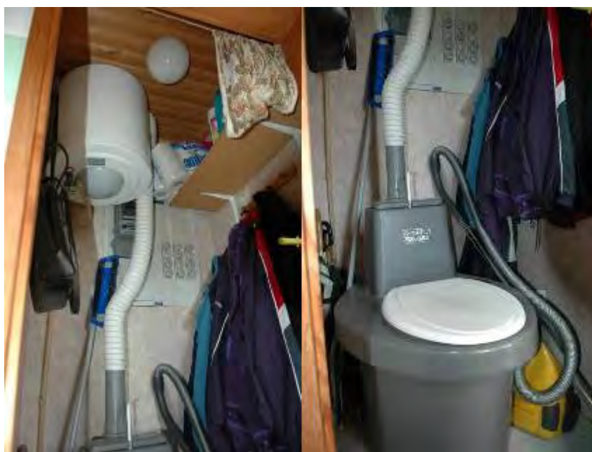
Kuva 35. Palstalaisen oma lämminvesivaraaja ja vessa.
