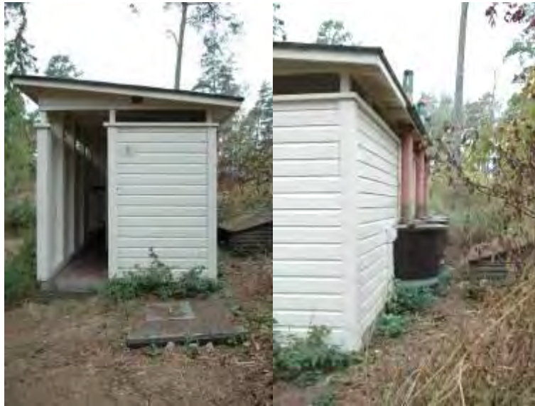
Kuva 59. Kuivakäymälä edestä ja takaa.
