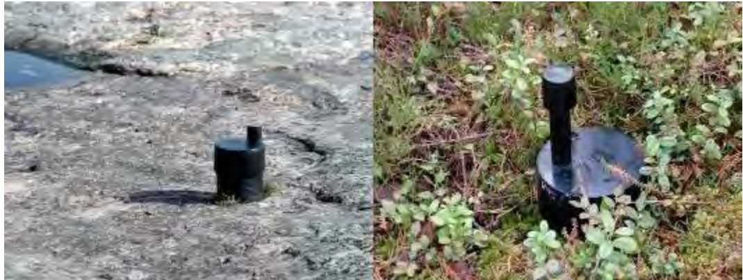
Kuva 69. Saarelle porattuja kaivonaihioita.
