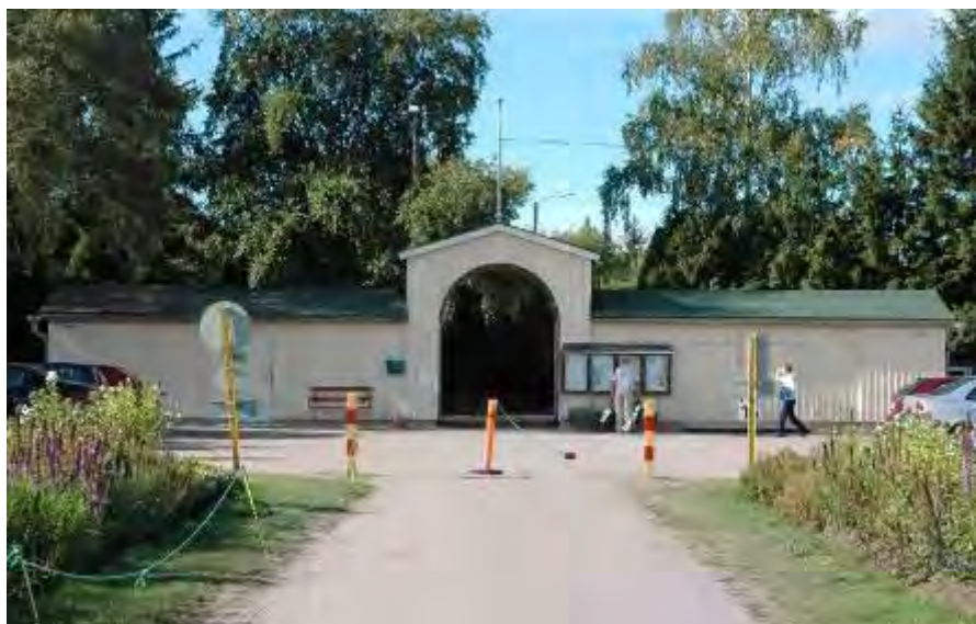
Kuva 9. Pääporttirakennus, jossa on wc:t ja suihkut.
