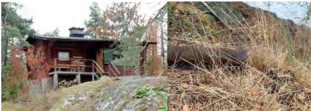
Kuva 64. Yhdistyksen sauna Pitkäluodolla ja saunan jätevesien purkupaikka.
