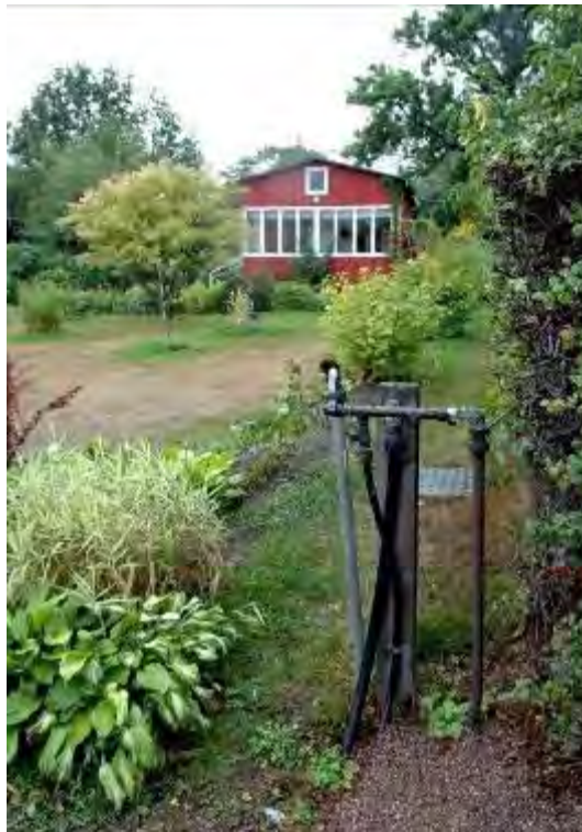
Kuva 4. Kesäveden jakotukki.
