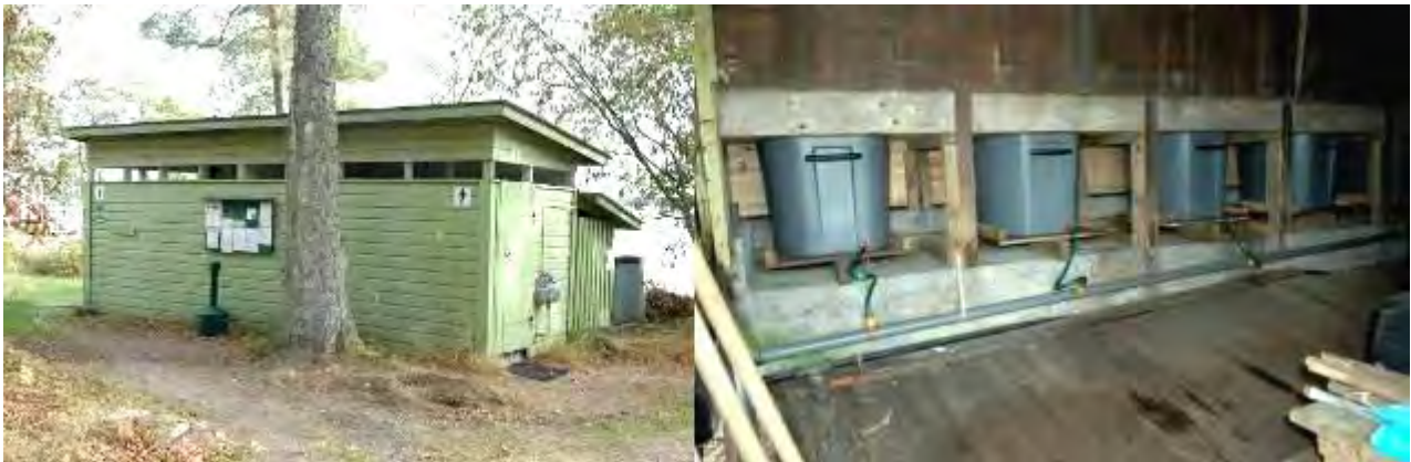
Kuva 47. Kuivakäymälä ja takaosan huoltotila.
