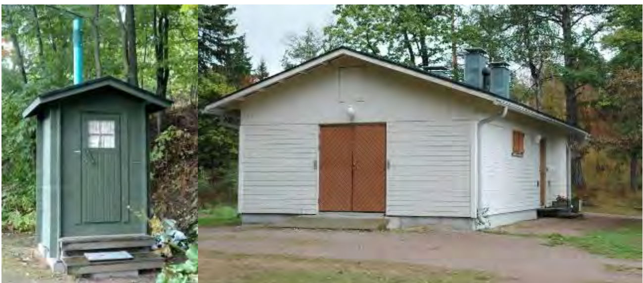
Kuva 6. Kuivakäymälä ja varastorakennus.
