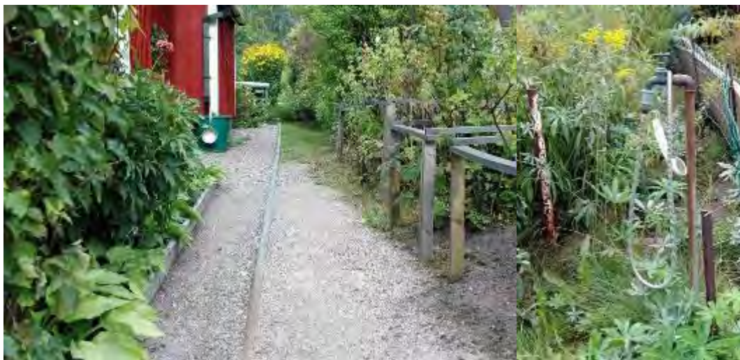
Kuva 25. Vanhaa maanpinnassa kulkevaa kesävesiverkostoa ja kylmä pihasuihku.
