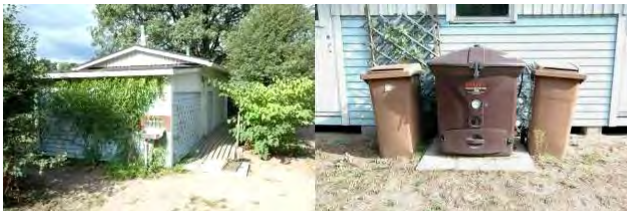
Kuva 41. Alueen kuivakäymälä ja sen kompostori.
