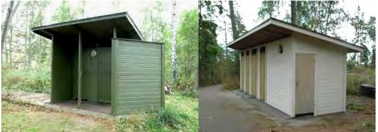
Kuva 76. kuivakäymälä alueen itäpuolella lähellä Humaus ry:tä sekä palaneen tilalle rakennettu uusi kuivakäymäläalueen länsipuolella.
