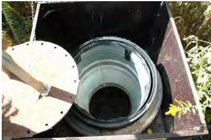
Kuva 36. Toimistorakennuksen takana oleva umpisäiliö, johon asukkaat saavat tyhjentää kuivakäymäläjätteitään.
