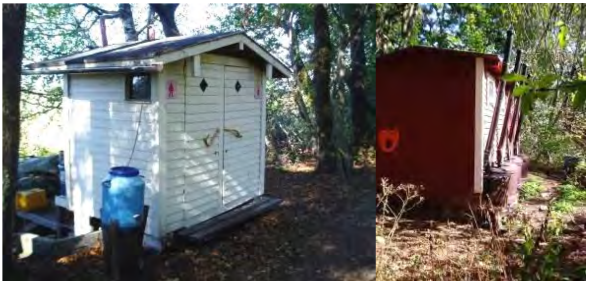
Kuva 54. Länsirannan kaksi kuivakäymälää ja keskisen käymälän EVEK-säiliöt.
