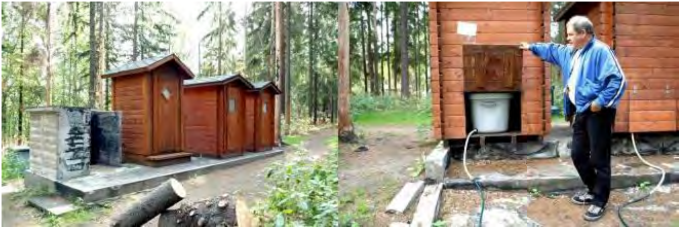
Kuva 48. Palaneen kuivakäymälän perusta, yksittäiset käymälät ja huoltoluukku.
