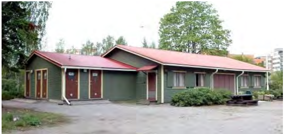
Kuva 16. Kerhotalo ja sen päädyssä oleva suihku ja wc-lisärakennus
