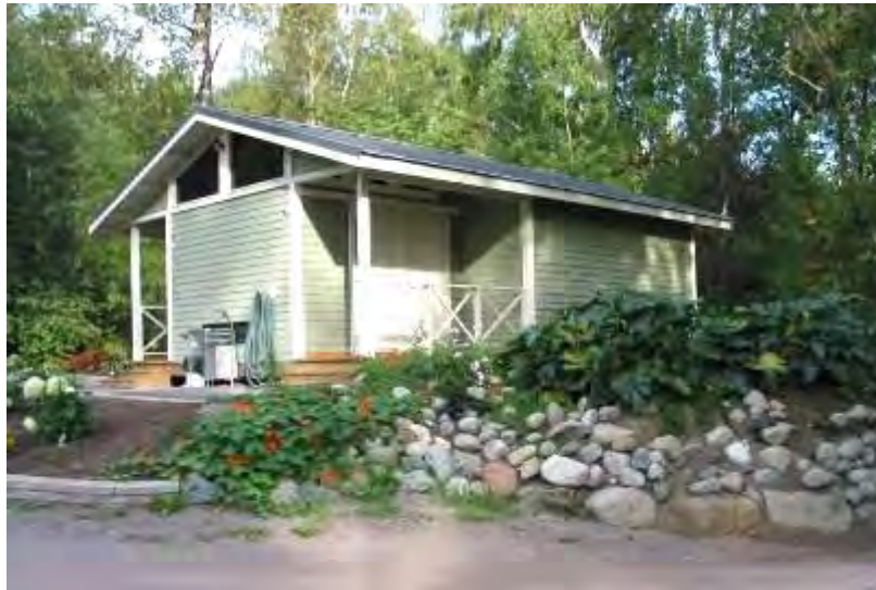
Kuva 12. Uusi varistorakennus, jossa on umpisäiliöllä varustetut wc:t (4 kpl).
