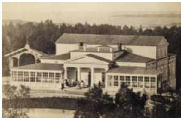
Kuvat 10 ja 11. Kaivobuone 1860-luvulla.
