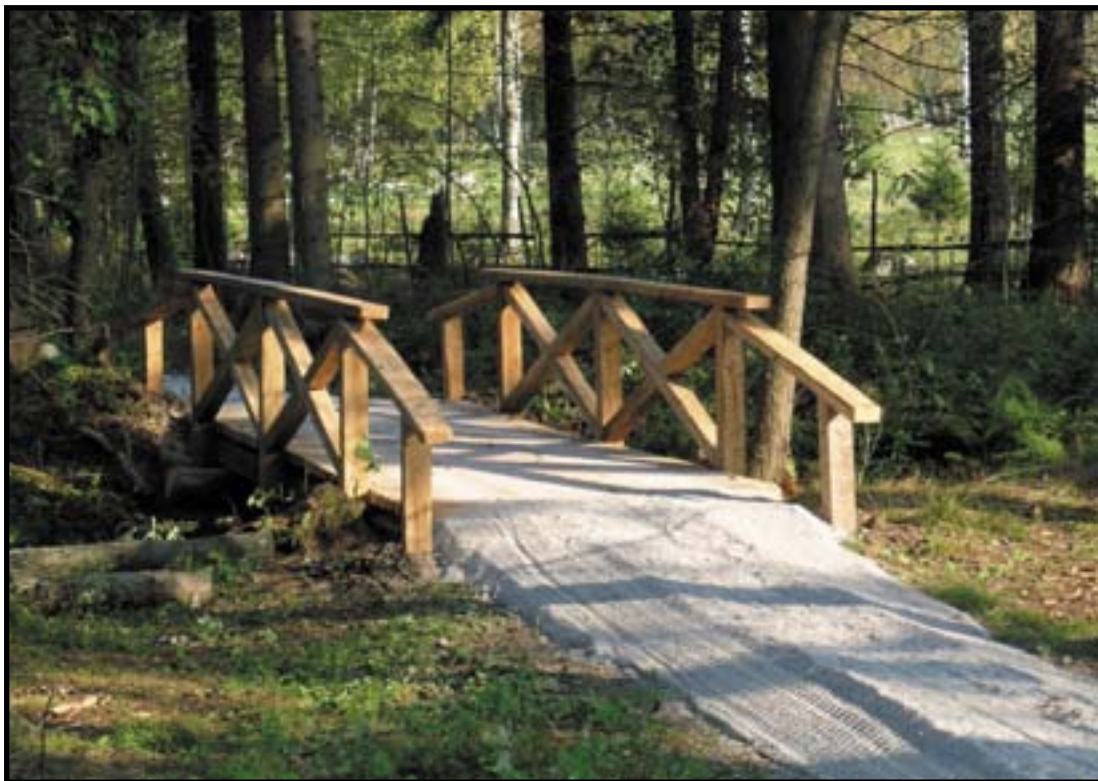
Kuva 10. Syyskuussa 2005 uusittu puusilta (Silta 04).
