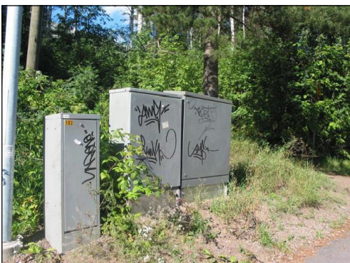
Kuvat ylhäältä alaspäin: Levähdyspaikka A-hoitoluokan puistossa. Koira-aitauksen penkki Naulakallion puistossa. Uussillanpuisto 2004 Sähkökaappeja Arhotien varrella.
