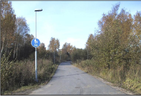
Asfalttipäällysteinen kevyen liikenteen raitti Länsimäentien varrella.
