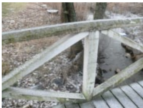
Silta syksyllä 2008. Sen materiaali on sahatavaraa, jossa maali on pysynyt. Tumma väri on levää, joka pestään pois.
