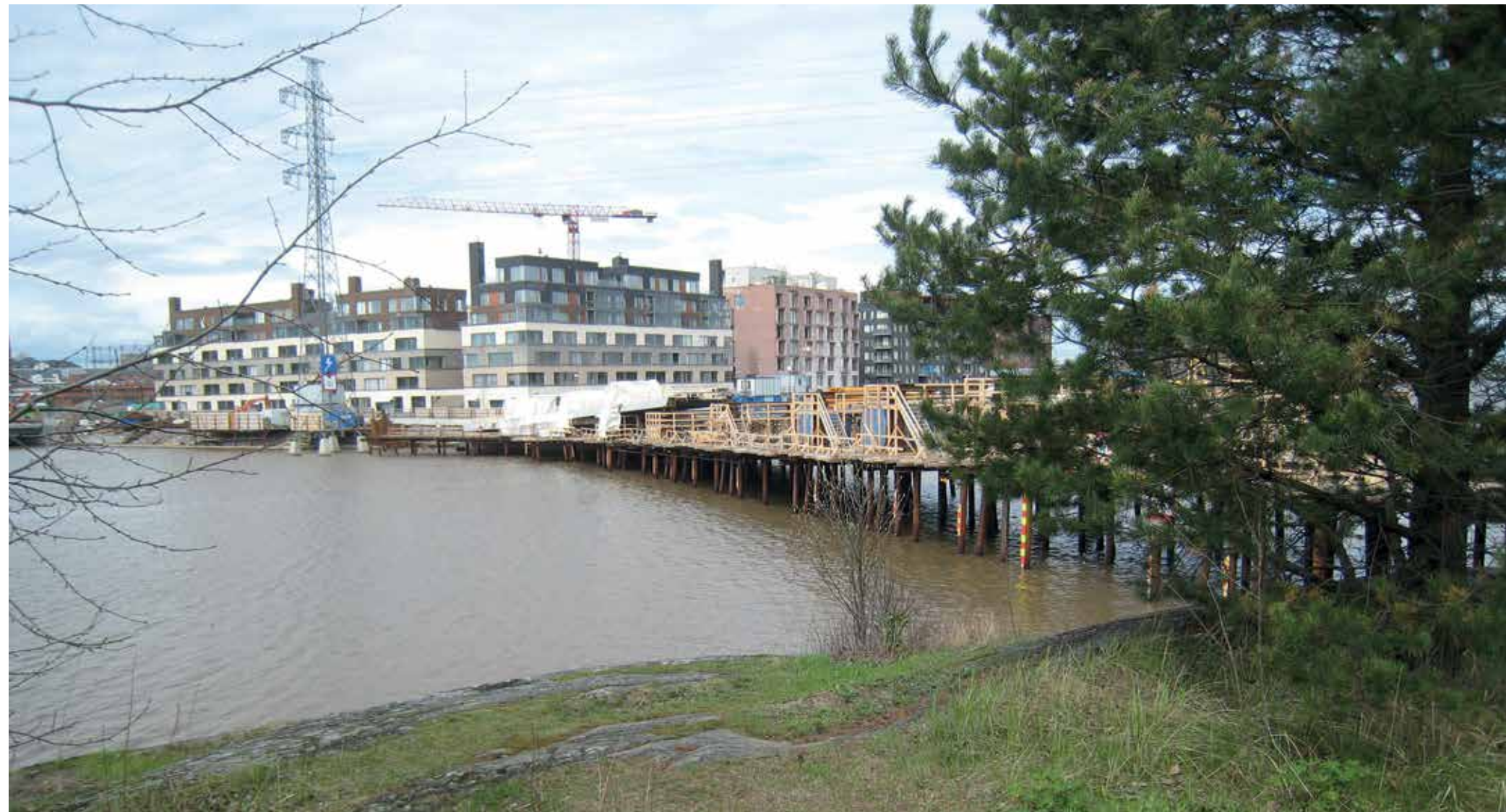
Kuva 7. Näkymä Isoisänsillan työmaalle keväällä 2015. Silta tulee yhdistämään Mustikkamaan virkistysalueen ja Kalasataman uuden asuinalueen toisiinsa.
