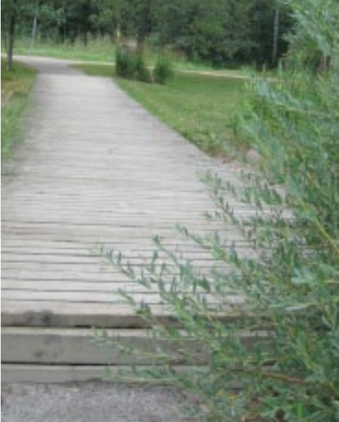
Sorastuskaitaleen ylittävä lavetti on päistään kullunut, kun sen yli ajetaan polkupyörillä. Lavettien päihin rakennetaan esteettömät luiskat.
