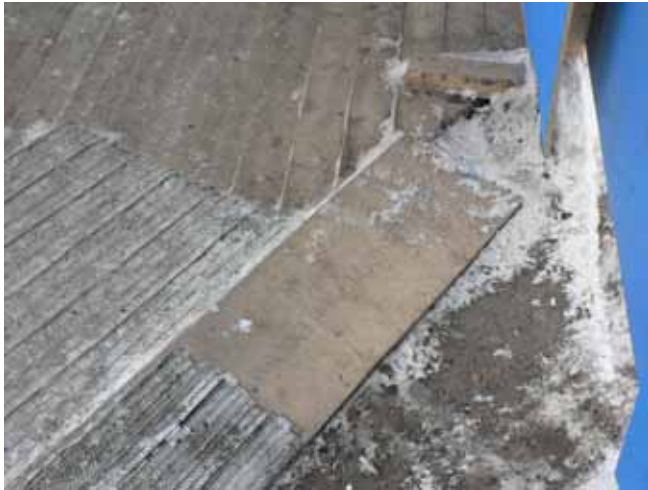
Kuva 44. Kuvan luiskajärjestely on huono ja liukas.
