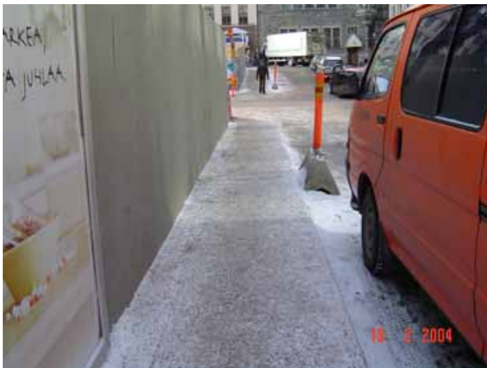
Kuva 32. Vanerisen jalankulkuväylän pinta on talvella samanlainen, kun muillakin väylillä /13/.
