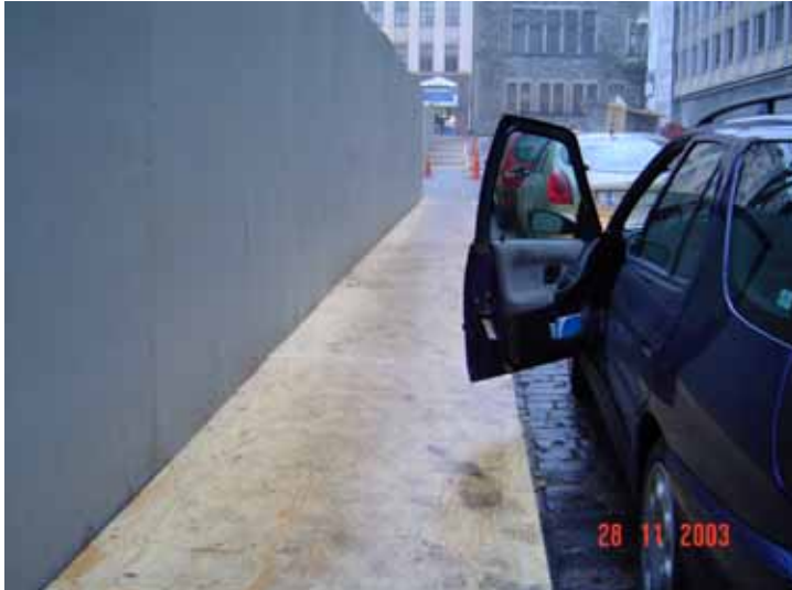
Kuva 31. Vanerista rakennettu tilapäinen jalankulkuväylä on sateella liukas /13/.
