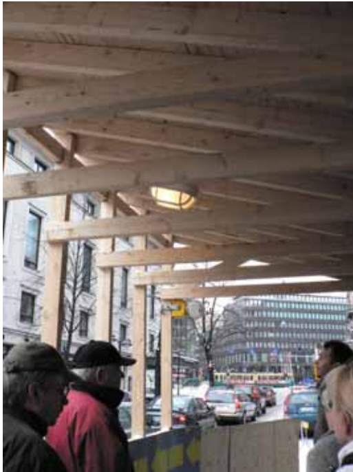
Kuva 43. Katettu väylä suojaa ylhäältä putoavilta materiaaleilta.
