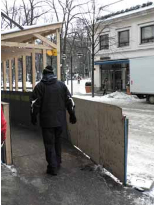
Kuva 37. Hyvä suojalaite ohjaa selkeästi pois ajoradalta.
