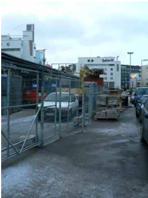
Kuva 26. Kaikki työmaan tarvikkeet tulisi sijoittaa aitauksen sisäpuolelle.
