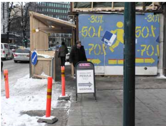
Kuva 41. Jalankulku on järjestetty vanerisen jalankulkutunnelin avulla
