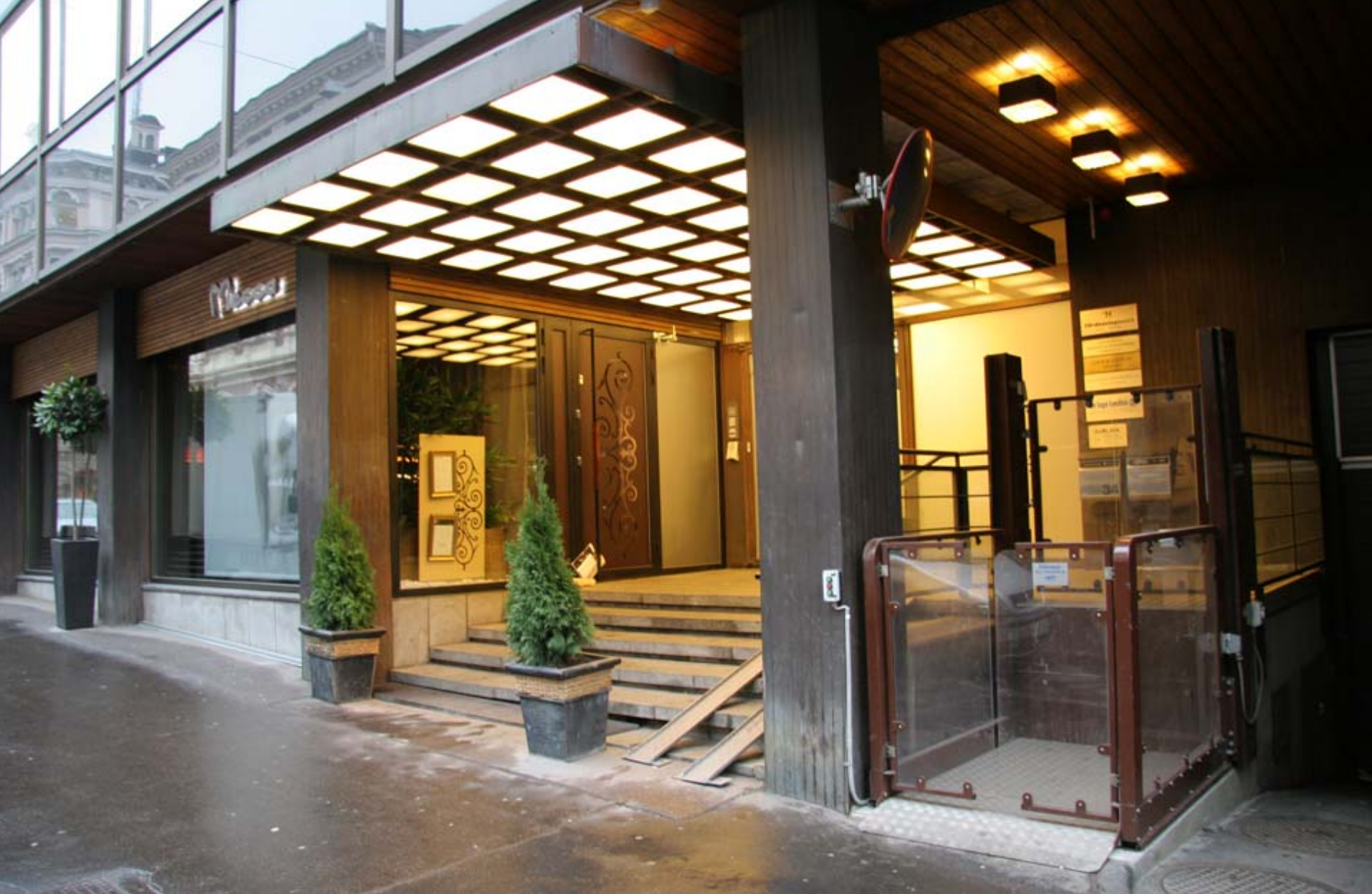
17. Sisäänkäynnin tasoeroa ei ole mahdollista tilanpuutteesta johtuen ratkaista luiskalla. Sisäänkäyntiin noustaán pyörätuolihissin avulla, joka on ulkotilassa ja sijoitettu katokseen. (Ravintola Mecca)
