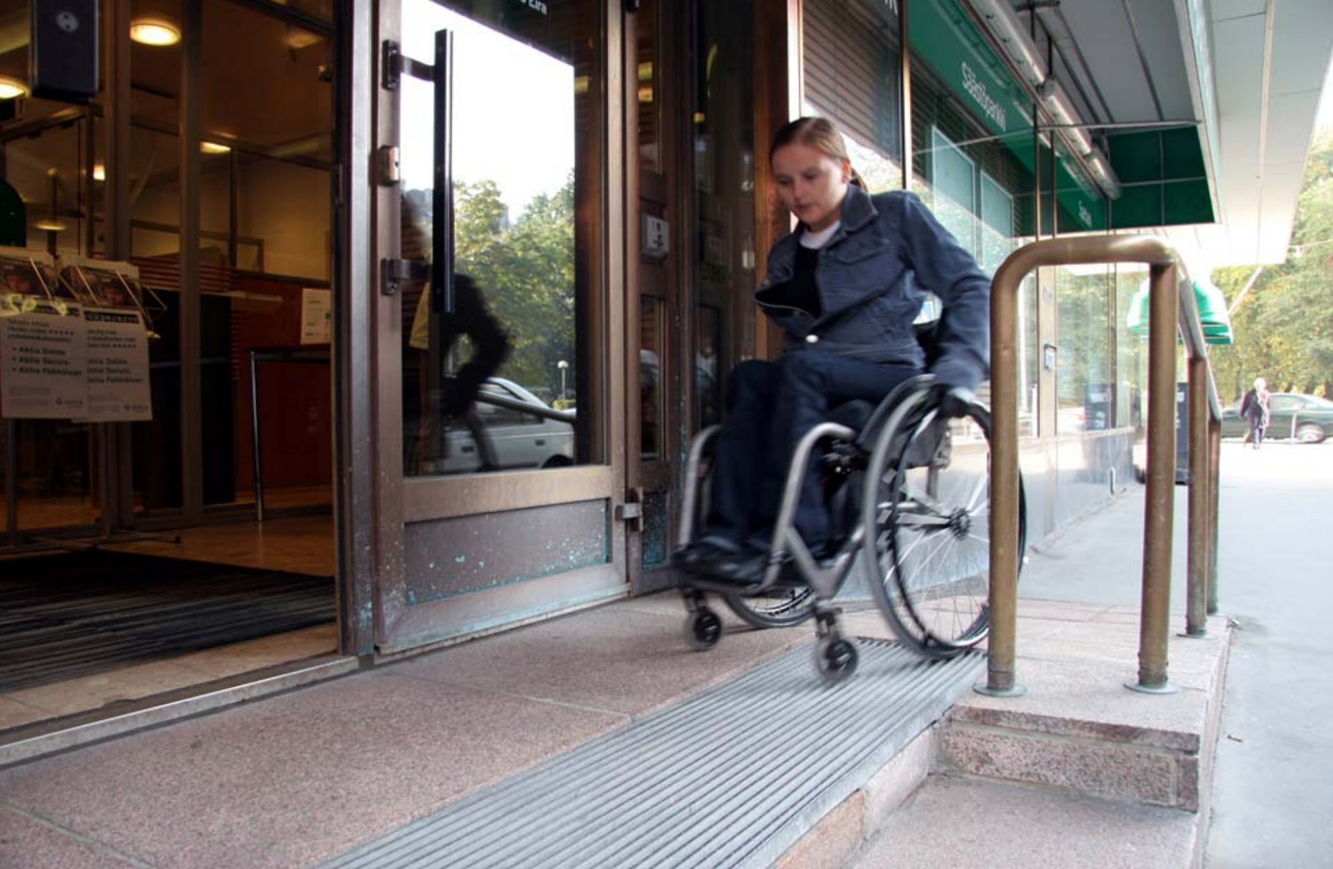
10. Oven edessä on oltava riittävän suuri tasanne oven avaamista ja pyörätuolilla kääntymistä varten. Ovedusritilän on oltava sisäänkäynnin tasossa. (Vuorimiehenkatu)
