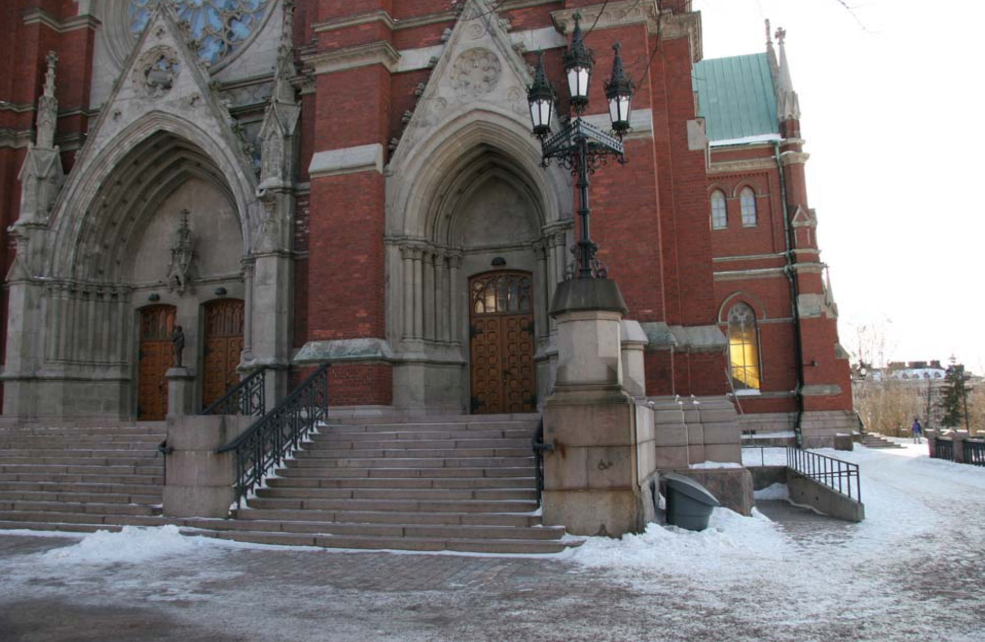
15. Kirkon pääovelle nouseaan portaita. Kirkkosalin alle on louhittu uusi kryptakerros, jonka kautta päästään esteettömästi rakennukseen. Sisäänkäyntiin tullaan kryptan tasolle johtavaa luiskaa pitkin. (Johanneksen kirkko)
