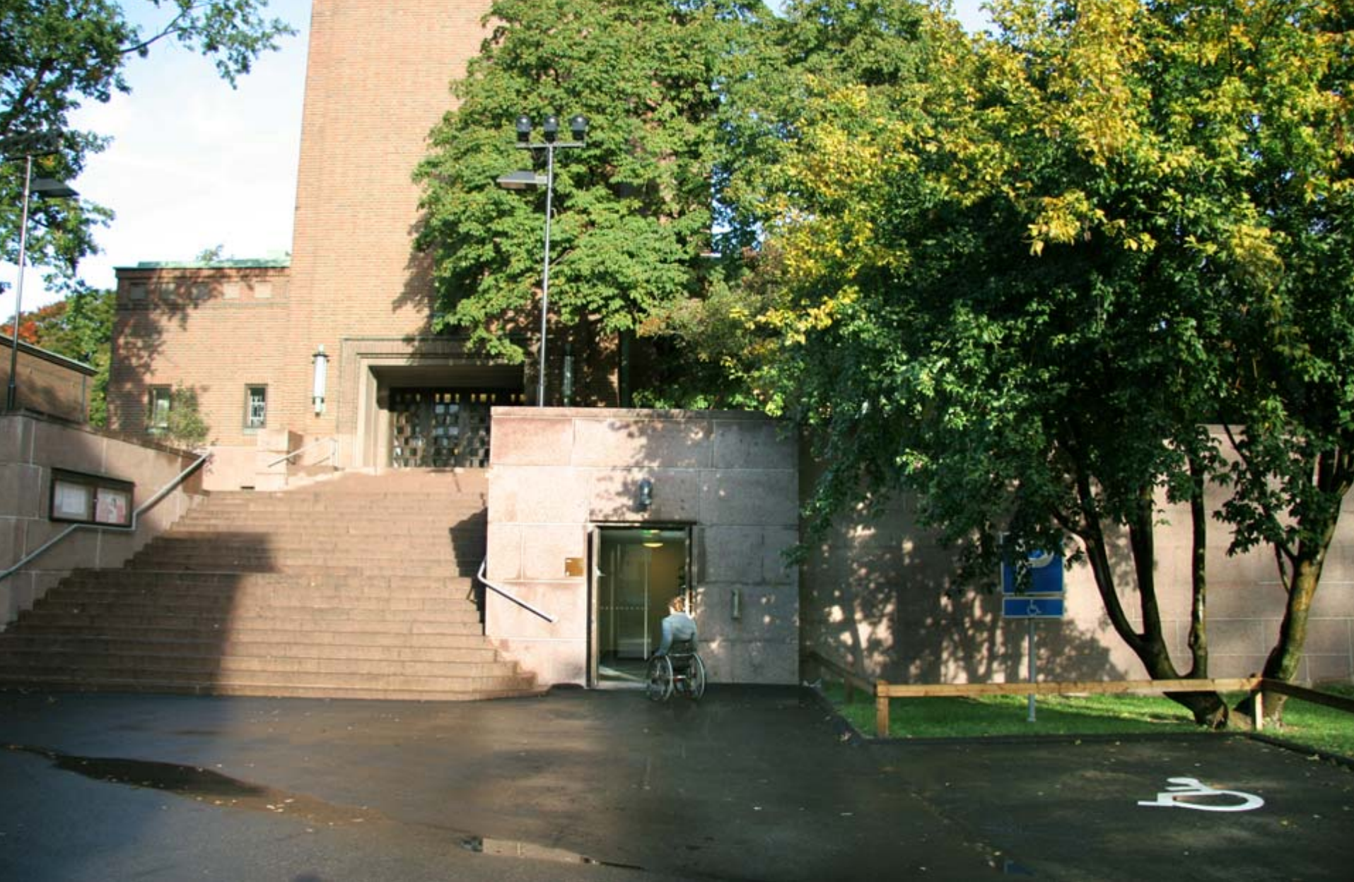
14. Kirkon pääsisäänkäynnissä on portaat. Esteetön sisäänkäynti on kryptan ovesta jonka kautta päästään hissiin. Esteettömän sisäänkäynnin yhteydessä on liikkumisesteisten pysäköintipaikat. (Agricolan kirkko)
