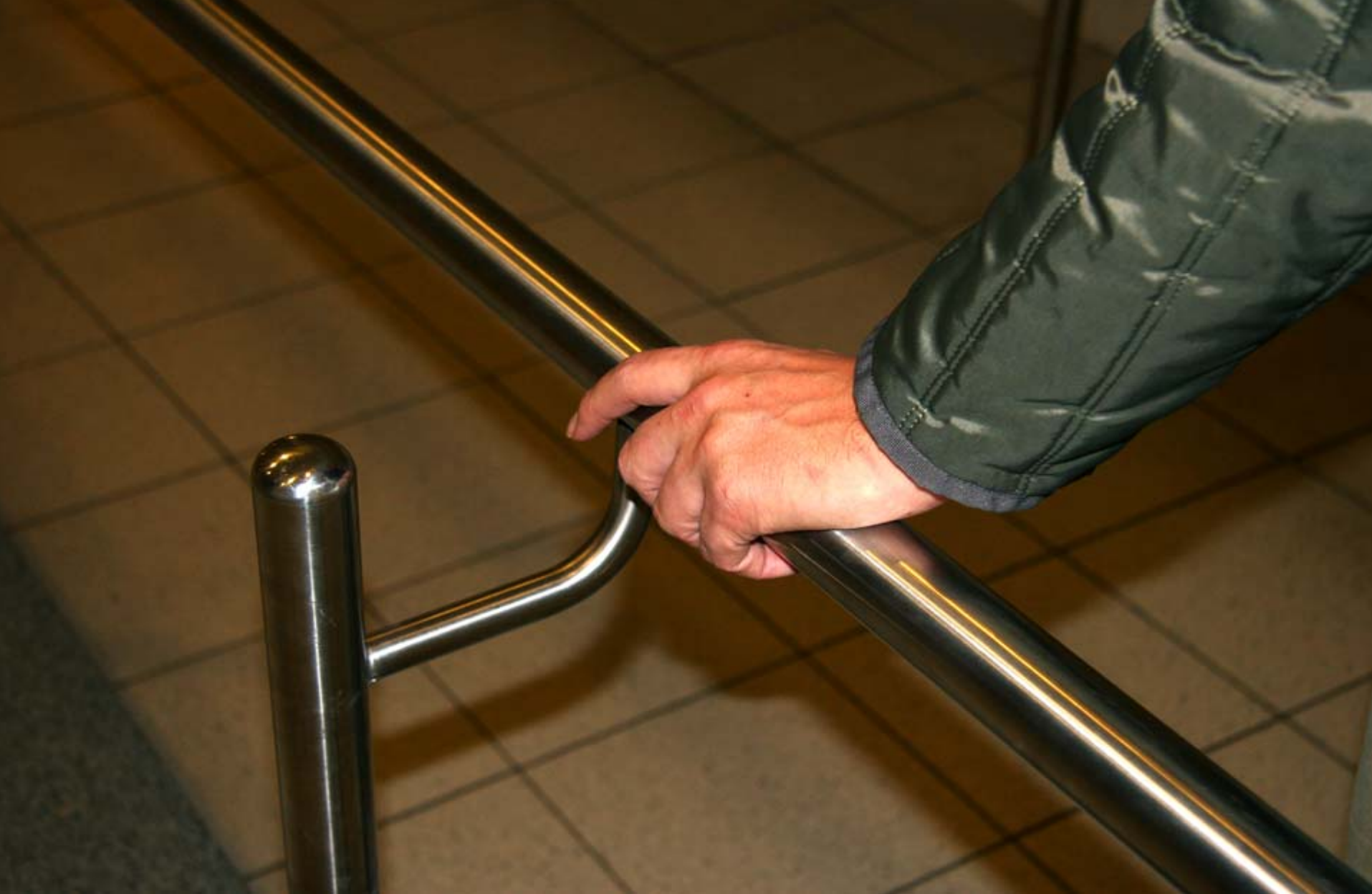
19. Käsijohde jota pitkin voi liu'uttaa kättä. (Yhdyskäytävä Forumista Stockmannille)
