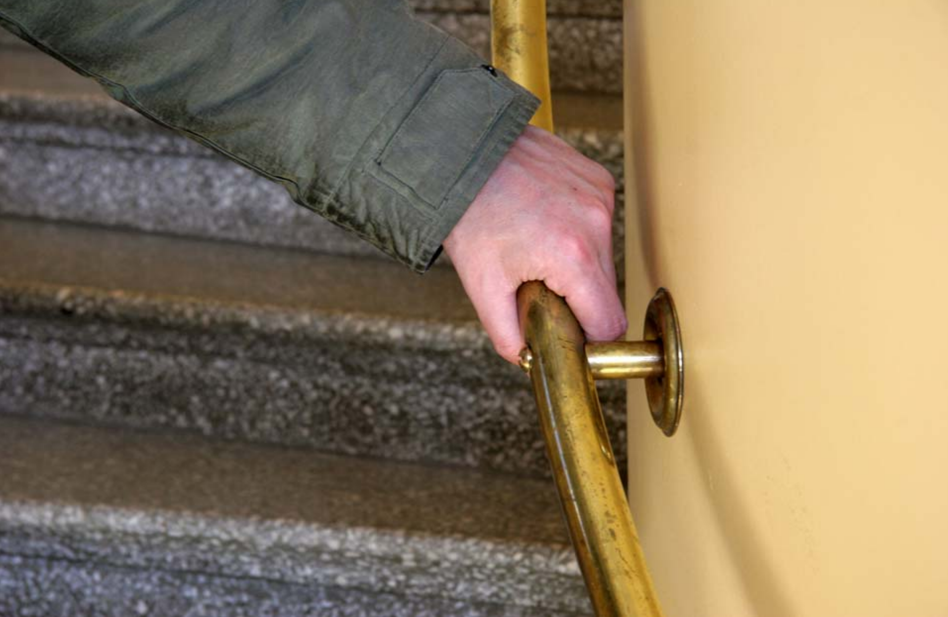
18. Käsijohteen kiinnitysrakenne haittaa käden liukumista. (Kansallisteatteri)
