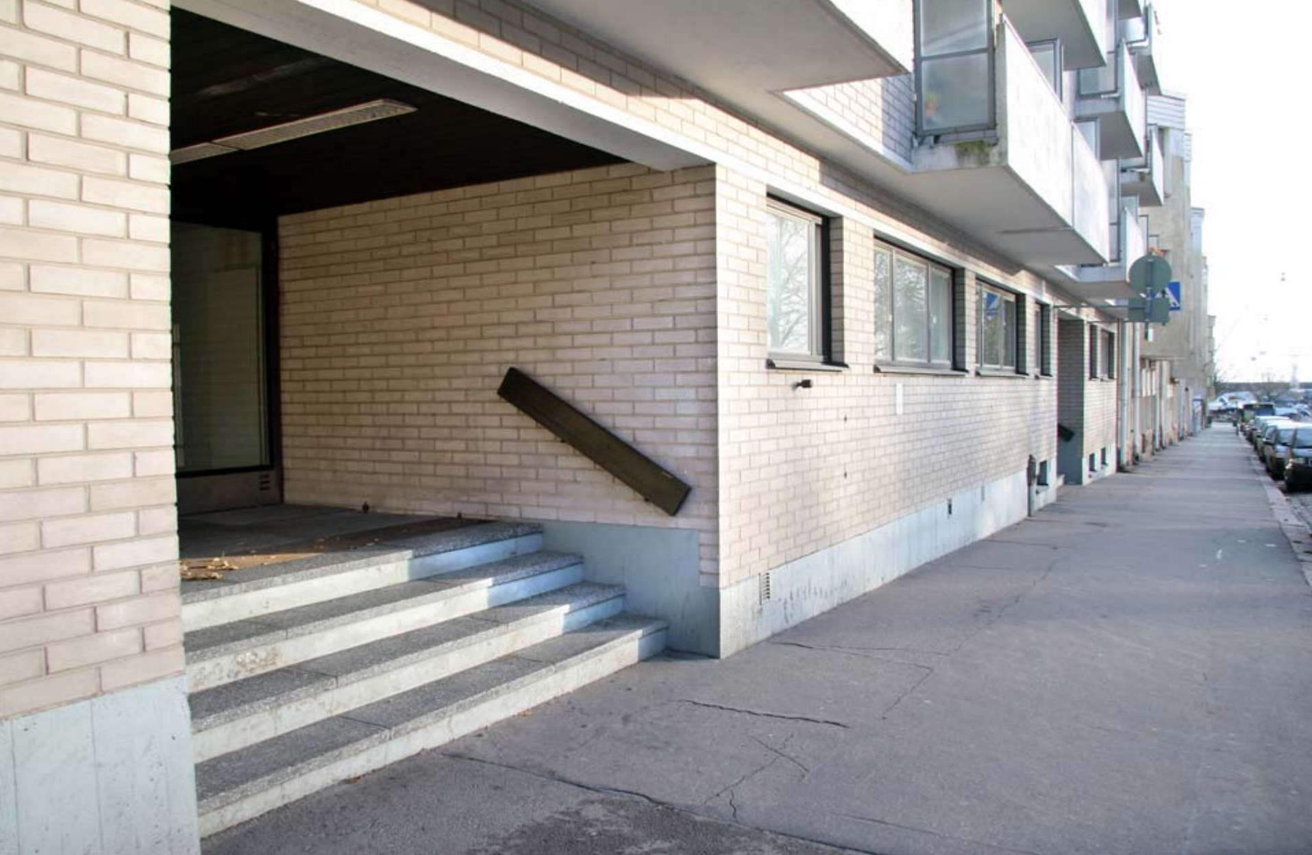
15. Lautamainen lyhyt käsijohde on liian lähellä seinää. Siitä ei saa kunnon otetta. (Laivurinkatu)
