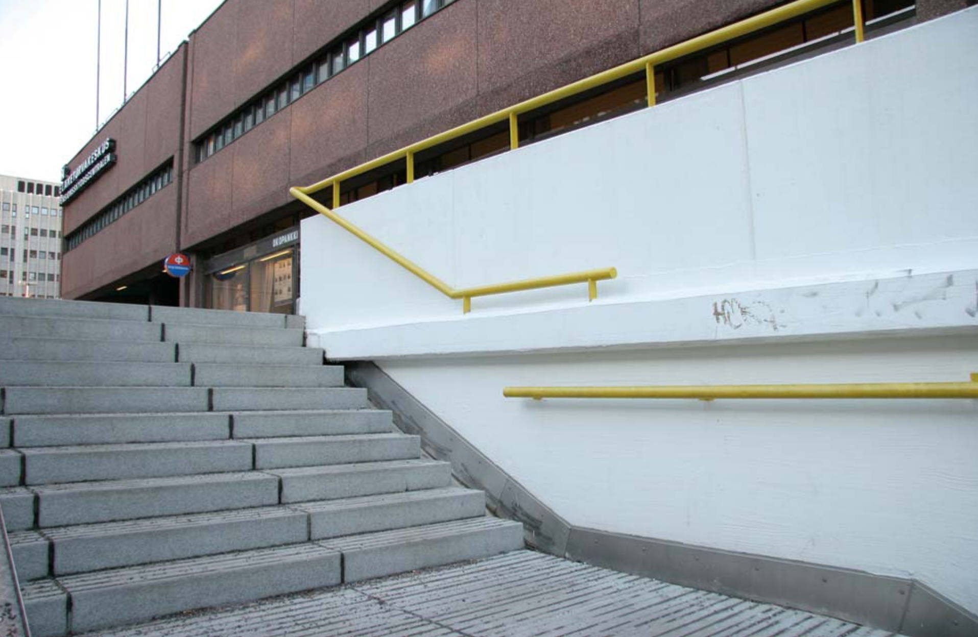
17. Käsijohde katkeaa kesken ja on aivan liian paksu, jotta siitä saisi sormet ympäri. (Itä-Pasila)
