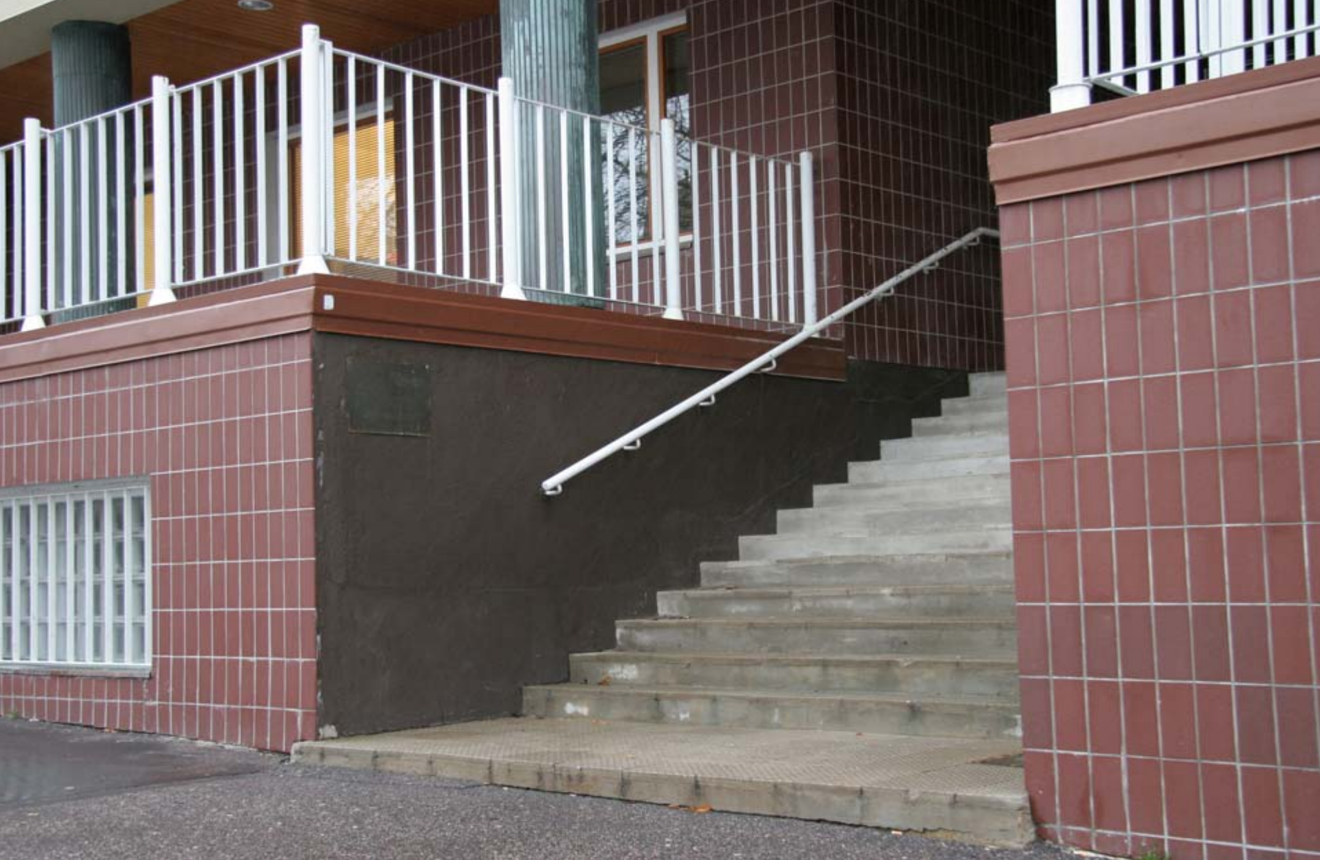
14. Liian lyhyt käsijohde on vaarallinen sillä näkövammaisen henkilö voi luulla portaiden loppuneen ja pudota, kun käsijohde loppuu. (Laivurinkatu)
