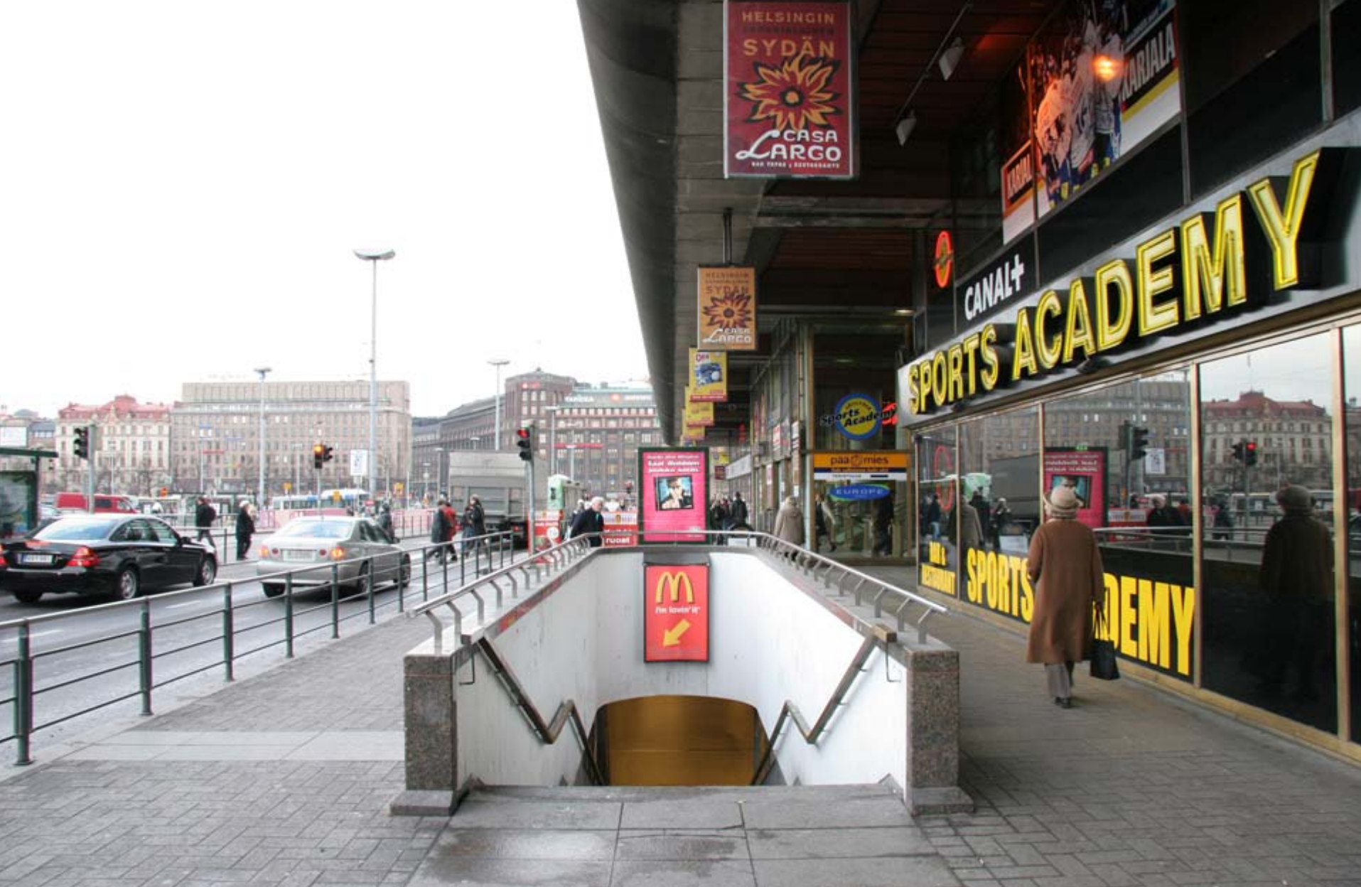
6. Alas johtava porras kulkureitin jatkeena aiheuttaa putoamisvaaran. (Kaivokatu)
