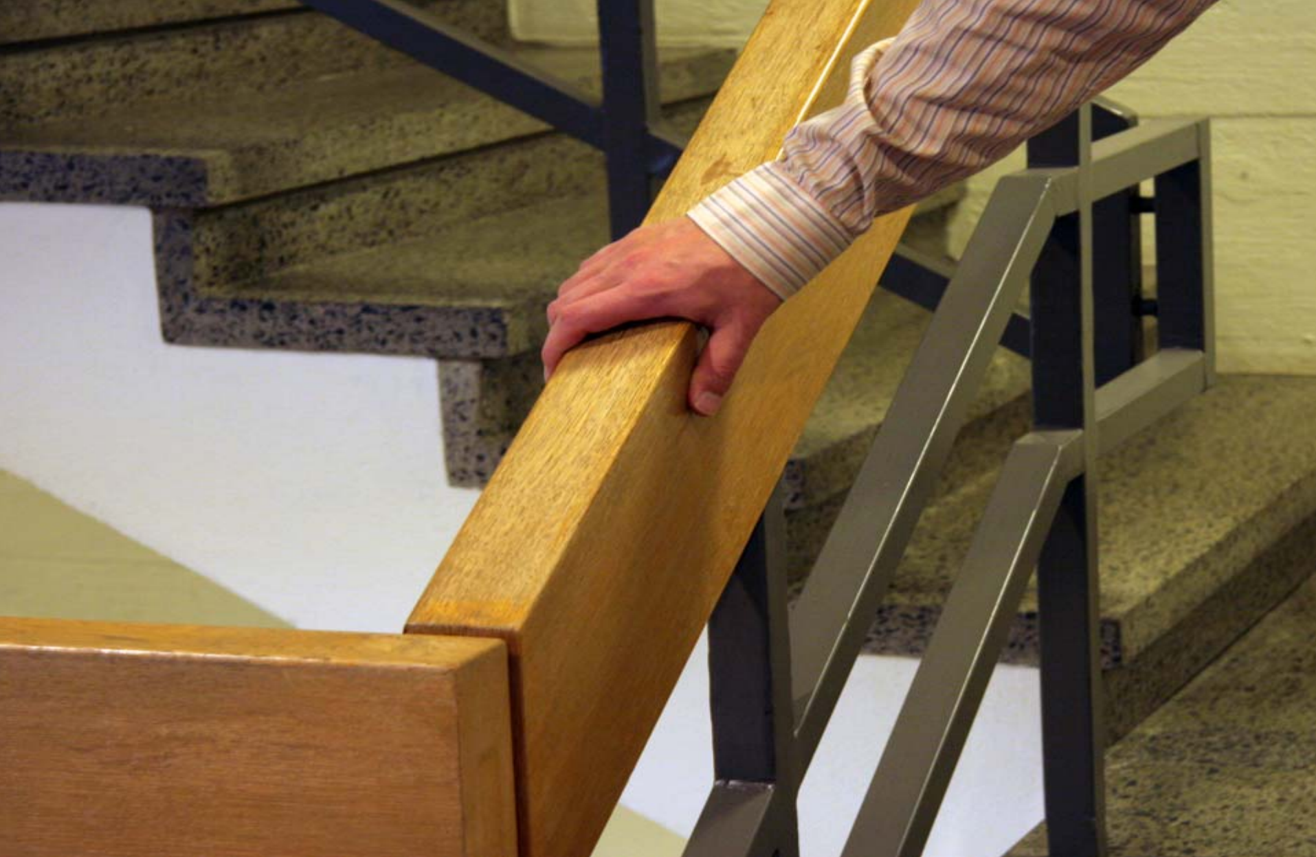
16. Käsijohde on liian paksu, siitä ei saa sormia ympäri ja lisäksi se on kulmikas eikä pyöristetty. (Siltavuorenpenger)
