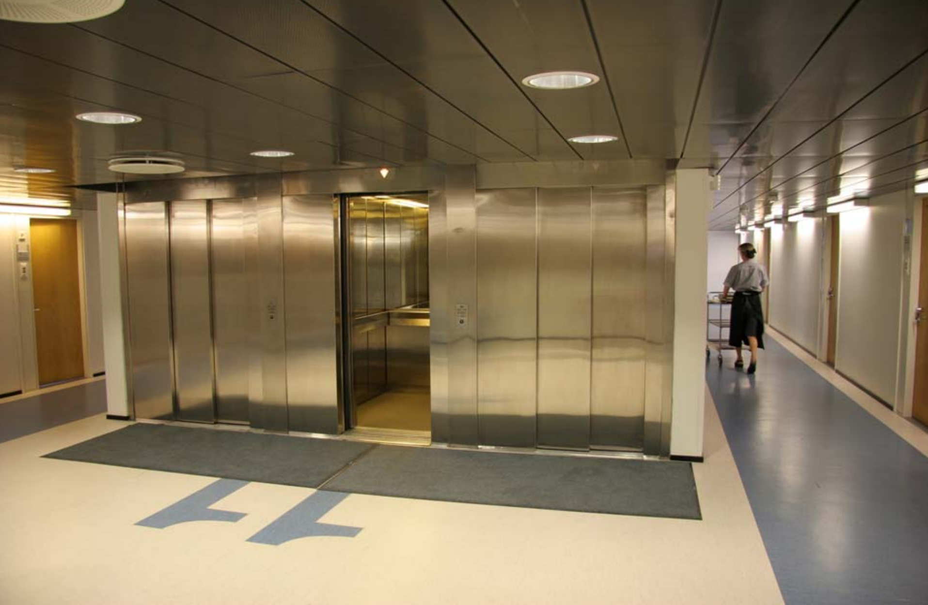
10. Kerroksen numero on merkitty lattiaan suurikokoisena. Vaikeasti näkövammainen henkilö se ei kuitenkaan auta. (Kallion virastotalo)
