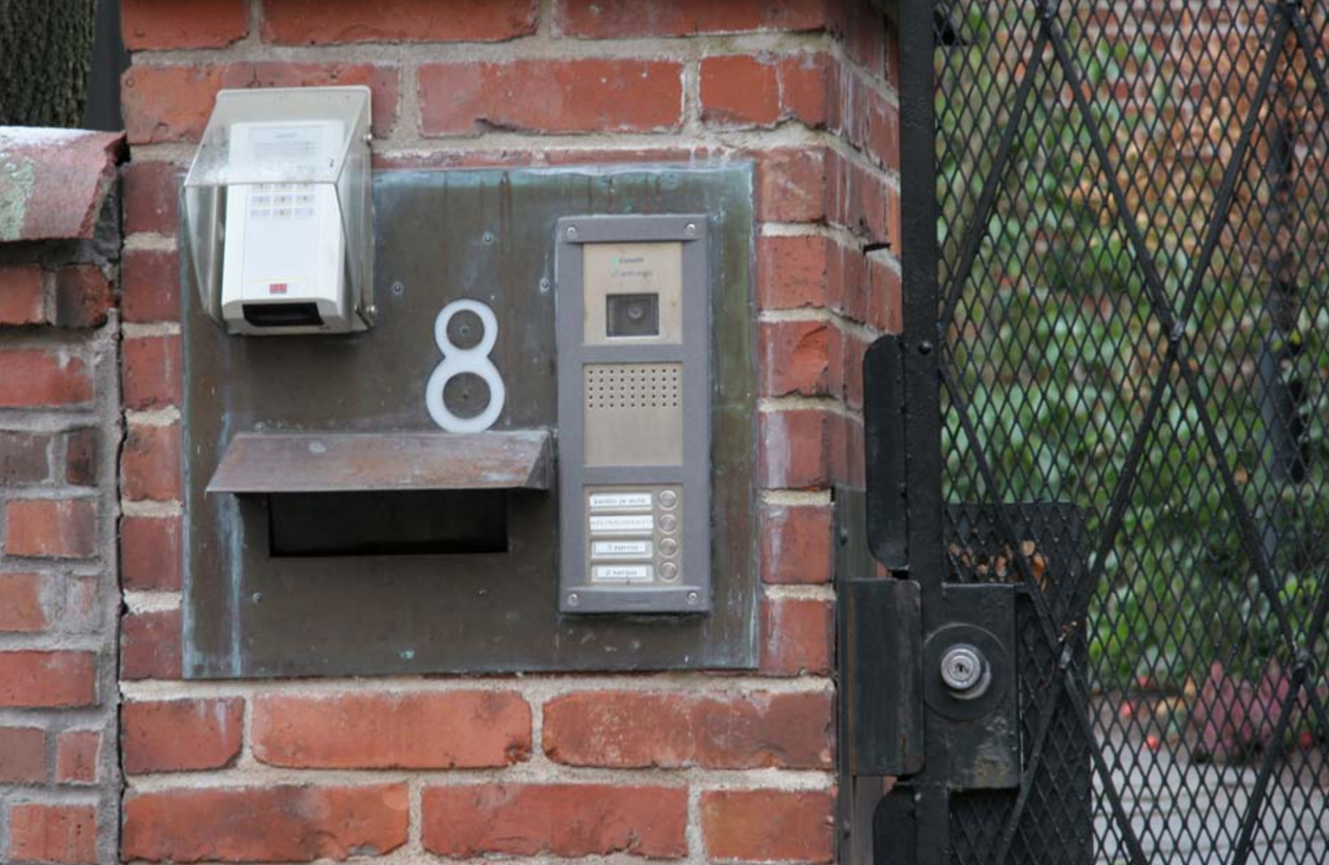
6. Talon numerossa on hyvä kontrasti ja se on näkemisen kannalta sopivalla korkeudella. Summereissa tulee olla kohonumerot, hyvä kontrasti ja äänimerkin lisäksi valomerkki. (Eira)
