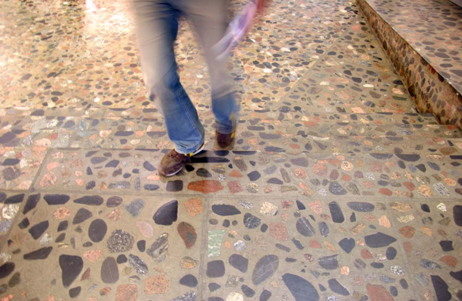
1. Lattian kuviot estävät näkemästä tasoeroja. Kuvassa on alas johtavat portaat ja kapea luiska, josta kaiteet puuttuvat. Tapaturmavaara on ilmeinen. (City-käytävä)
