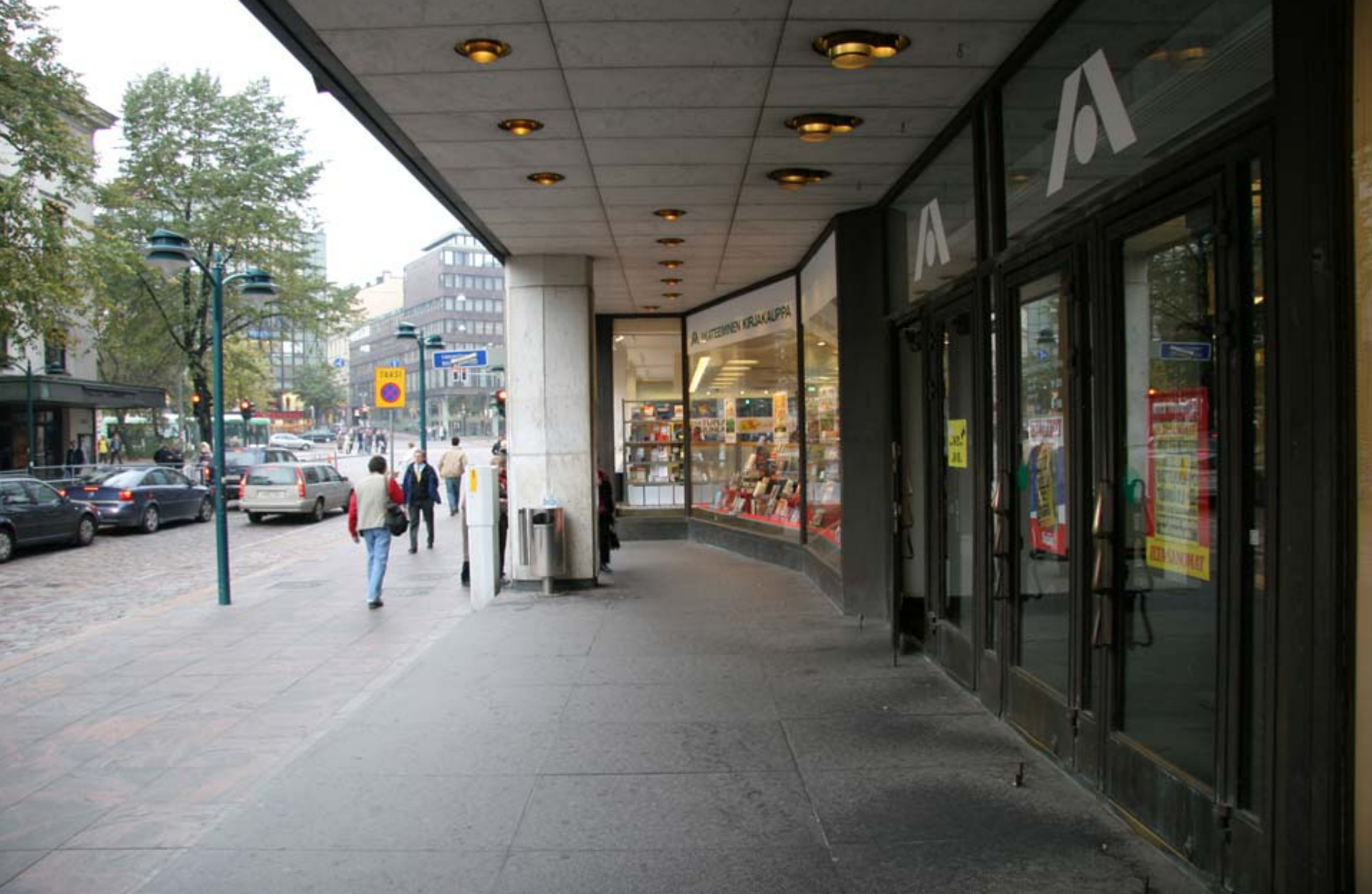
2. Portaista puuttuvat käsijohteet eikä niissä ole minkäänlaista kontrastia. Portaiden hahmottaminen on vaikeaa, vaikka näkö olisi normaali. (Pohjoisesplanadi)
