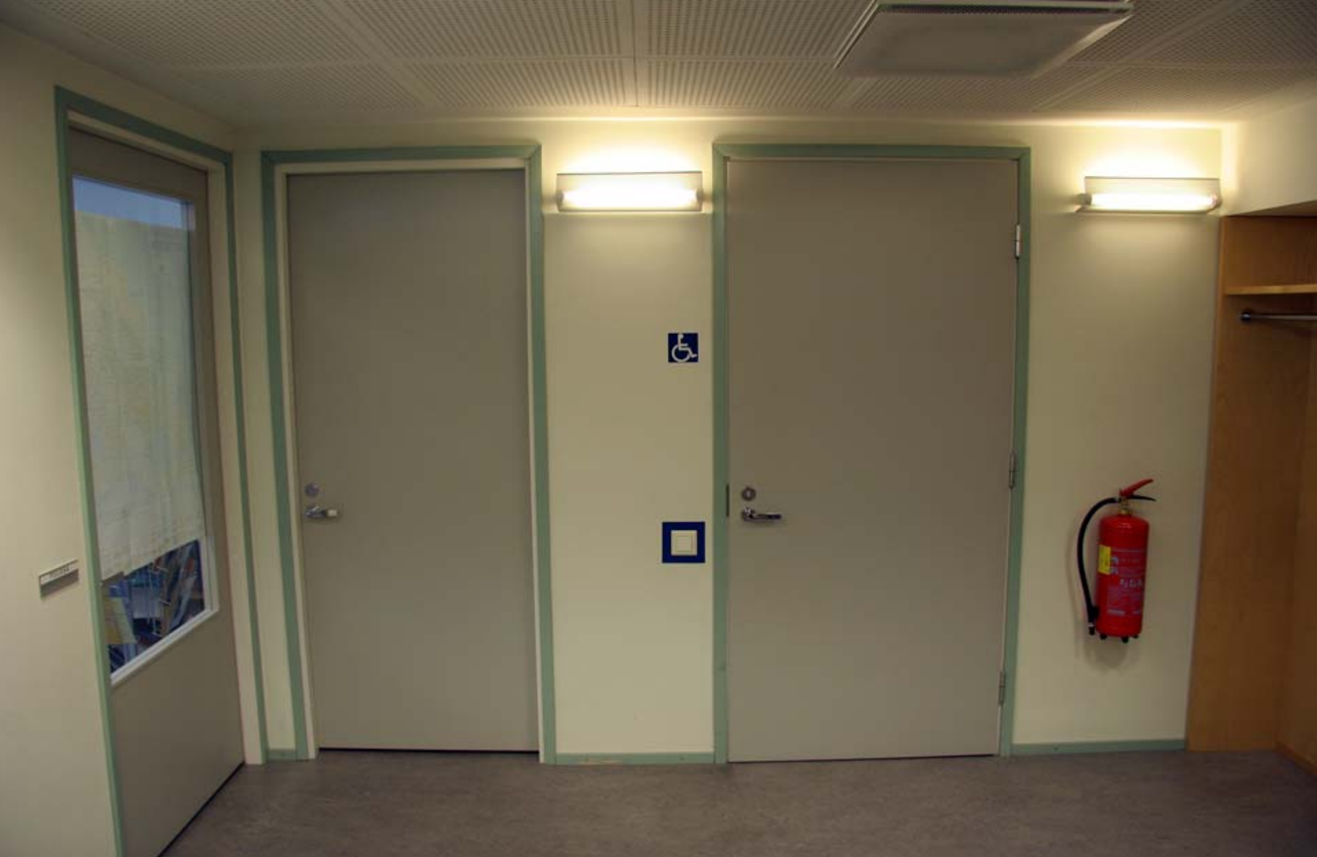
17. Opaste erottuu taustastaan kontrastin avulla. Myös sähkökatkaisija löytyy helposti kontrastimerkinnän ansiosta. (Kuortaneenkatu 13)
