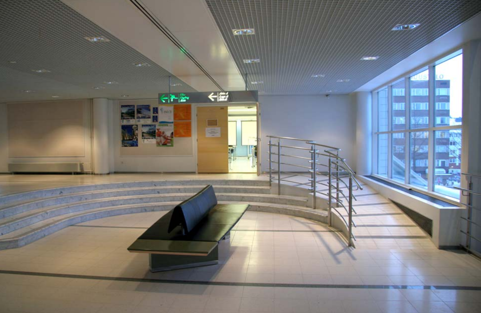
11. Luiskan tulisi olla kulkusuuntaan suora. Kaarevalla luiskalla joutuu tekemään jatkuvasti suunnan korjausliikkeitä. (Tampere-talo)
