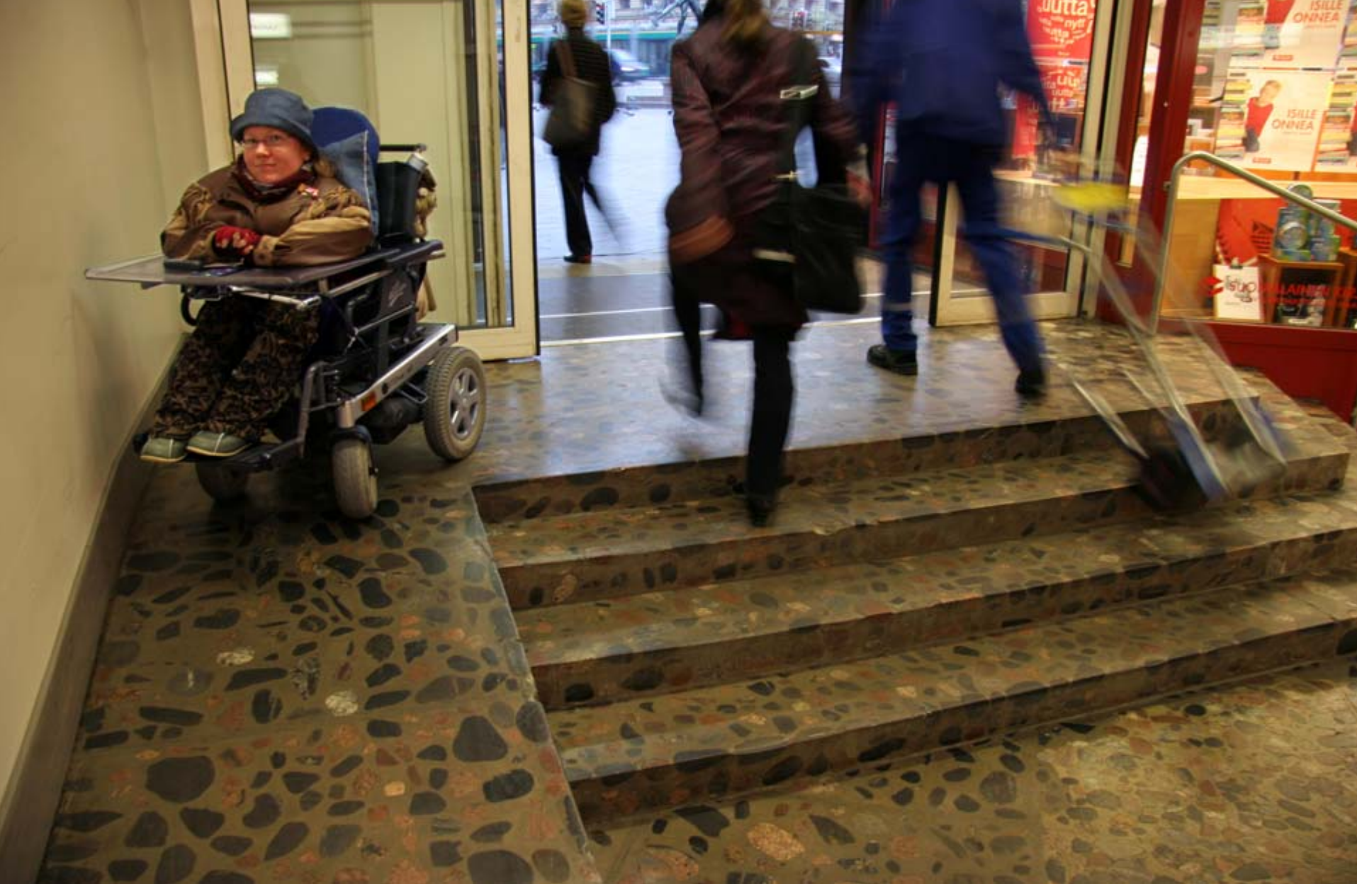
13. Tämä luiska on erittäin vaarallinen. Se on liian kapea ja käsijohteet puuttuvat. Lattian, luiskan ja portaiden kuviointi vaikeuttaa tasoerojen hahmottamista. (City-käytävä)
