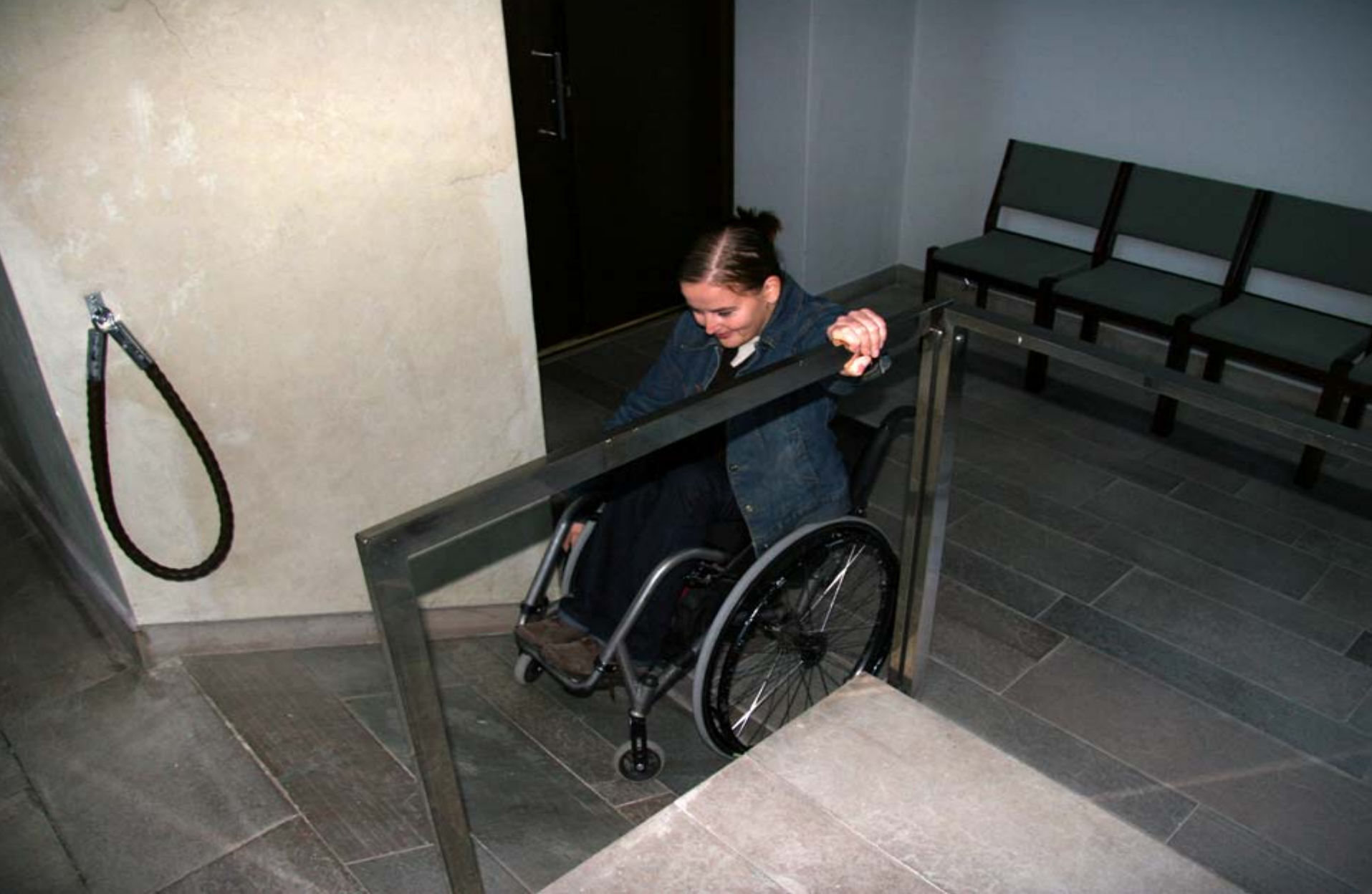
15. Aina ei ole tilaa tehdä oikein mitoitettua luiskaa. Tämän käyttökelvottoman aivan liian jyrkän luiskan sijasta tasoero tulisi hoitaa nostotasolla. (Agricolan kirkko)
