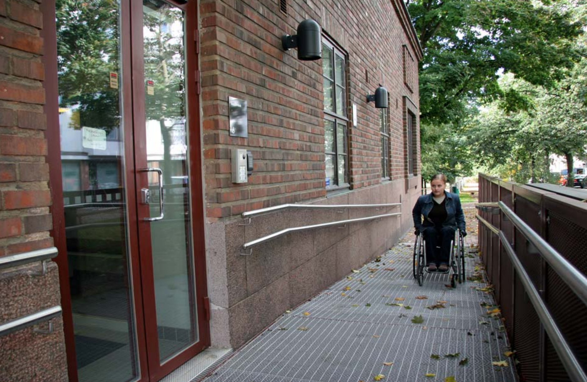
8. Kirkon sisäänkäyntiin johtava luiska on verkkolevyä. Jos luiskan leveys on 1800 mm, kaksi pyörätuolia mahtuu kohtaamaan. (Agricolan kirkko)
