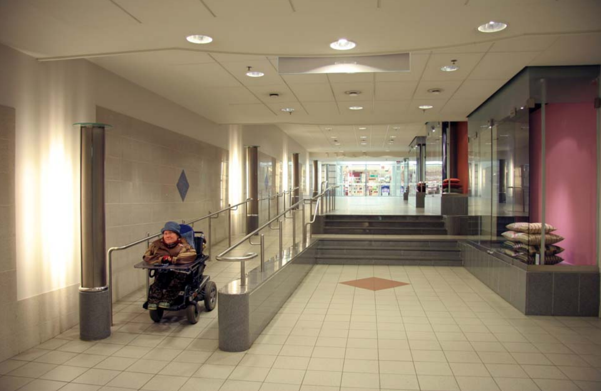
5. Luiska vaatii enemmän tilaa kuin porras. Lyhyen luiskan vähimmäisleveys on 900 mm. (Yhdyskäytävä Forumista Stockmannille)
