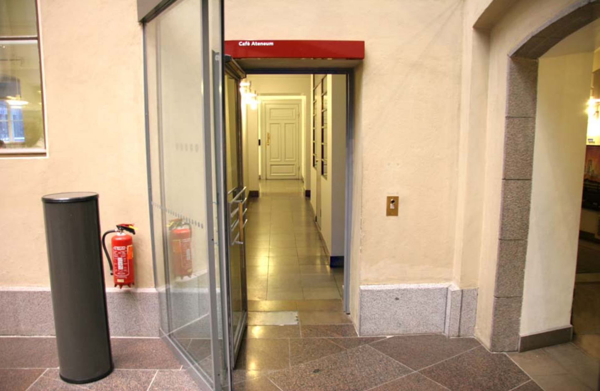
7. Sisääntuloaulan ja kahvilan välinen tasoero on saatu esteettömäksi kun kahvilaan johtava lyhyt käytävä on suunniteltu luiskaksi. (Ateneum)
