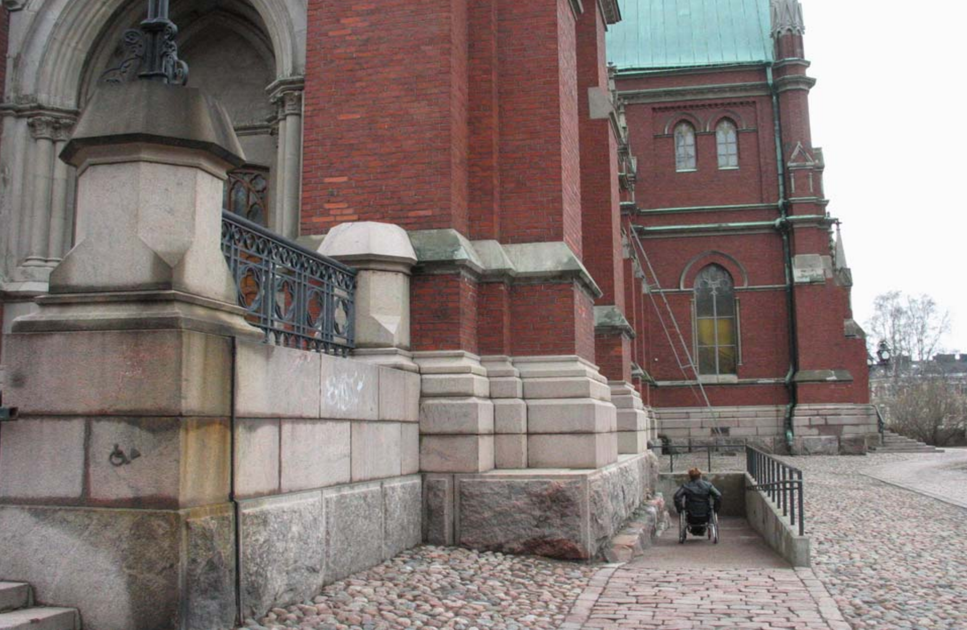
3. Luiska johtaa alaspäin kirkon uuden kryptan tasoon. Luiska on lämmitetty ja viemäroity, jotta se toimisi myös talviolosuhteissa. (Johanneksen kirkko)
