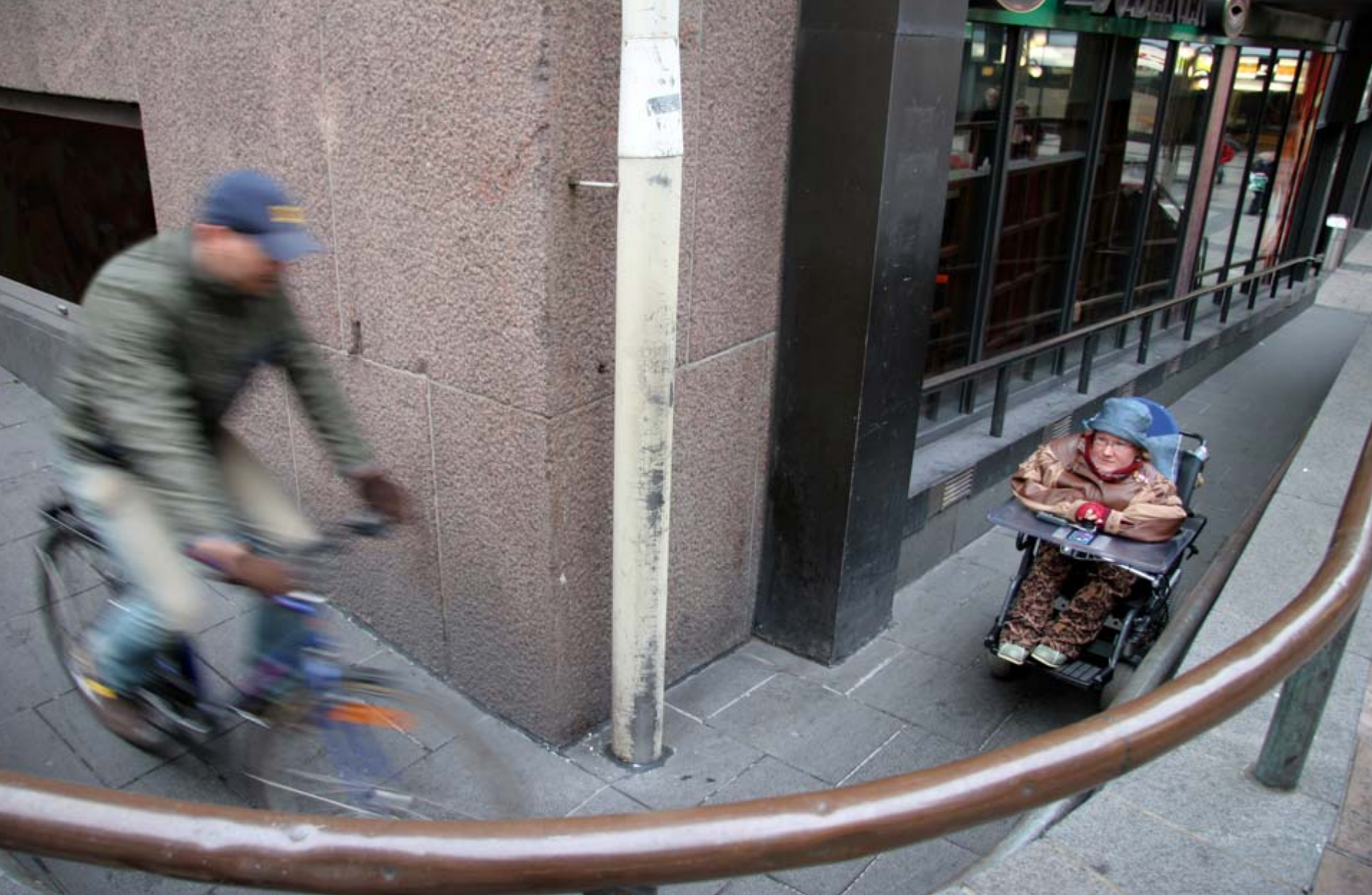
9. Tällä luiskalla ei kaksi pyörätuolia mahdu kohtaamaan. Tilanteen tekee vaaralliseksi se, ettei luiskan alkupäästä näe sen toiseen päähän. Pyörätuolilla peruuttaminen luiskaa pitkin on lähes mahdotonta ilman apua. (Kaivopiha)
