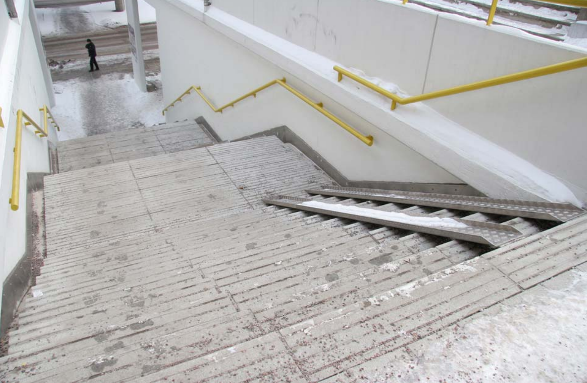
16. Portaan jyrkkyydessä olevat kiskot ovat vaaralliset ja käyttökeltottomat liikkumisvammaisille henkilöille. Näkövammaisille ne aiheuttavat tapaturmavaaran. (Itä-Pasila)
