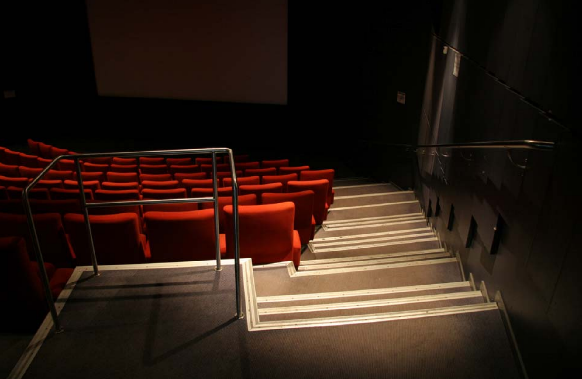
4. Katsomon takaosassa on pyörätuolipaikat. Tummissa portaissa on vaaleat kontrastit ja hyvä yhtenäinen käsijohde. (Kinopalatsi)
