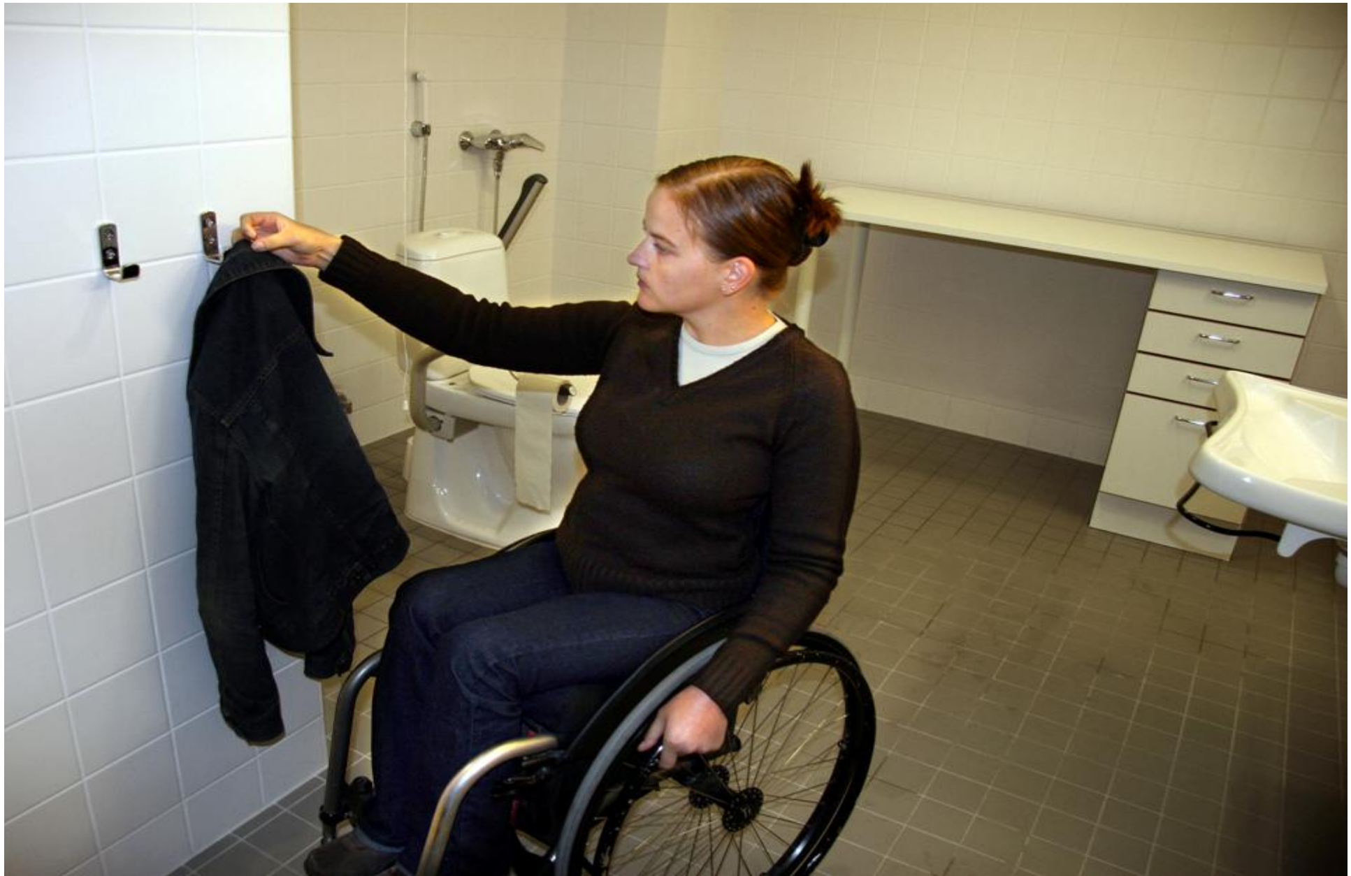
14. Hygieniatilan vaatekoukkuja tulee asentaa sekä pyörätuolin käyttäjän ulottuville noin 1100 mm lattiasta että normaalikorkeuteen noin 1600 mm lattiasta. (Agricolan kirkko)
