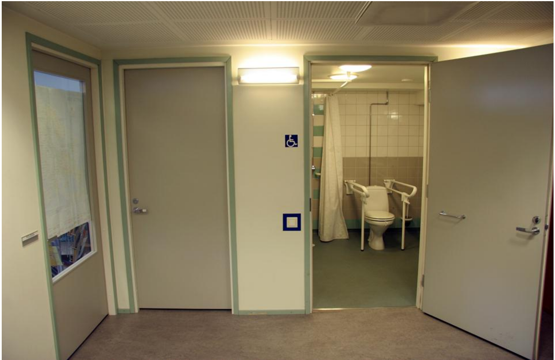
16. Esteettömän hygieniatilan opasteena käytetään kansainvälistä pyörätuolisymbolia joka sijoitetaan silmän korkeudelle 1400–1600 mm lattiasta oven aukeavalle puolelle seinään. Valokatkaisija on varustettu kontrastimerkinnällä. Sen korkeus on 850 mm lattiasta. (Kumpulantie 1)
