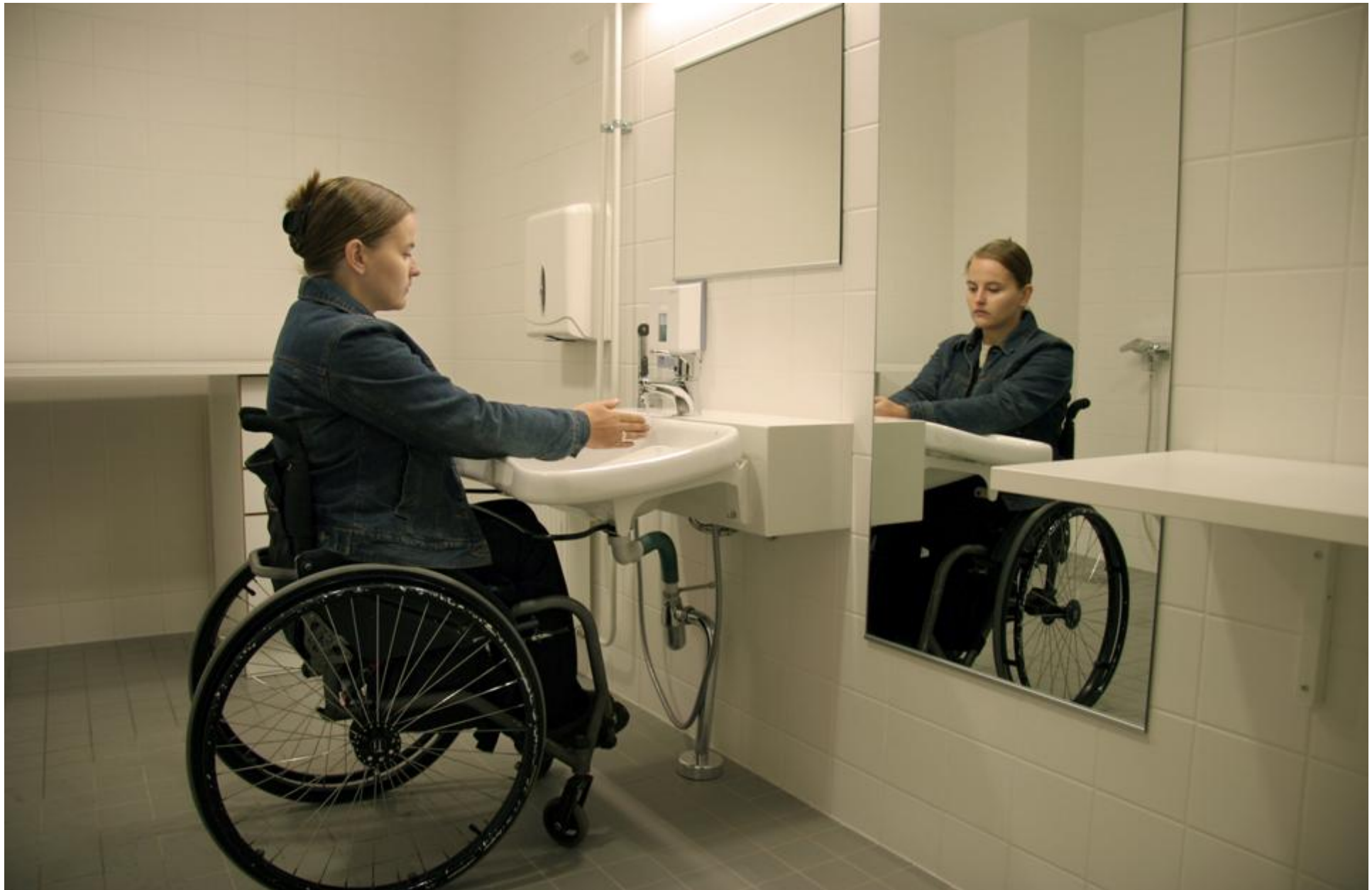
15. Peilistä on sekä istuvan että seisovan ihmisen voitava nähdä itsensä. Kokovartalopeili ei saa ulottua alemmas kuin 300 mm lattiasta. (Agricolan kirkko)
