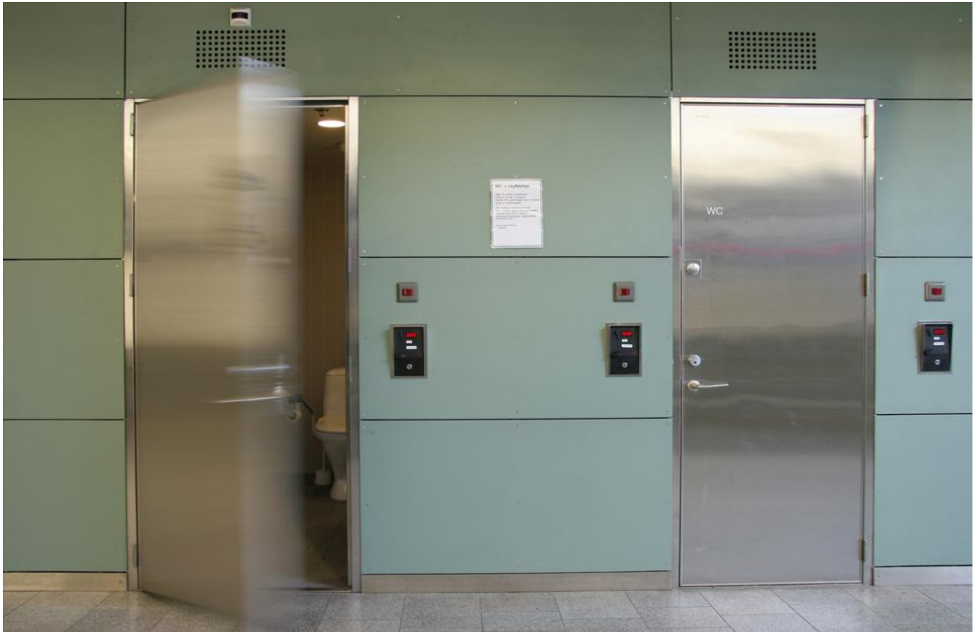
20. Sähköisesti kolikolla avattavan hygieniatilan oven on pysyttävä auki vähintään 25 s. Lukko on voitava avata helposti yhdellä kädellä. (Kampin kaukoliikenneterminaali)
