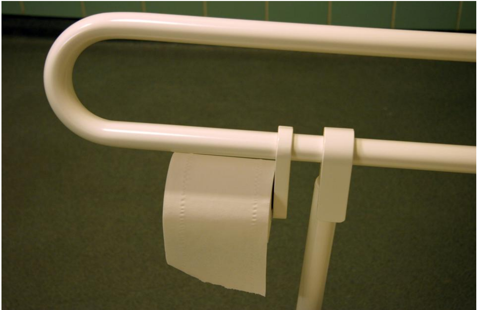
10. Wc-paperirulla voidaan kiinnittää istuimen tukikaiteeseen, jolloin se on hyvin ulottuvilla.
