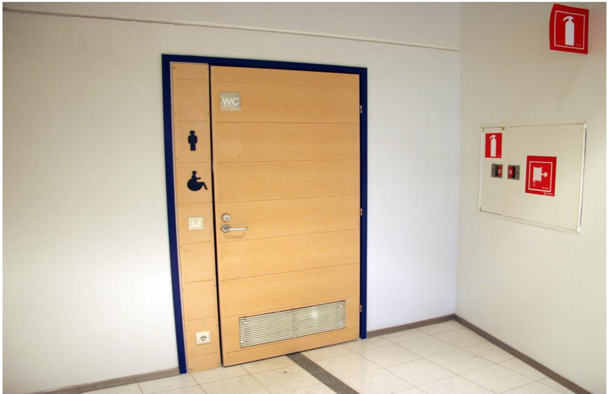
19. Esteettömän hygieniatilan ovele johtaa kontrastimateriaali- ja väiraita. Ovessa ja opasteissa on selkeä kontrasti. Opasteet on sijoitettu oikein ove avkeavalle puolelle sen viereen silmän korkeudelle. Opasteissa tulee käyttää kohokuvioita. (Tampere-talo)
