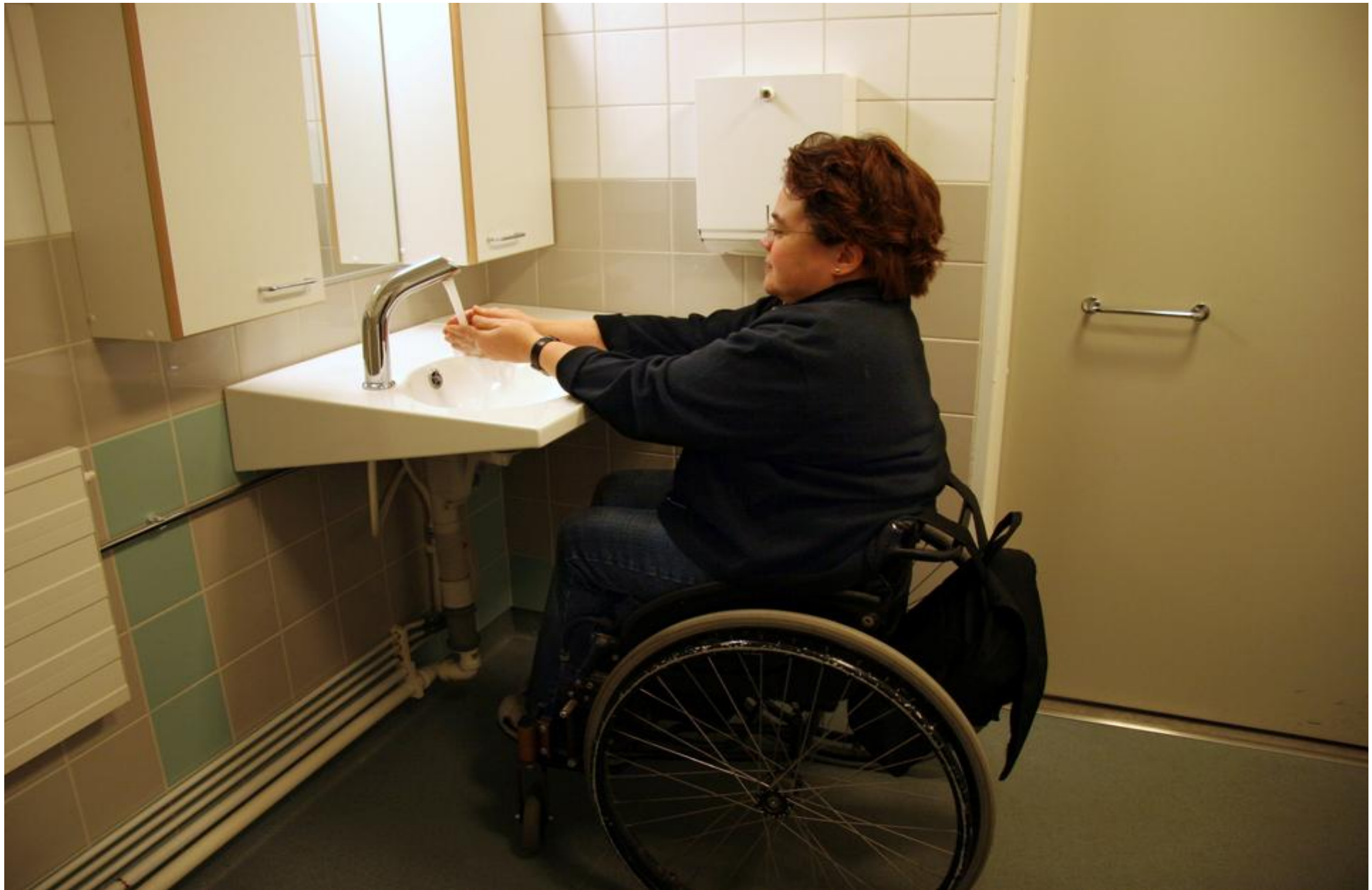
12. Pesuallas asennetaan pyörätuolin käyttäjää varten 750-800 mm:n korkeudelle lattiasta siten, että syntyy riittävä vapaa polvitila sen alle. Pesuallas on asennettu pöytätasoon, joka toimii laskutilana. Vesihana toimii automaattisesti elektronisen "silman" avulla, lämpötila on säädetty sopivaksi ennalta. (Kumpulantie 1)
