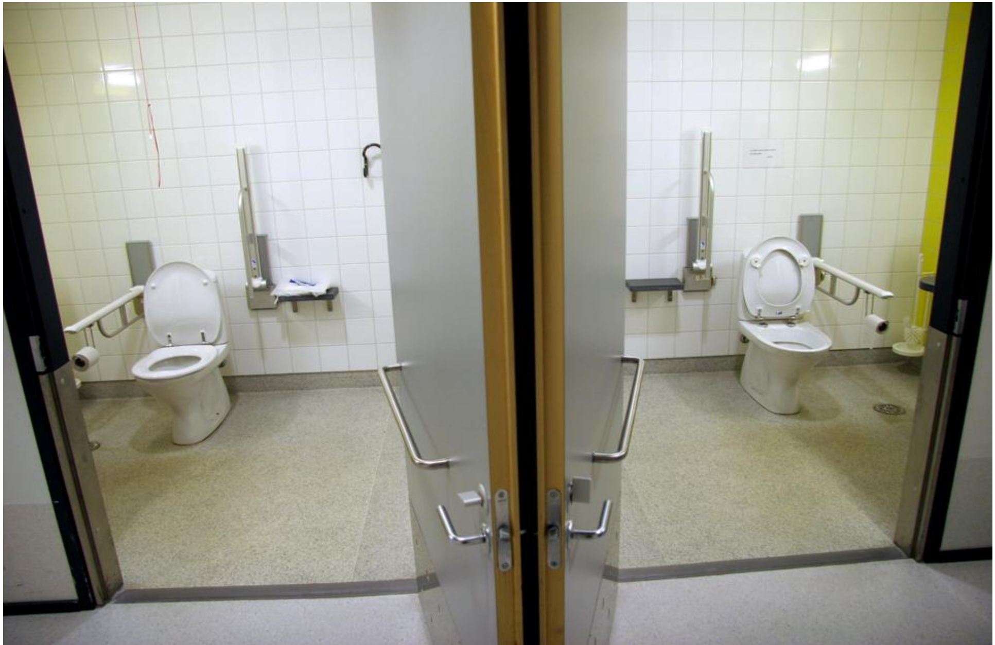
3. Kaksi esteetöntä hygieniatilaa, joissa tila pyörätuolia varten on vain wc-istuimen toisella puolella. Tilojen pohjaratkaisut ovat keskenään peilikuvat. (Synapsia)
