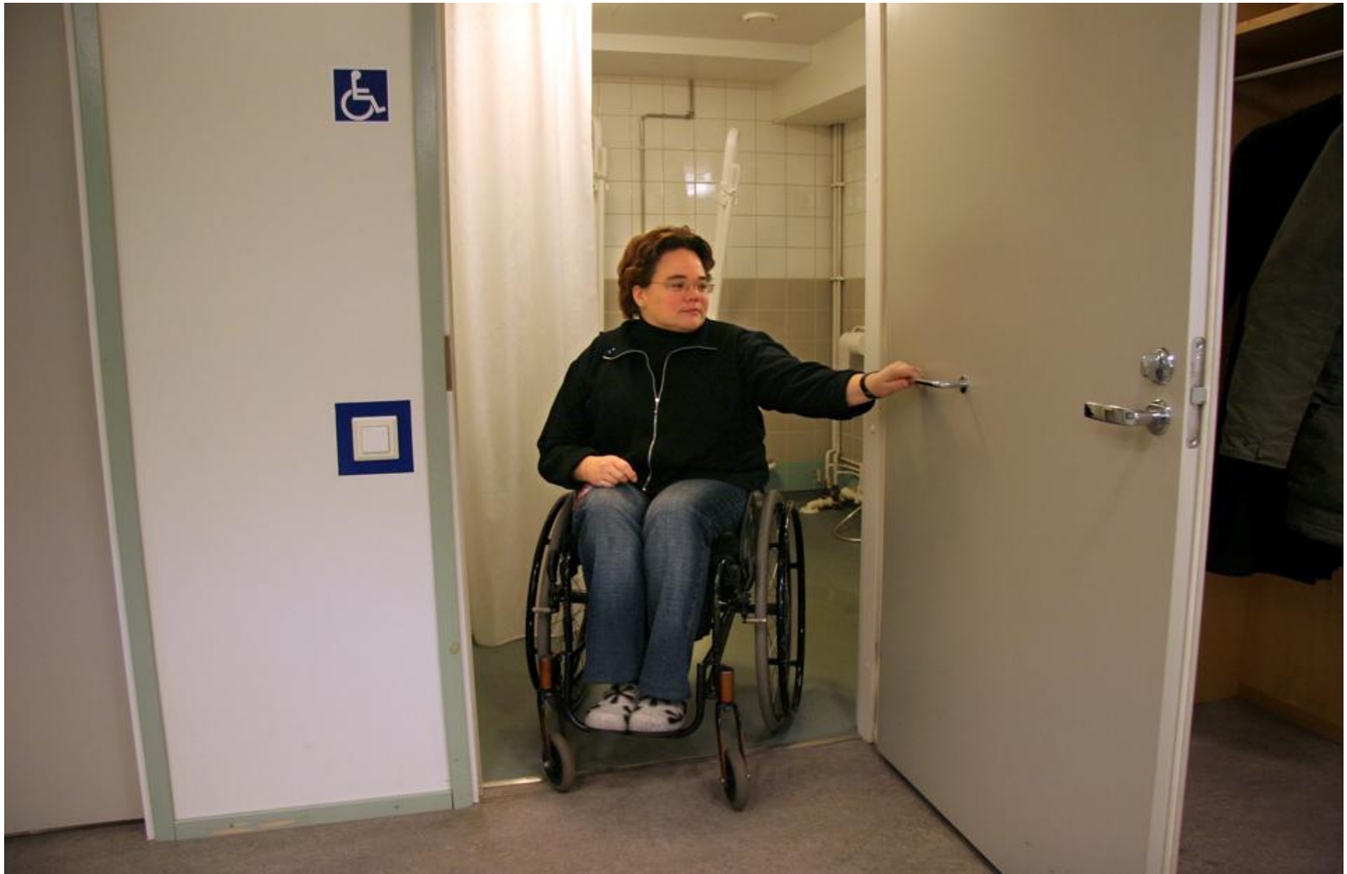
17. Esteettömän hygieniatilan oviaukon vapaa leveys on vähintään 850 mm. Oviaukko on kynnyksetön, ovenssa on laahuskynnys. Oven voi sulkea pyörätuolista, kun saranapuolelle on asennettu lankavedin 800 mm:n korkeudelle lattiasta. (Kumpulantie 1)
