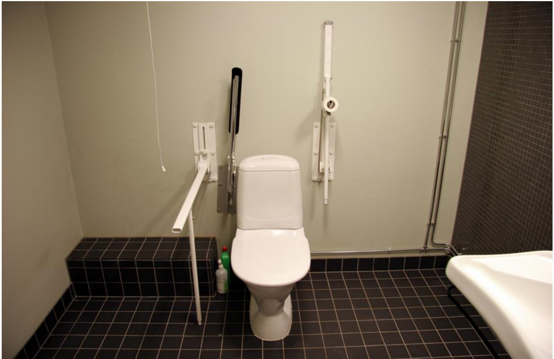
1. Esteettömässä hygieniatilassa on tilaa pyörätuolia varten wc-istuimen molemmin puolin. Tilassa on hyvät kontrastit, vaaleat kalusteet erottuvat hyvin tummaa taustaa vasten. (Aleksanterinkatu 48)
