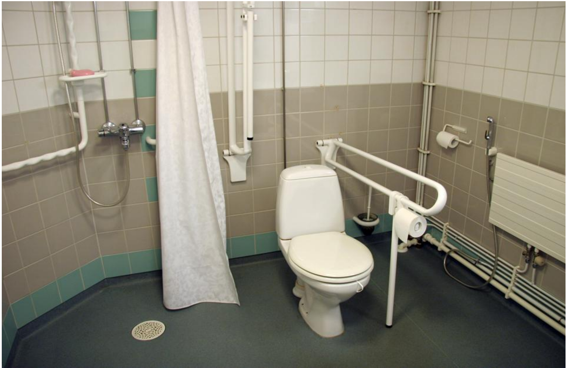
9. Suihkutila voidaan sijoittaa wc-istuimen viereen jos tila on riittävän leveä. Pyörätuolille tarvittavan tilan leveys on vähintään 800 mm, suihkulle puolestaan vähintään 900 mm. Seinälle käännettävät tukikaiteet istuimen molemmin puolin ovat korkeudeltaan 800 mm lattiasta. Tukikaiteiden väli on keskeltä keskelle 600 mm. (Kumpulantie 1)
