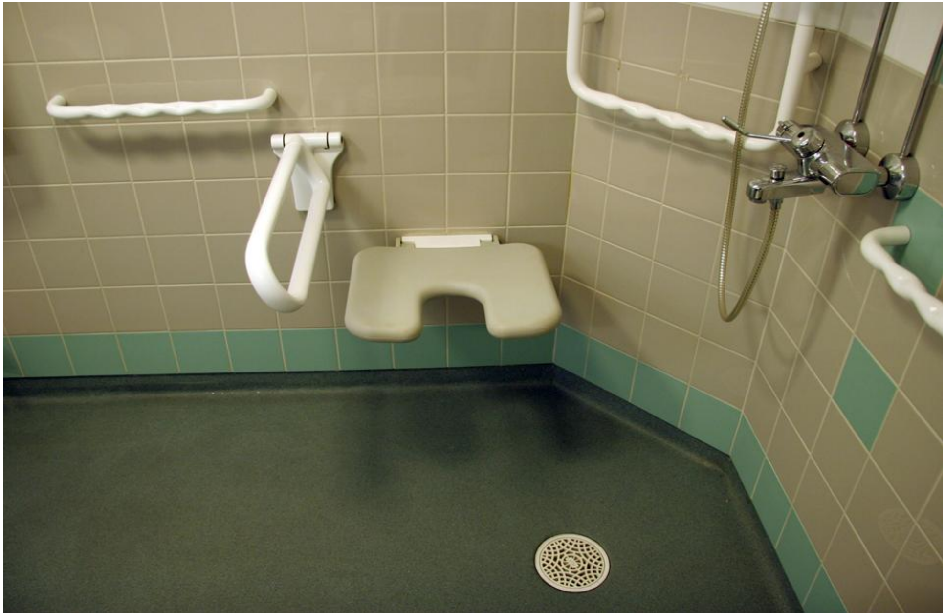
11. Suihkutilaan asennetaan tukikaiteet ja seinältä alas käännettävä suihkuistuin. Valkoiset varusteet erottuvat hyvin taustan väristä. (Kumpulantie 1)
