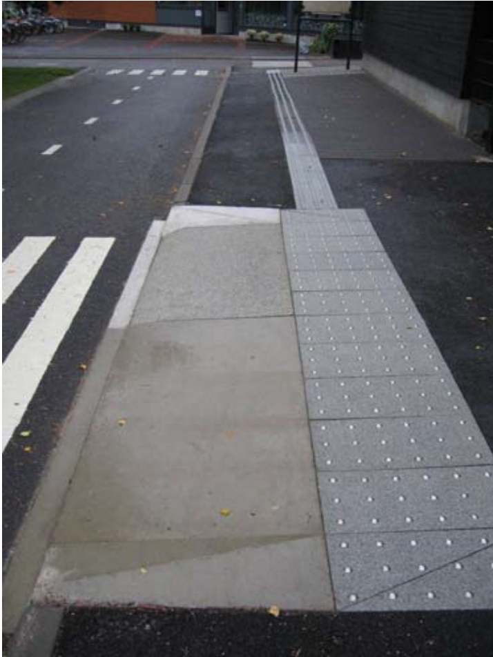
Kuva: Suunta- ja huomiolaatta. Kontrastimateriaali erottuu muusta ympäristöstä. Lähde: Helsinki kaikille -projekti, Anni Juutilainen
