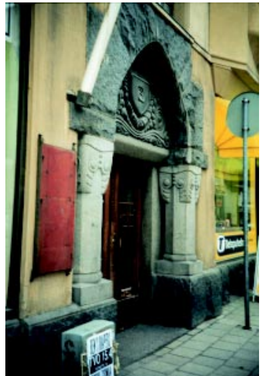
Turku: Sisäänkäynti kadun tasossa.
