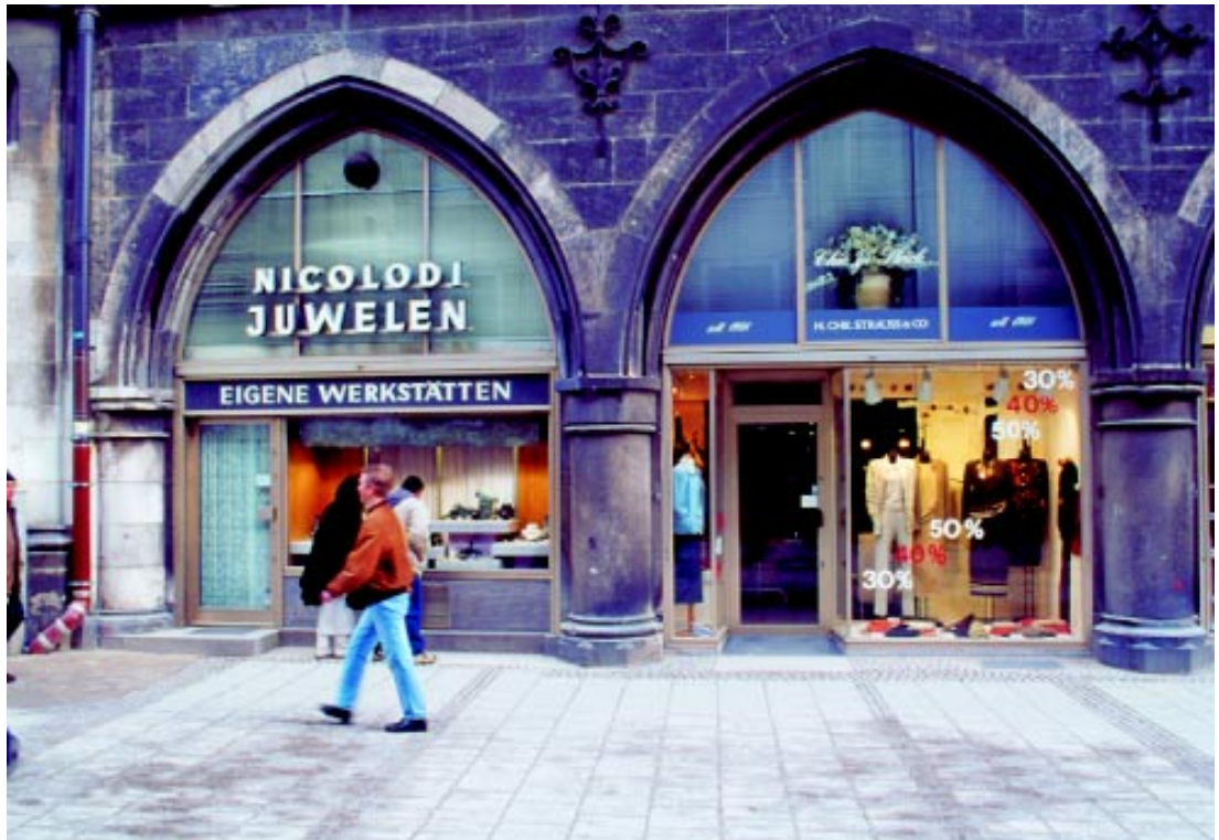
München: Korjaamaton ja korjattu sisäänkäynti. Kuva: Kimmo Rönkä, Rönkä Consulting Oy.
