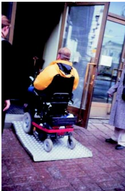
Väliaikaisesti asennettava luiska edellyttää henkilökunnan apua.
