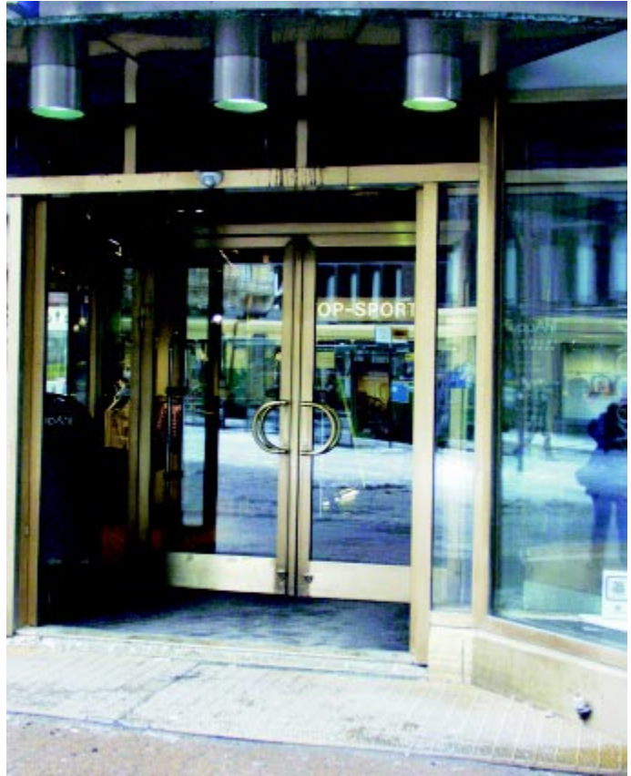
Toteutettu esteetön sisäänkäynti
