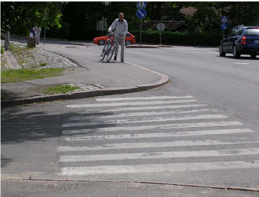
Kuva 14. Tunnelitien suoja- tiessä Ryytimaantien kohdalla on erittäin korkeat reunakivet.
