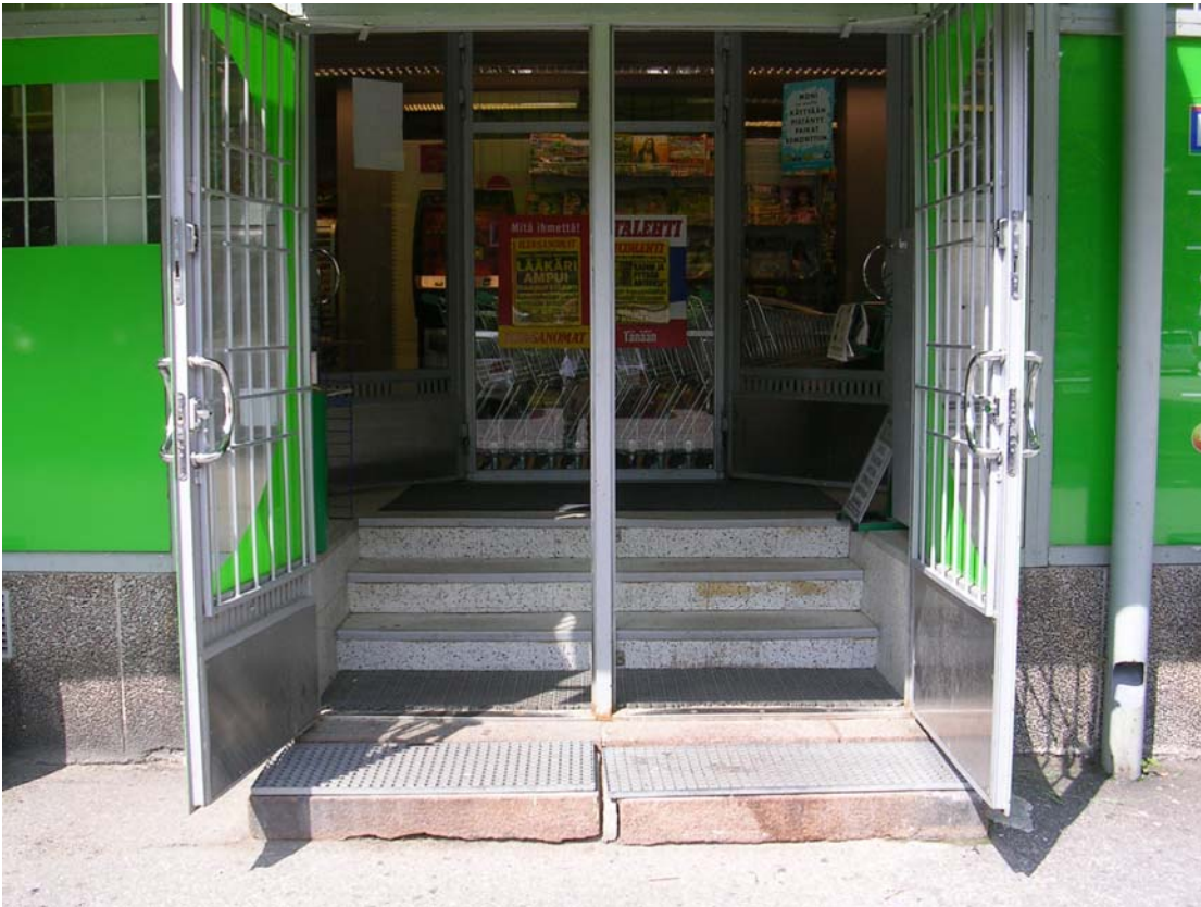
Kuva 22. Thalianaukion liiketilojen lattiat ovat n. 50-70 cm jalkakäytävää korkeammalla.
