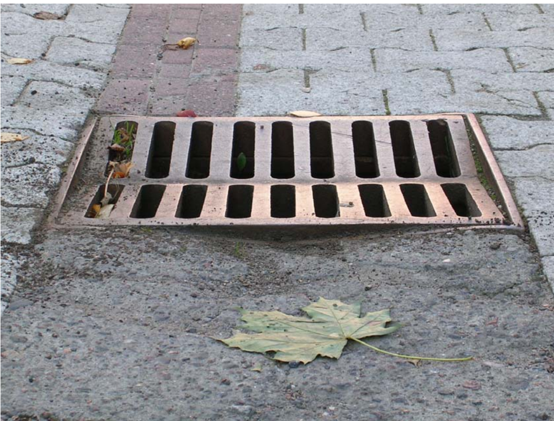
Kuva 20. Hyvin pieni korjaustoimenpide: Vesi menee kaivoon kun ritilää kierretään 90 astetta.
