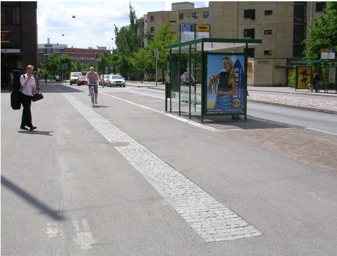
Kuva 17. Kaupintien jalankulun ja pyöräilyn erottaminen sekä pysäkkijärjestelyt Pohjois-Haagan aseman kohdalla on toteutettu esteettömästi.
