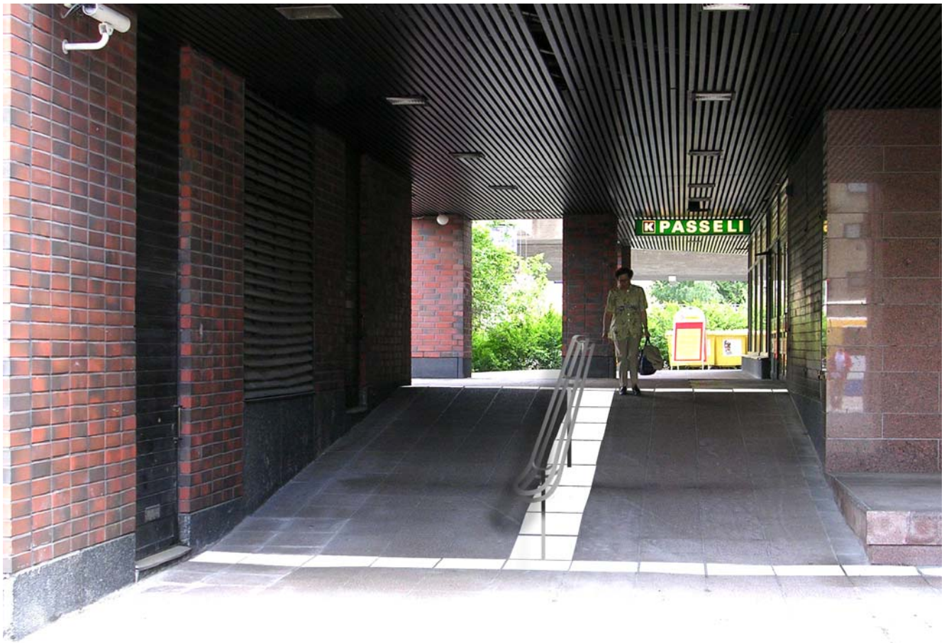
Kuva 34. Aseman ja Kaupintien välisellä reitillä on hämärä, rakennuksen läpi kulkeva osuus. Valokuvassovitteessa on esitetty käsijohteen sijoittaminen ja luiskan merkitseminen vaaleilla laatoilla heikkonäköisen turvallisuutta lisäämään ja toimimista helpottamaan.
