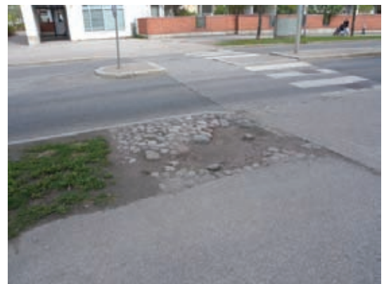
Suojateissä on esteettömyyspuutteita.
