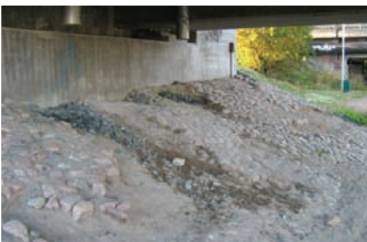
Vuosaaren sillan ja metroradan alikulku on erittäin huonokuntoinen. Tulviminen ja silloilta tulevat hulevedet ovat vaurioittaneet reitin pintaa.
