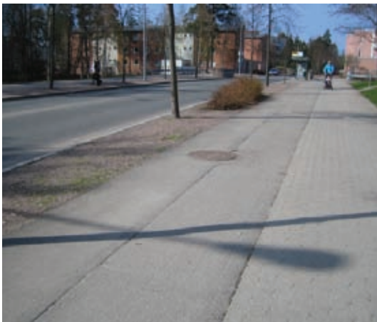
Meri-Rastilan tien puut ovat huonokuntoisia ja istutukset pirstoutuneita. Pinnoite-ero ei ole riittävä jalankulun ja pyöräilyn erottamiseen.
