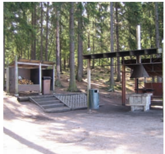
Meri-Rastilan grillikatos kunnostetaan.
