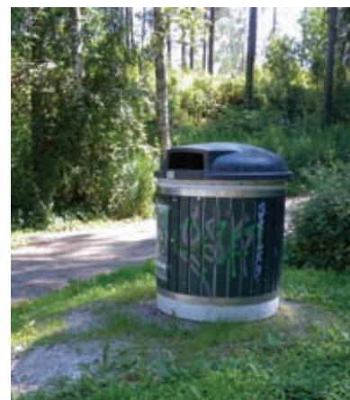
Syväkeräyssäiliöt on muutamassa puistossa asennettu liian korkealle.
