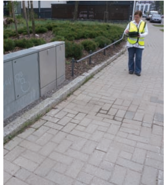
Kunto- ja tarvekartoituksessa arvioitiin silmämää- räisesti katu- ja puistoalueiden kuntoa.
