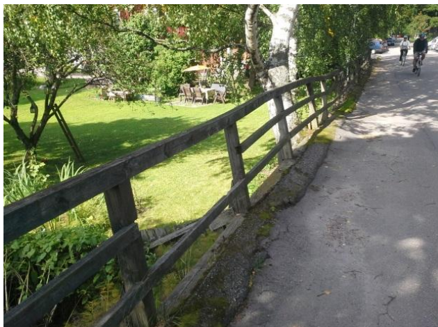
Jyrängöntien tukimuuri on huonossa kunnossa, kadun rakenteet ovat jo vaurioituneet.
