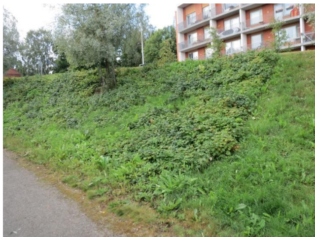
Kustaa Aadolfin puiston rampin luiskassa pensaat täytyy uusia.
