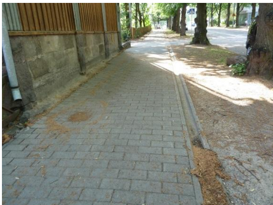
Pohjolankadun jalkakäytävä on peruskorjaustarpeessa.
