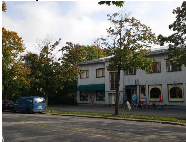
Oulunkyläntien puurivit on uusittava, sitä ennen ne tarvitsevat perusteellisen kuntokartoituksen.
