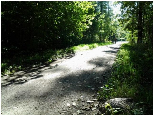
Vallinkoskentie yhteyden peruskorjaustarpeissa.
