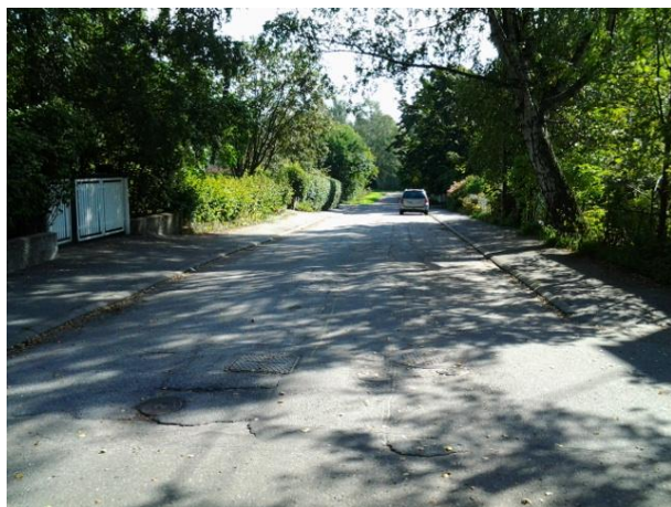
Aavasaksantie on peruskorjettava. Rakenteet ovat sekoittuneet ja katu on menettänyt muotonsa.
