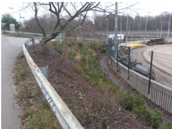
Koskelantien ja Kustaa Vaasan tien liittymässä on huonokuntoista kasvillisuutta.
