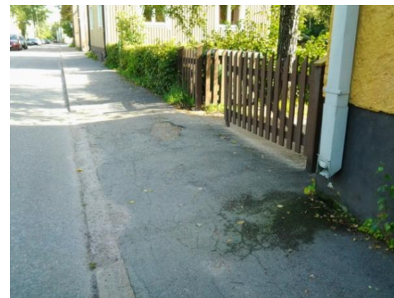
Limingantien suurimpia ongelmia on toimimaton kuivatus.
