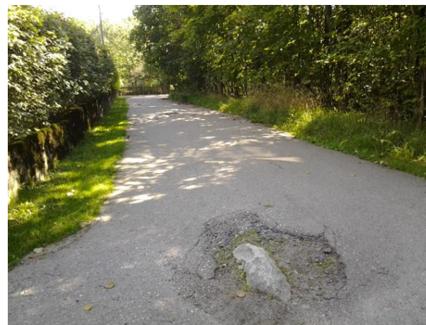
Kymintien loppuosa on hajonnut rakenteisiin jätettyjen kivien seurauksena.
