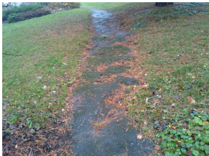
Joukolanpuiston käytävät ovat hyvin huonossa kunnossa.
