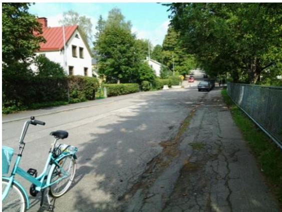
Vipusentien jalkakäytävä on käyttökelvottomassa kunnossa.
