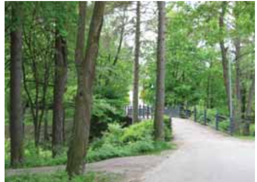
Laajasalon kanava puhkaistiin 1800-luvun loppupuolella. Kanavan yli rakennettu silta on kevyen liikenteen käytössä. Kohde on kulttuurihistoriallisesti merkittävä.
