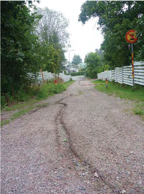
Pahoja vesieroosion jälkiä Ruotsinpyhtääntiellä
