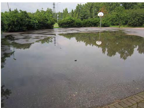
Leikkipaikan koripallokentällä on vakava kuivatusongelma.
