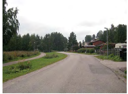
Varjakanvalkama on leveä, Vartiokylänlahden rantaviivan suuntainen katu. Katu on painunut eteläpäässä.
