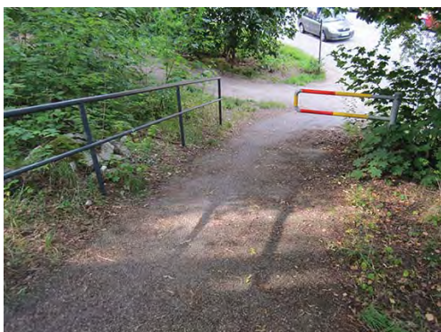
Pohjoisrinteen käsijohde ei täytä esteettömyyden perustason vaatimuksia.
