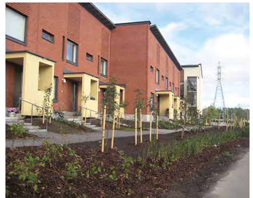
Fallpakan osa-alue on osittain vielä rakenteilla..
