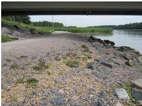
Vuotien alituskohdan yleisilme on kokonaisuudessaan jäsentymätön ja epäsiisti.
