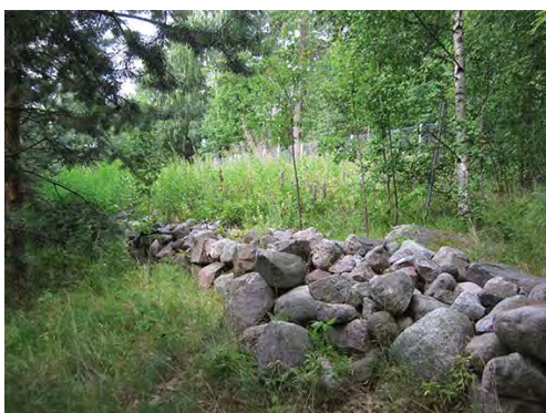
Juorumäen eteläreunaa kiertää vanha kivimuri, joka on osittain sortunut. Kuvassa hyväkuntoista muuria metron huoltotunnelin suoja-alueelta.
