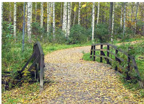
Kurkimoisionpuistossa on useita siltoja ja muutamia rumpuja purojen ylityskohdissa. Sillat ovat yhtä poikkeusta lukuun ottamatta puukantaisia.
