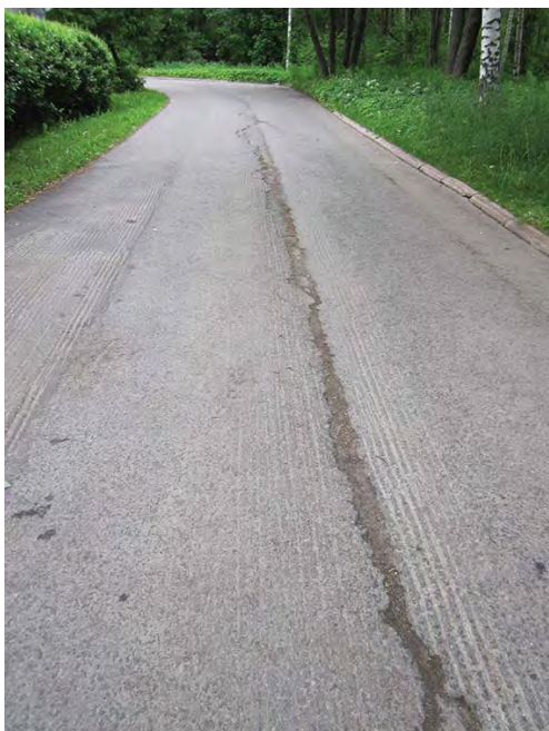
Varjakanvalkaman pinnassa on pitkittäissuuntaisia halkeamia. Kadun pinta on painunut putkilinjojen ympäriltä.
