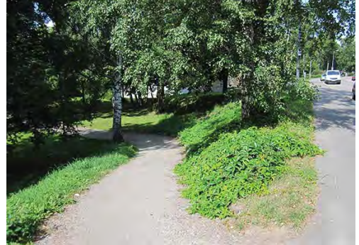
Puotilantieltä Puotilan leikkimäelle johtava käytävä on jyrkkä. Käytävän vieressä ei ole käsijohdetta eikä kaidetta.
