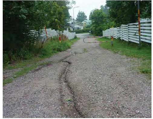
Vartioharjun osa-alueella on kaksi sorakatua, Jallintie ja Ruotsinpyhtääntie. Sorakaduilla saate aiheuttavat eroosiota.
