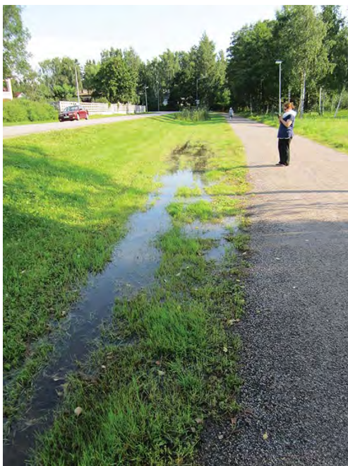
Hulevedet ja Vartiokylänlahti tulvivat usein käytävälle. Vesi seisoo Varjakanvalkaman ja puistokäytävän välisellä viherkaistalla pitkään.
