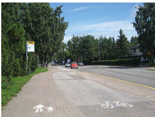
Puotilan osa-alueella, Rusthollarintiellä jalankulkualue on erotettu pyörätiestä harmaalla betonikivellä. Materiaaliero ei ole esteettömyyden kannalta riittävä. Betonikivi on myös ristiriidassa ympäristön yleisilmeen kanssa. Alueelle sopisi paremmin isokokoinen betonilaatta tai -kivi.
