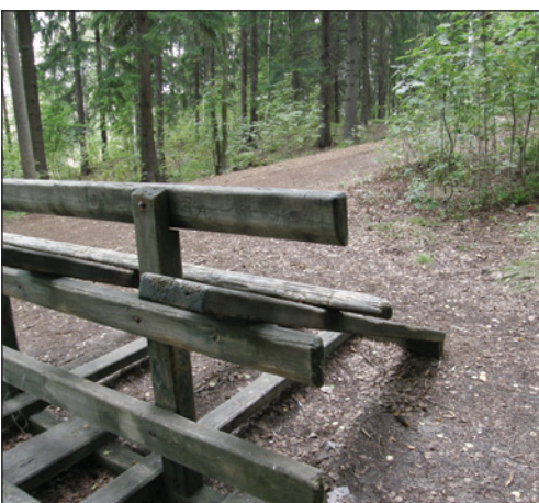
Karjuniityssä on pururata ja muutamia kuntoiluvälineitä.
