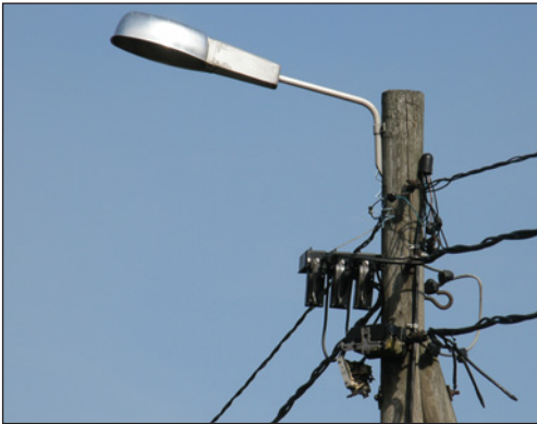
Alueella on yhä runsaasti ilmajohtolla varustettuja puupylväitä.
