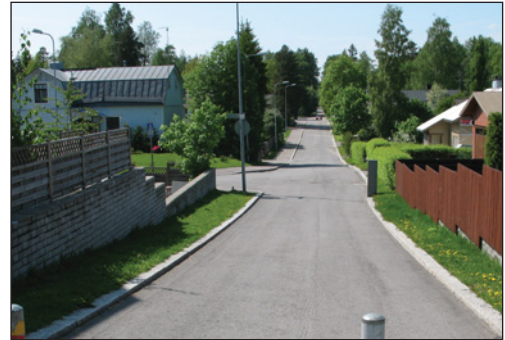
Tarkastelualue on pääosin pientalovaltainen. Kuva Sapilastieltä.
