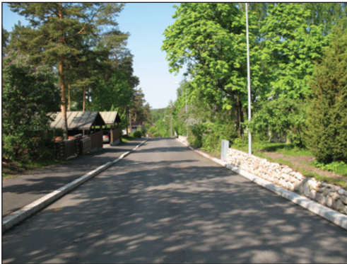
Kalliotie Heikinlaaksossa on peuskorjattu 2010.
