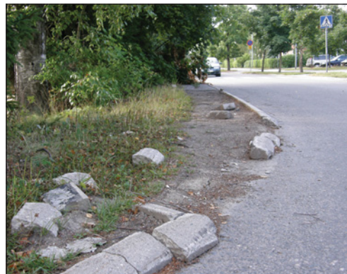
Irronneita reunakiviä on eripuolilla tarkastelualueetta.
