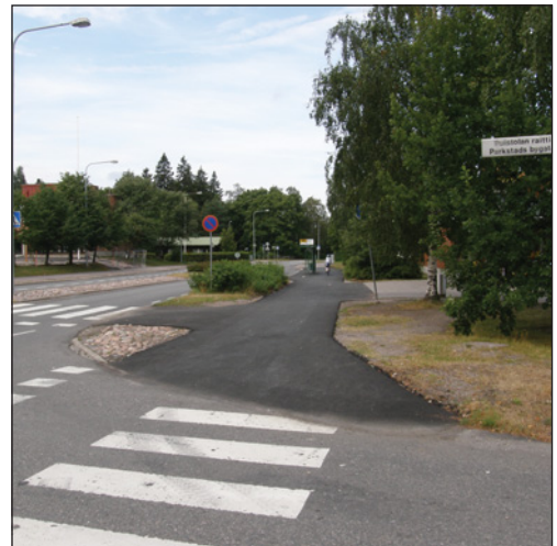
Suojateiden kohdalta puuttuvat usein madalletut reunatuet. Kuva Puistolan raitilta.
