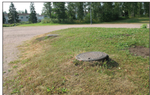
Suuntimopuiston pinnoitteiden peruskorjaus ja tilan jäsentely nostavat sen turvallisuutta ja viihtyisyyttä.
