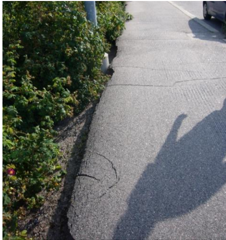
Kuva 34. Hallainvuoren jalkakäytävän reuna on pahoin murtunut.
