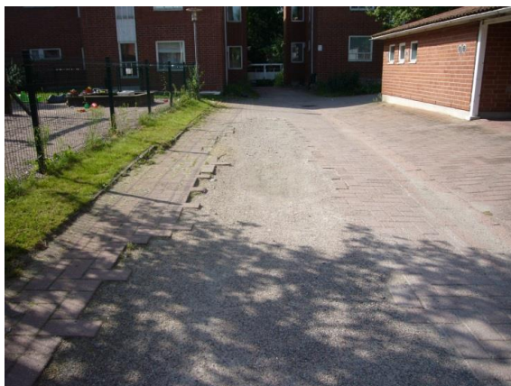
Kuva 35. Myllärintanhuan kiveys rakoilee paikoitellen.
