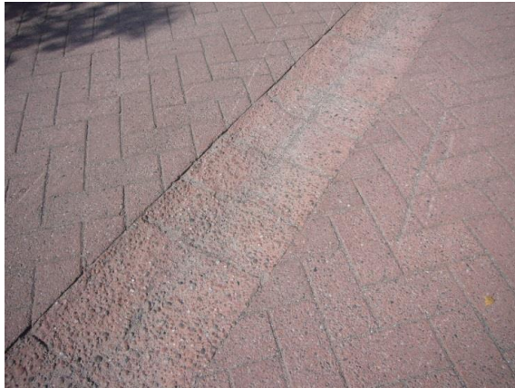
Kuva 36. Kiveykset, reunakivet ja istutuslaatikot ovat kuluneita ja kolhiintuneita.
