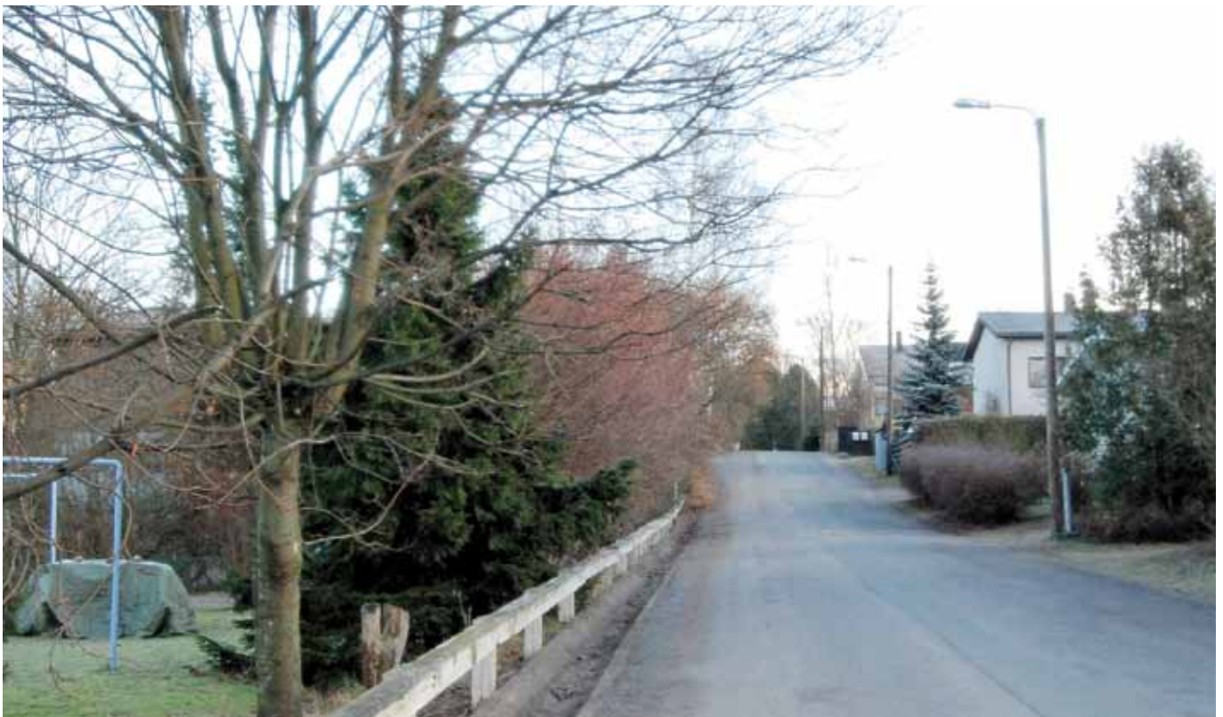
Airuetien puinen ajojohde vaihdetaan teräksiseksi.
