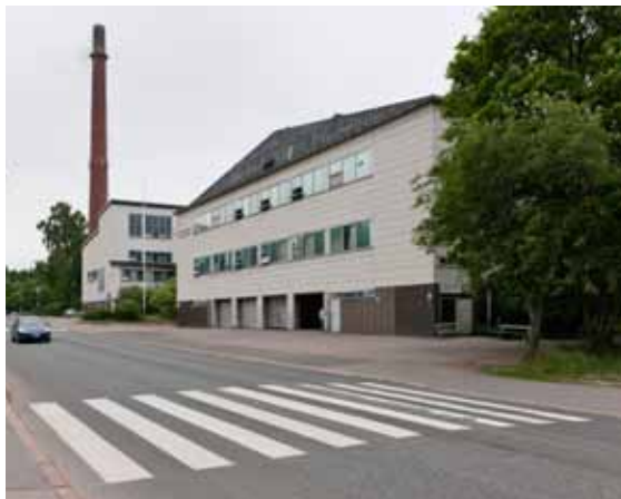
Koskelan sairaalapesula (suunnittelijat Jonas Cedercreutz ja Helge Railo) on kaupunkikuvallisesti merkittävä rakennus ja pesulan lämpölaitoksen savupiippu monelle tuttu maamerkki.
