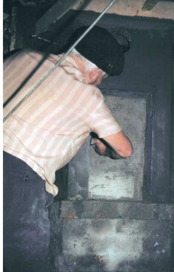
Työläiskotimuseon verastahuoneen uunia muurataan kesäkuussa 1981.
