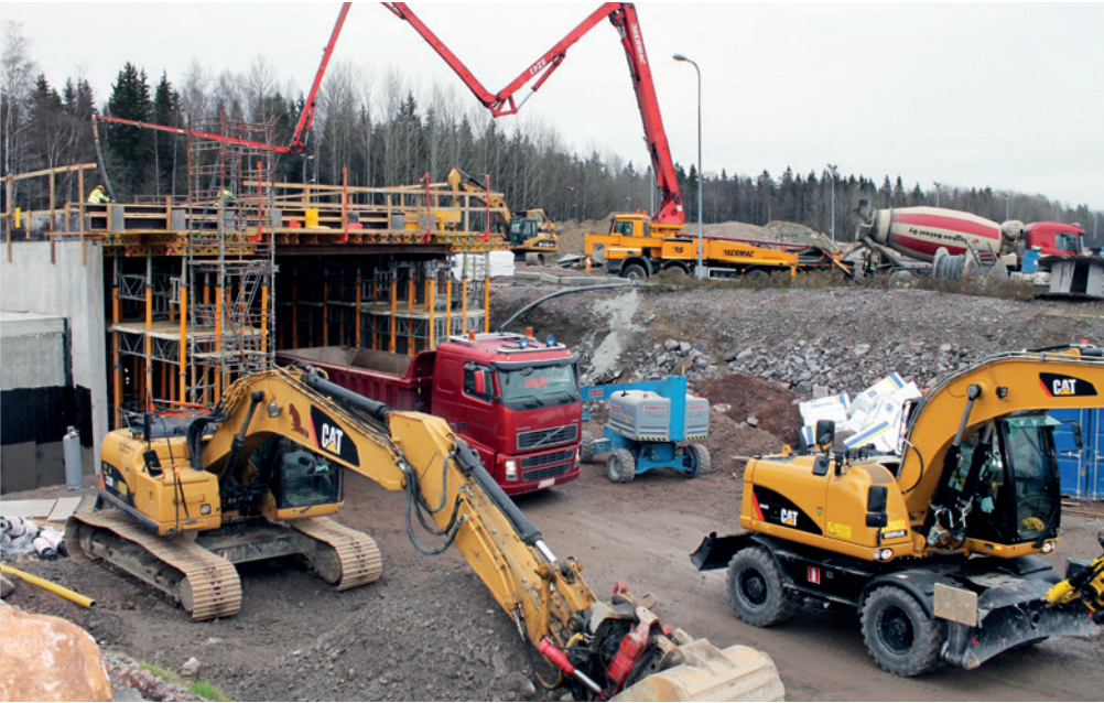
Marraskuussa 2014 Paloheinäntunnelin betonitunneliosuuden seinä- ja kattorakenteita vahvistettiin betonivaluilla.
