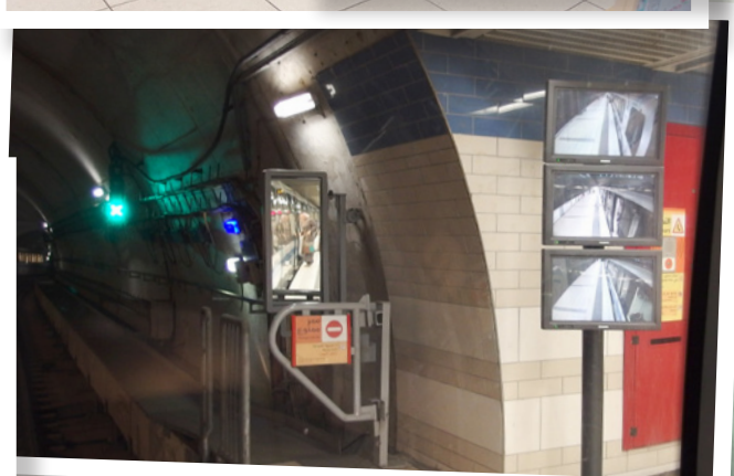
Kuljettajalla on laiturilla apunaan peili ja kolme monitoria, joista kuljettaja pystyy tarkkailemaan aseman turvareunaa sekä junanovia.
