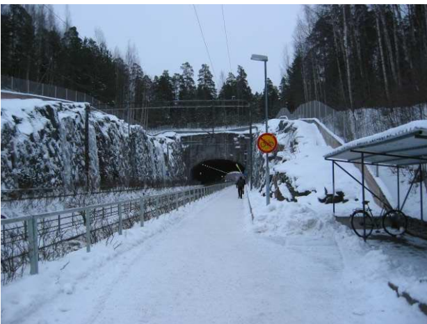
Kuva 39. Asematunnelin suuaukko pohjoisesta.
