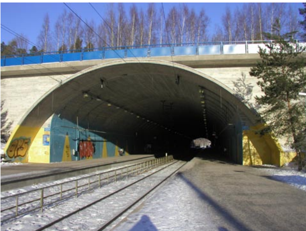
Kuva 38. Asematunnelin suuaukko etelästä.
