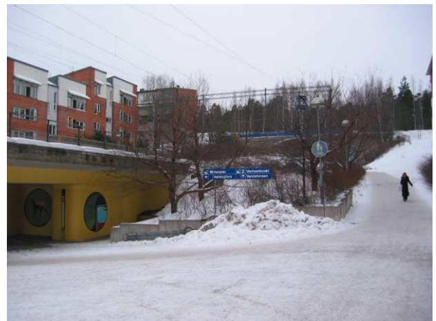
Kuva 42. Kevyenliikenteenväylä asematunneliin ja hyvin toteutettu opastus laiturialueelle.
