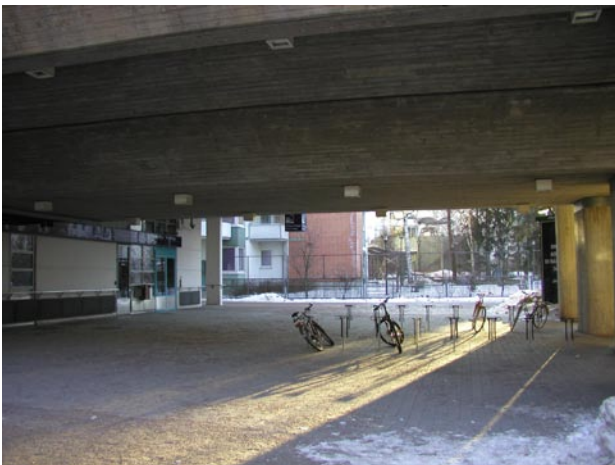
Kuva 22. Sisääntulo asemalle ja polkupyöräpysäköinti.
