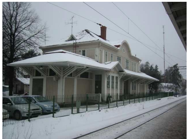
Kuva 9. Vanha asemarakennus sopii hyvin aseman ympäristöön.
