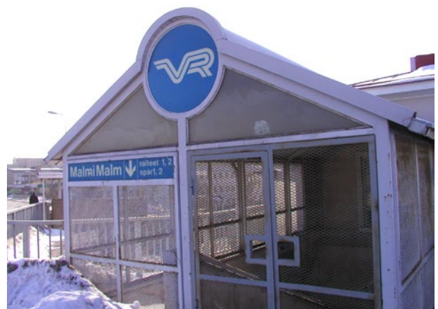
Kuva 53. Vanhat opasteet bussiterminalia vastapäätä (kulku ainakin talvella on estetty).
