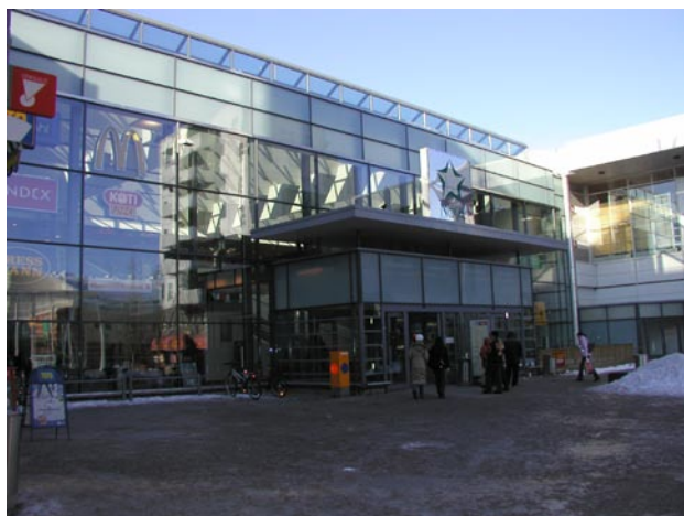
Kuva 56. Kauppakeskus Novan puoleinen pääty. Juna-aseman tunnusta ei ole sisäänkäynnin yhtey- dessä.
