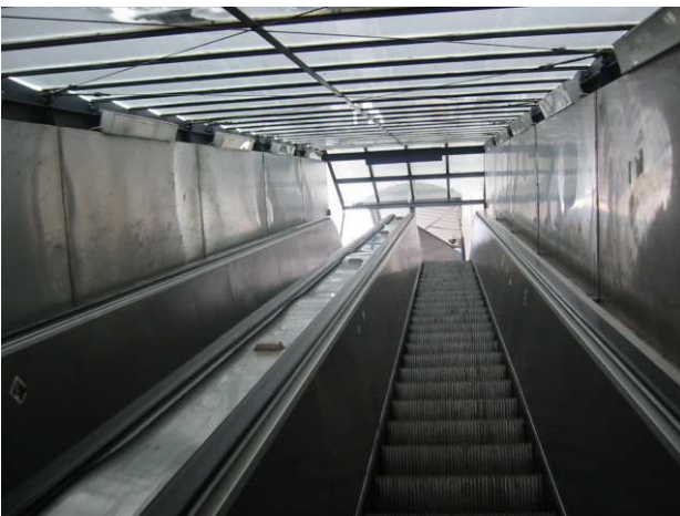
Kuva 50. Aseman liukuportaat ovat usein epäkunnossa.
