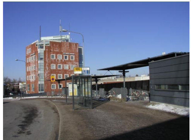
Kuva 52. Ylätasanteen bussiasemalta on sujuva vaihtoyhteys alapuolella oleville laiturialueille.
