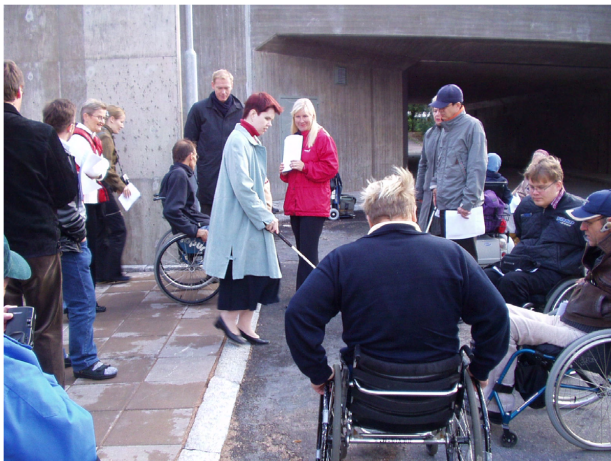
Kuva 4: Suojatien reunatukien koeasennus ja testaustilaisuus Itäkeskuksessa syksyllä 2004.
