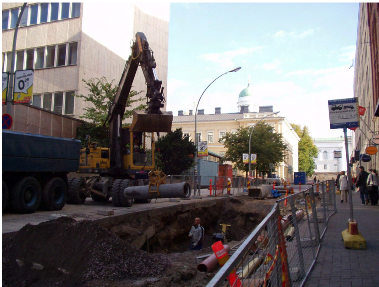
Kuva 7: Yliopistokadun työmaa Helsingissä.
