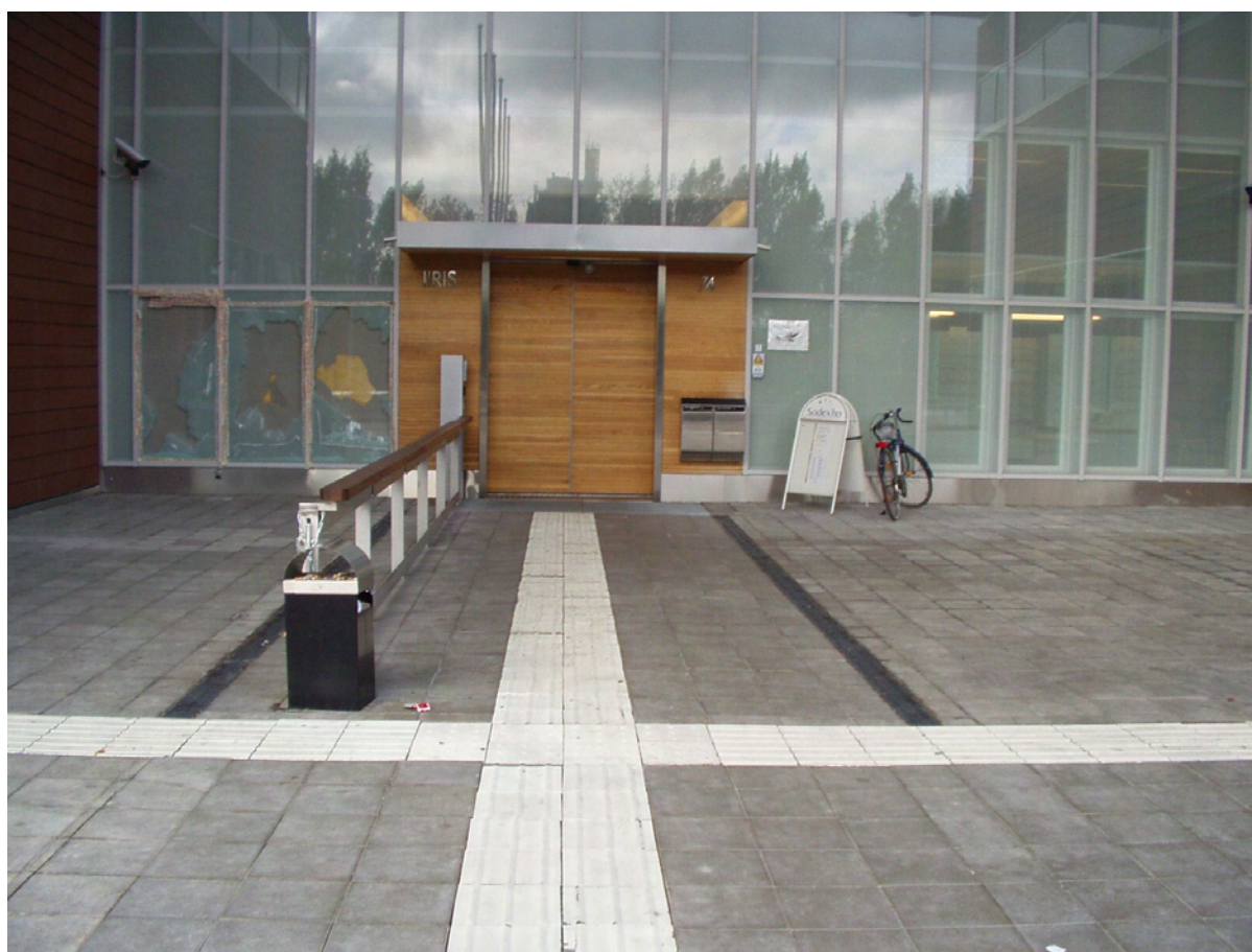
Kuva 2: Näkövammaisten Keskusliiton toimitalo Iriksen ympäristö on vaativaa erikoistason, jossa on erityisesti kiinnitetty huomiota näkövammaisten kulun ohjaukseen.
