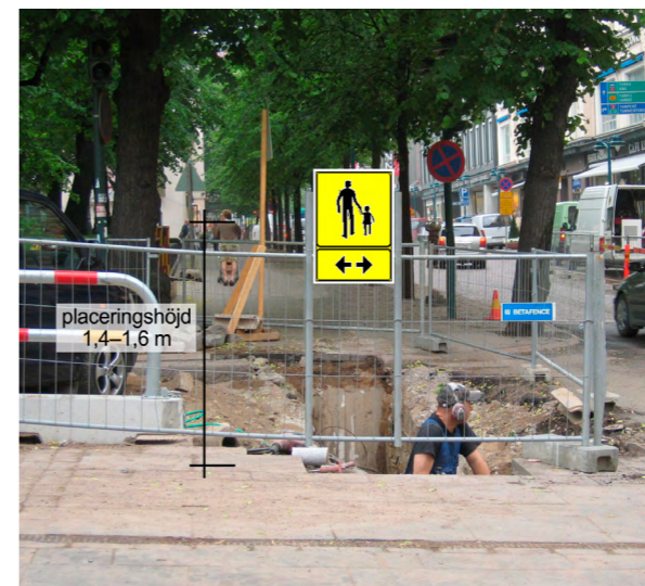
Bild 3. Skylltar skall fästas så att inte fästordningarna medför risk för sammanstötning eller snubbling.
