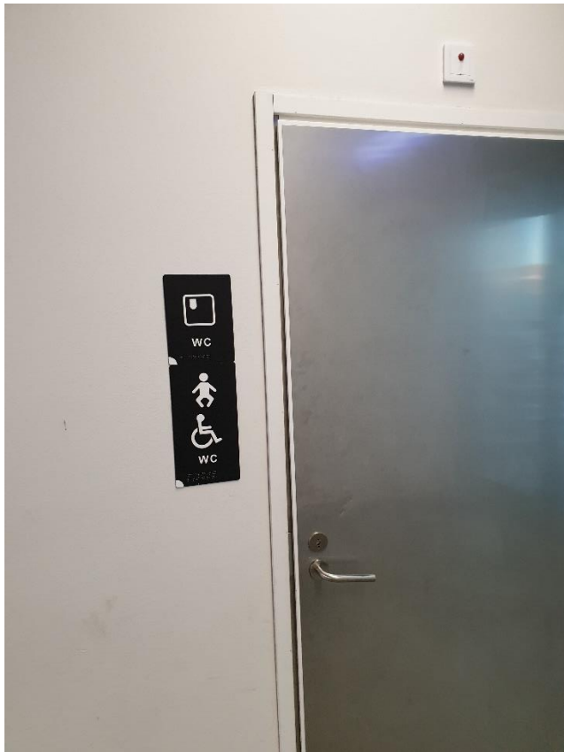
Kuva 14. Esteettömän wc-tilan opaste on toteutettu kohokuviolla (Tripla, Helsinki). Kuva: Riikka Kallio
